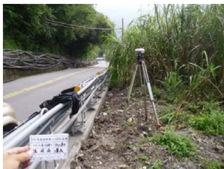
圖 2-7、放樣作業照片
