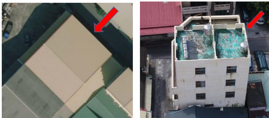
a.斜屋頂-量測屋頂下緣
