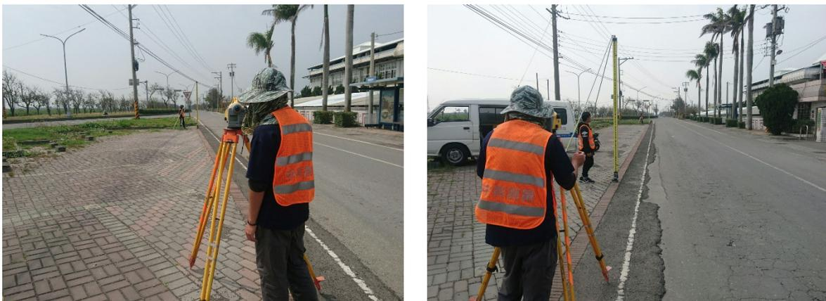
圖 5-3 水準儀視準軸校準情形
