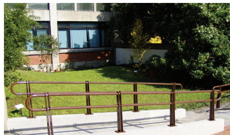
▲無障礙斜坡道
