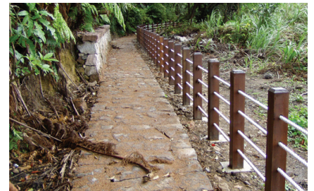
▲生態工程推動-步道乾砌
