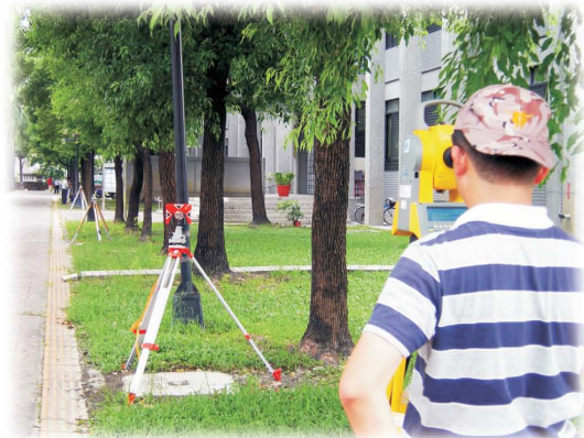
圖5-59 補建屏東簡易電子測距基線場
