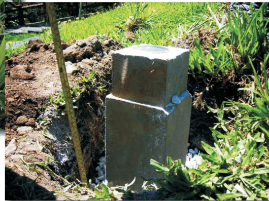
圖5-2 三等控制點標石埋設作業情形
