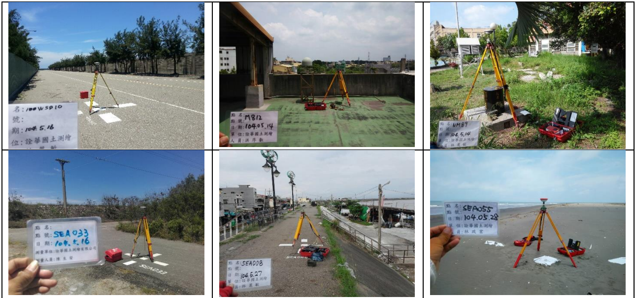
圖 3-5、GNSS衛星定位測量作業情形
