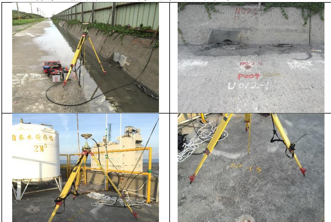
圖 3-90、水深測量GPS固定站架設照片
