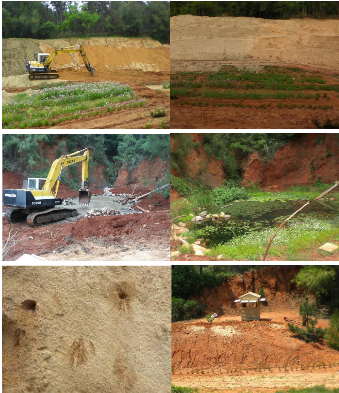
圖 3-1-27 2009 年乳山營巢地工作照片（左上：營巢坡面施工，右上：營巢坡面完成圖，左中：生態池施工，右中：生態池完成圖，左下：人造假洞與爪痕，右下：小木屋搭設）。
