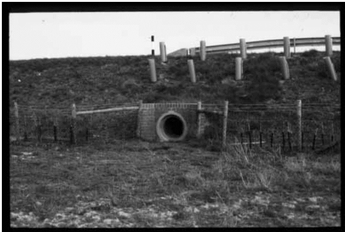
以涵管與動物防護網組成的動物用地下通道設計
