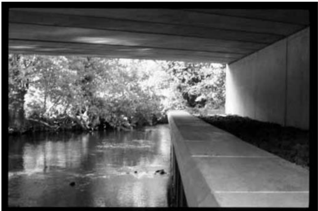
橋樑設計時即內含的水獺用穿越棧道
