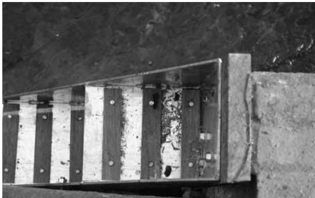
設計給水獺爬越攔砂壩用的樓梯
