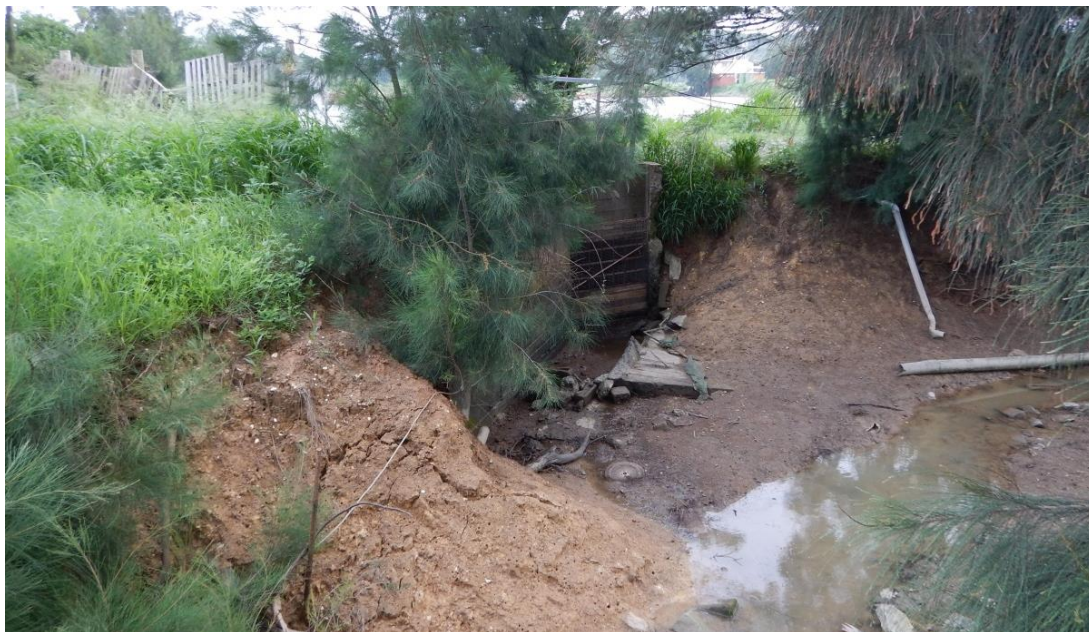
圖 3-5、閘門關閉水道不通，泥沙淤積
