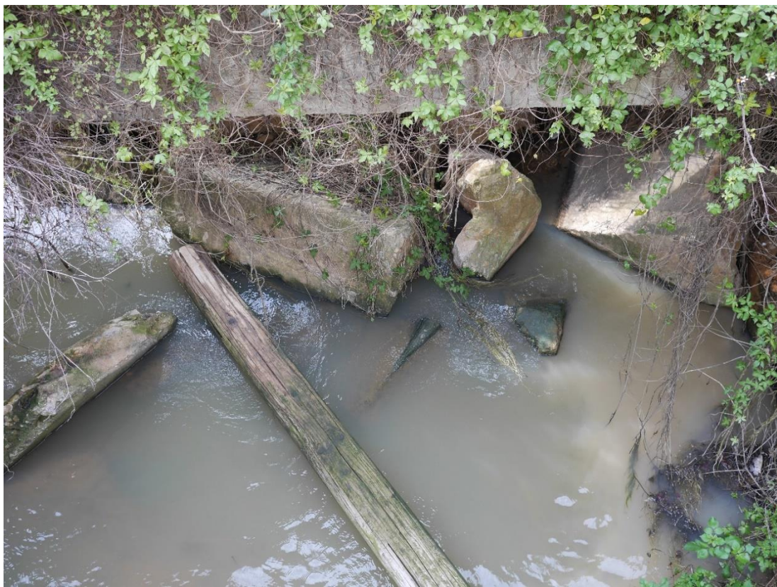
圖 3-4、位於環島北路，蘭湖北側的金湖二號橋，橋下大量鋼筋水泥塊堵塞
