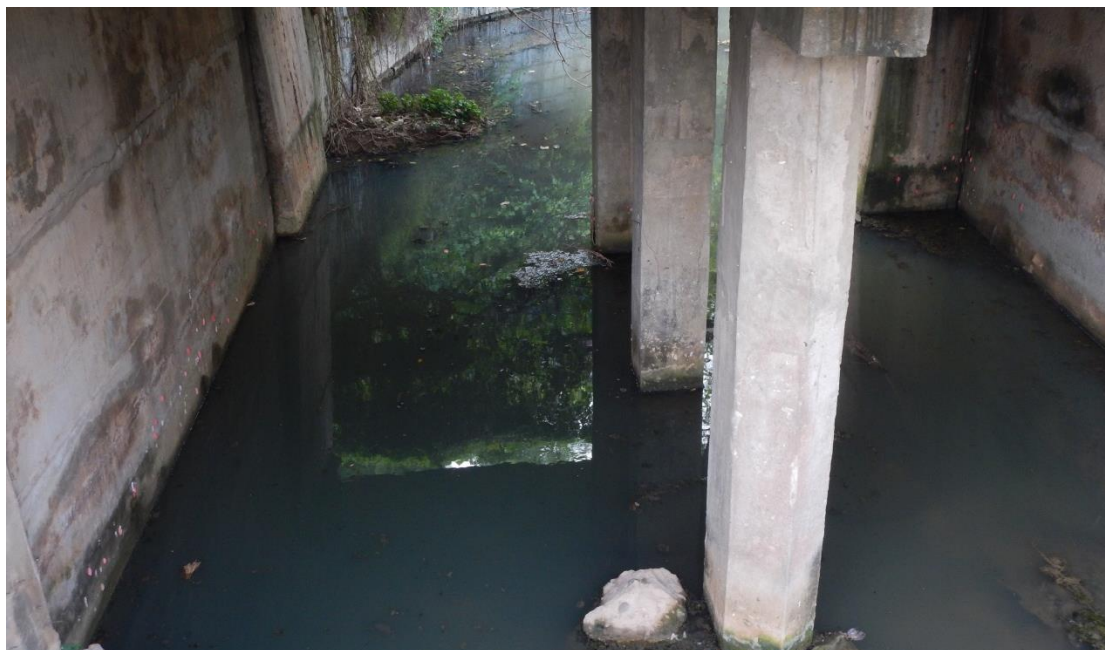
圖 3-9、金湖三號橋下水質呈烏黑色且散發惡臭，但有發現水獺排遺
