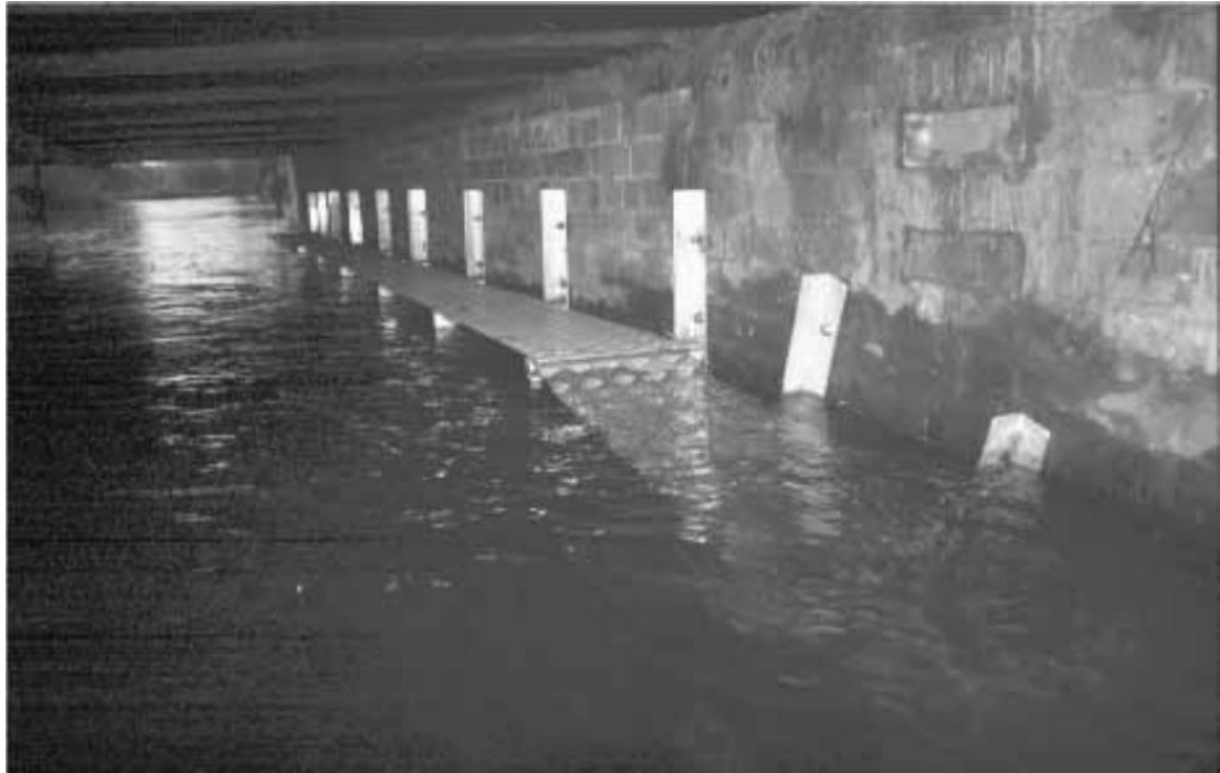
以金屬托架製成的水獺棧道
