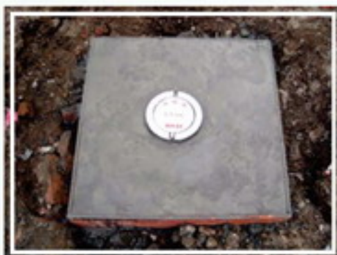
圖 4-14 新水準原點埋設照片
