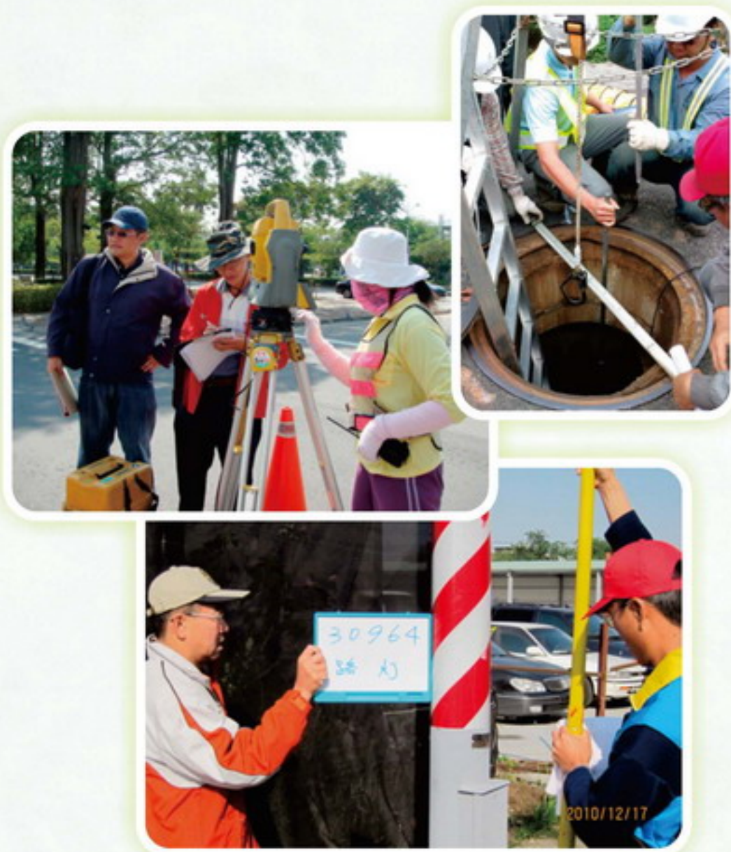
圖 4-42 嘉義市區各類人手孔、制水閘等固定設施物調查與補測作業現場查核
