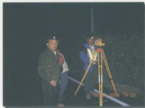
圖 4-1-10 金門地區精密水準測量 晚上作業情形
