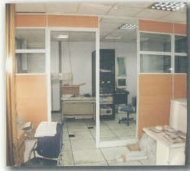
圖 4-1-6 e-GPS 控制及計算中心機房配置情形
