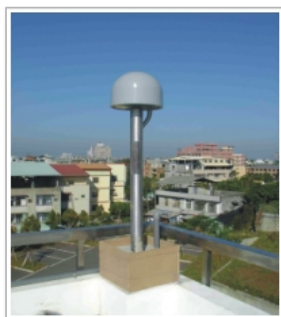
圖4-3 鋼柱式天線架基座架設
