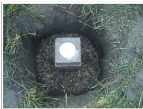
圖4-2 三等控制點標石埋設作業情形
