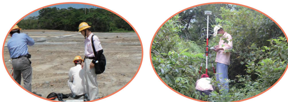
▲ 圖4-15 台電鐵塔用地預為分割測量情形
