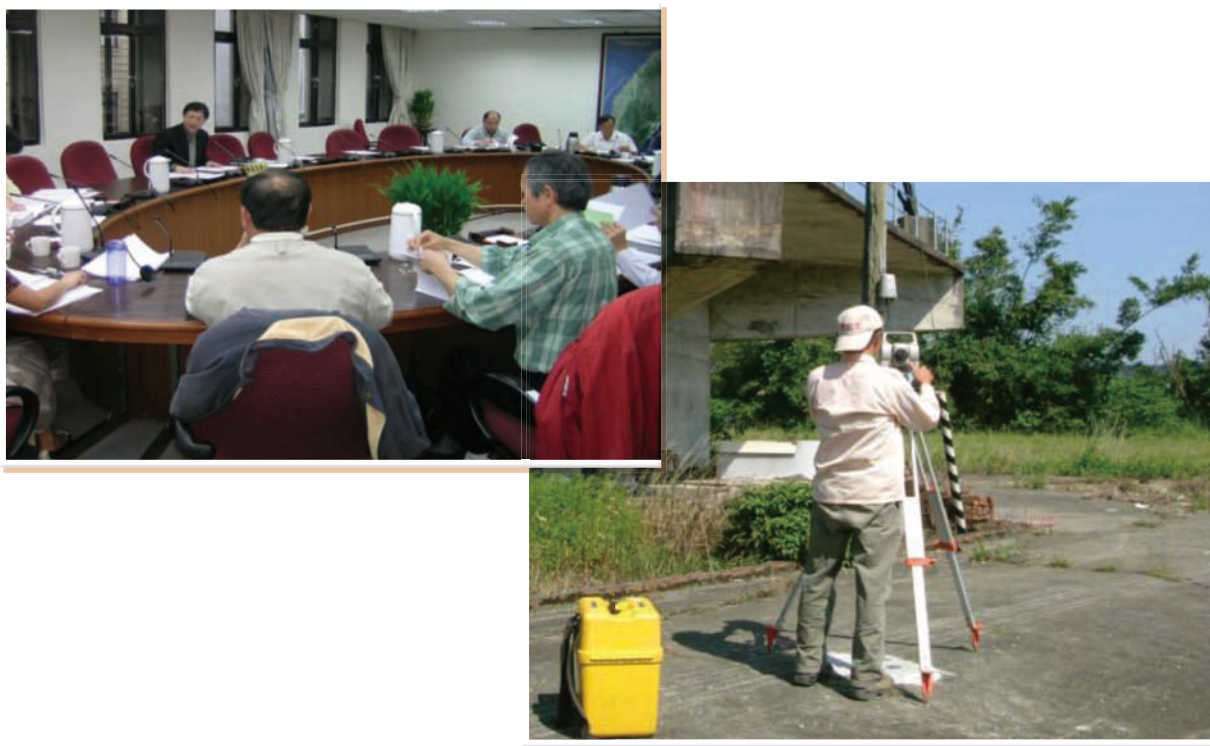
↑圖4-13 臺電輸電線路線下測量聯繫會報及外業測量情形
