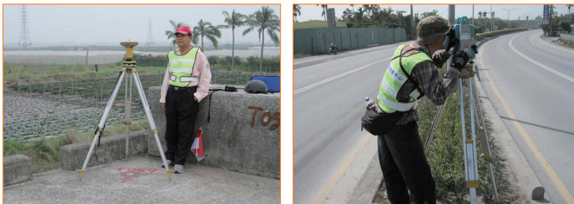
↑圖4-9 加密控制測量GPS觀測及圖根測量外業觀測情形
