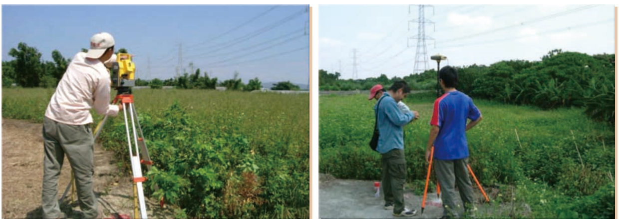
↑ 圖4-12 臺電鐵塔用地預為分割測量情形
