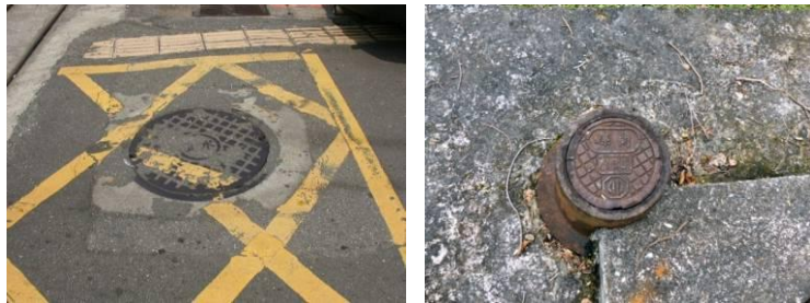
圖 1-4 公用管線孔蓋之人孔蓋（左）及制水閥（右）
