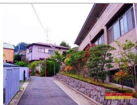
診療所採用凹凸的外牆磚與小松石護坡，後面民宅並配合植栽綠帶的延續。
