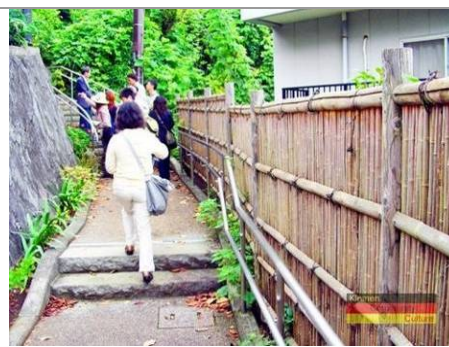
以在地小松石築造護坡，及竹籬笆隔離，都是採用自然材料施作。
