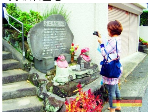
背戶道石階垂直面採用自然鑿面，並保留原有的元素—地藏王菩薩石像。
