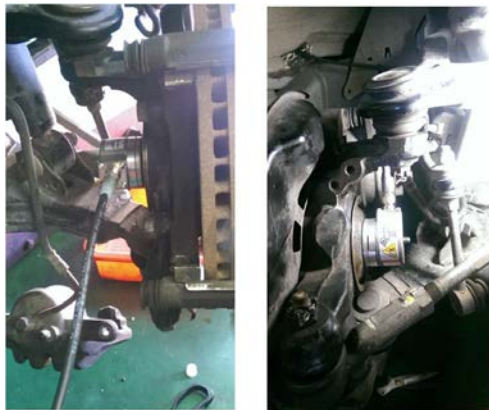
圖 3-17 纜線及固定裝置調整
