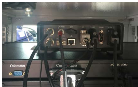
圖 3-96 設備線路連接
