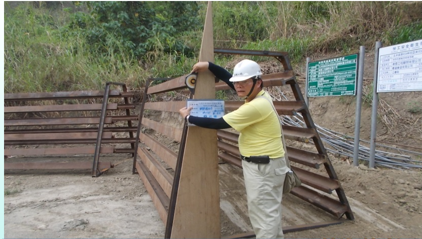
防砂壩鋼軌柵組立查驗
