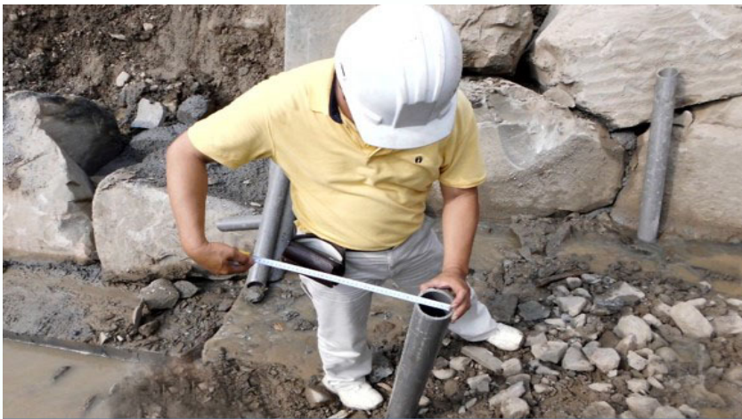
洩水管進場檢驗型號尺寸
