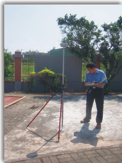
圖 4-3 e-GPS即時動態定位系統 外業實地操作情形
