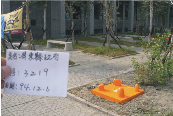
圖4-13 一等水準點埋設情形
