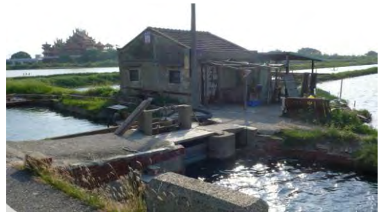
■ 魚塭旁的塭寮
