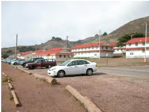
■ 美國舊金山金門國家公園停車場採用低度設計，採用在地礫石材料，以河口漂流木做路緣石與環境融合。
