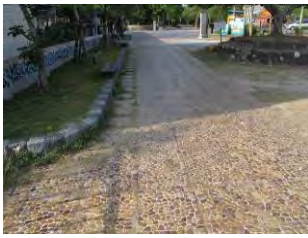
■ 透水鋪面停車場
