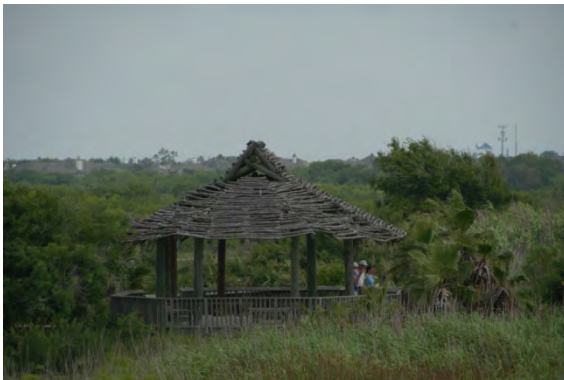
■ 濕地周邊賞鳥亭。以現地材料搭建，由地方居民共同進行維護與整建。
