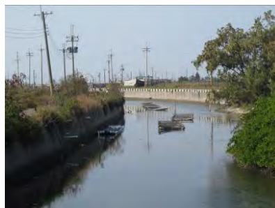
■ 潮溝兩側為混凝土結構，使植生無法生長於
