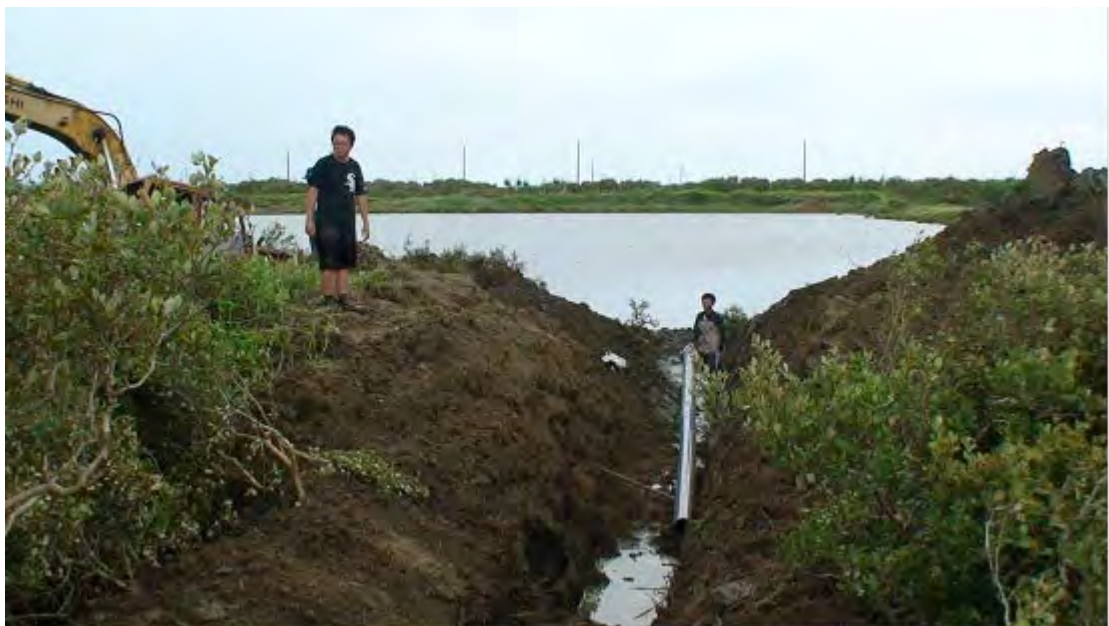
圖 6-9、魚塭埋設水管施做。
