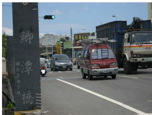
圖 3-43：仁德區鯽潭橋（裕農路—太子路）
