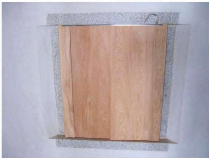
照片- 198：木板窗扇安裝完成
