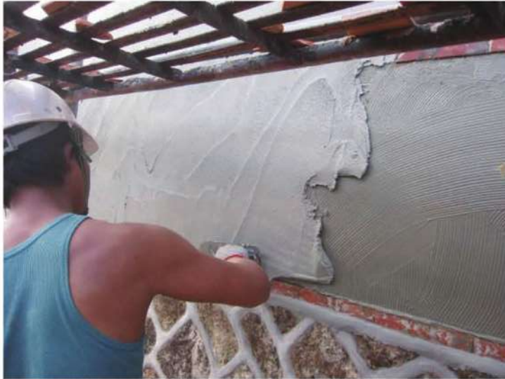
照片- 94：外壁麻絨灰漿粉刷
