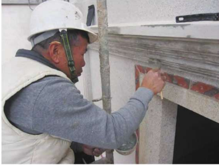
照片- 283：線角灰泥飾帶施作
