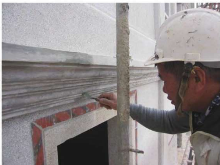
照片- 282：線角灰泥飾帶施作
