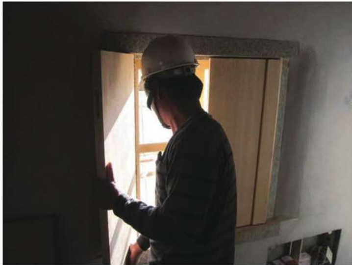
照片- 197：木板窗扇安裝
