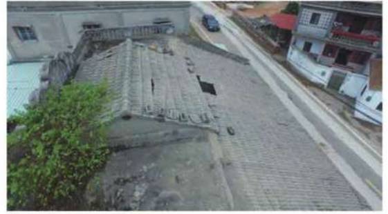
照片- 18：養拙樓二樓屋頂現況
