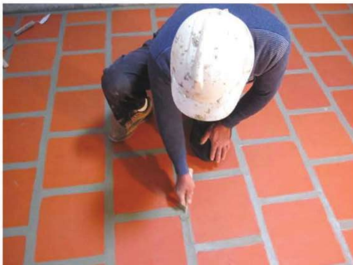
照片- 125：地坪尺磚勾縫修整
