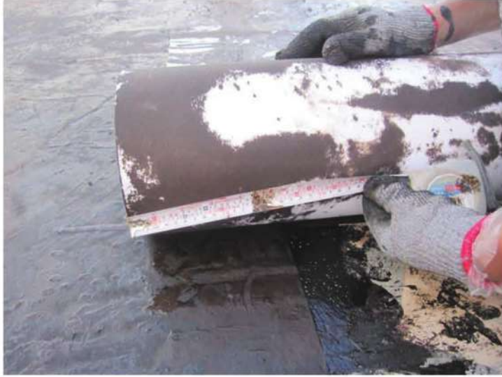
照片- 261：纖維棉搭接長度量測(後落)
