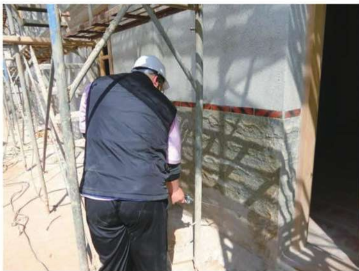
照片- 351：外牆噴塗防護劑
