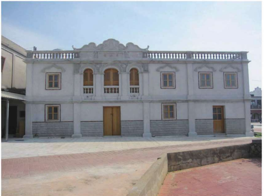
正立面-修復後
