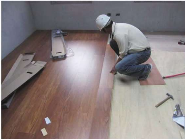
照片- 127：鋪設海島型超耐磨木地板
