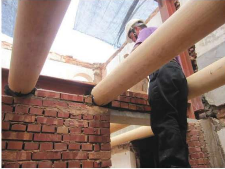
照片- 62：新砌紅磚牆體
