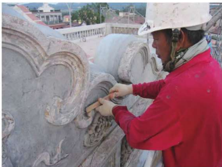
照片- 287：牌樓表面麻絨灰仿作
