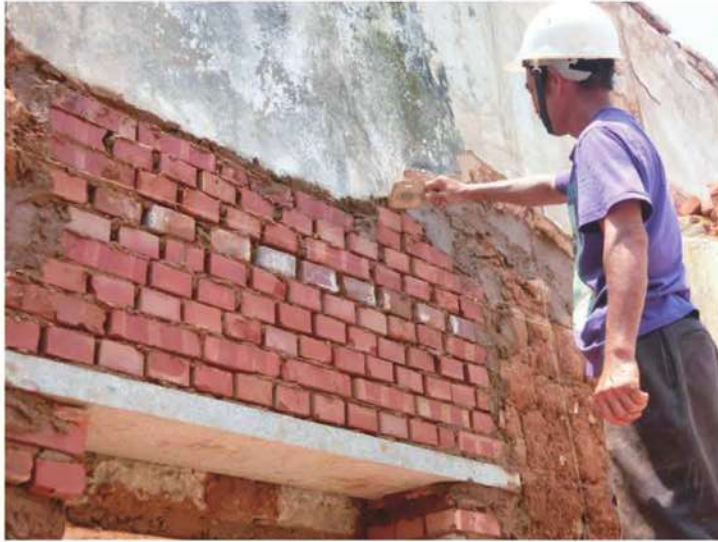
照片- 58：牆體崩塌處補砌紅磚
