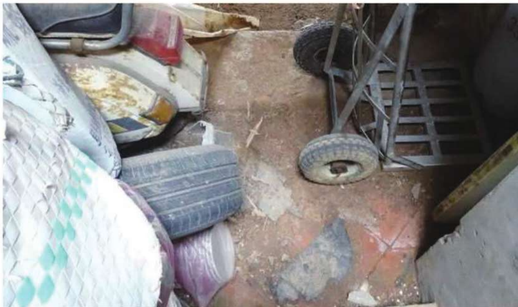
照片-12：正間後期增設補強水泥柱後方之長形地坪鋪面
