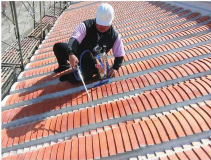
照片- 354：屋頂噴塗防護劑
