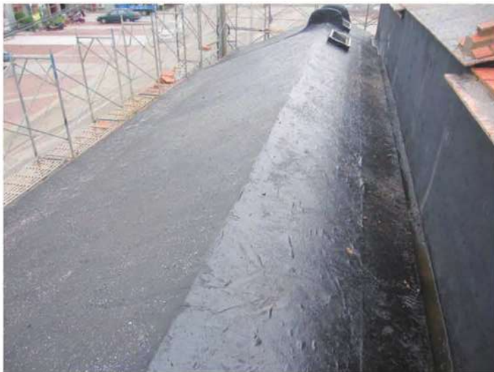
照片- 263：鋪設完成(後落)
