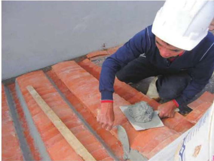
照片- 236：瓦溝及縫隙以灰漿勾縫收邊(後落前坡)
