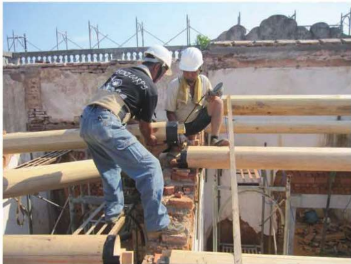
照片- 155：桁木上架及校正(後落)
