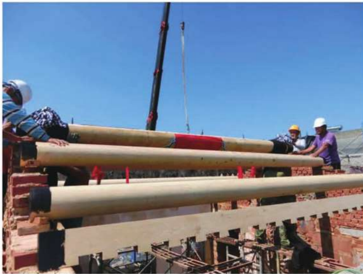
照片- 169：中脊上架調整固定
