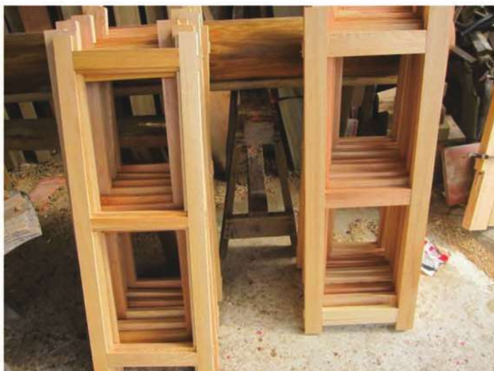
照片- 192：窗框試組完成
