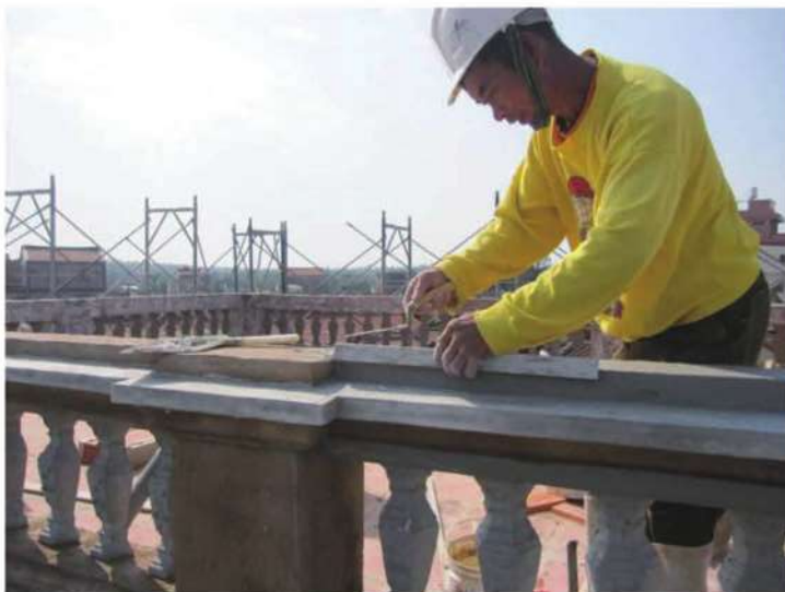
照片- 267：女兒牆欄杆飾帶施作
