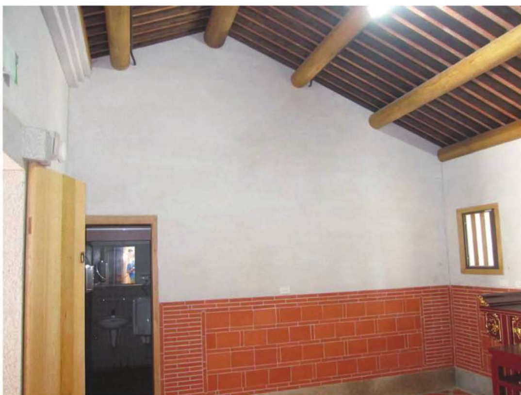
後落正廳牆面及屋架-修復後
