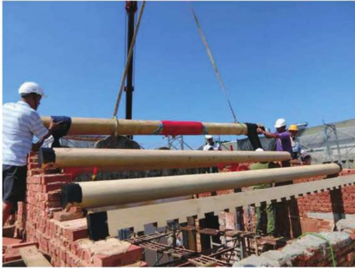
照片- 168：中脊上架調整固定
