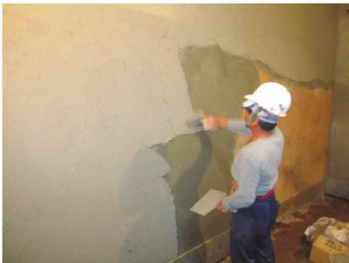
照片- 84：內壁麻絨灰漿粉光
