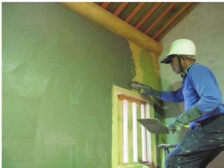
照片- 85：內壁麻絨灰漿粉光
