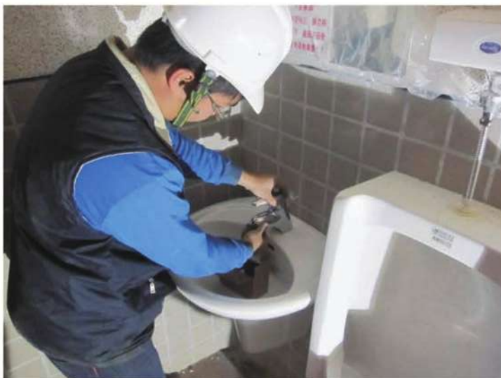
照片- 321：衛浴設備安裝
