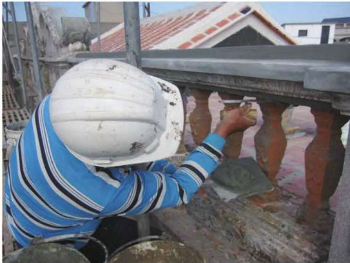
照片- 266：女兒牆欄杆施作
