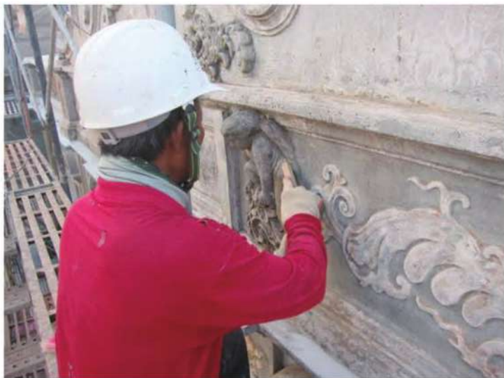
照片- 286：牌樓表面泥塑整修
