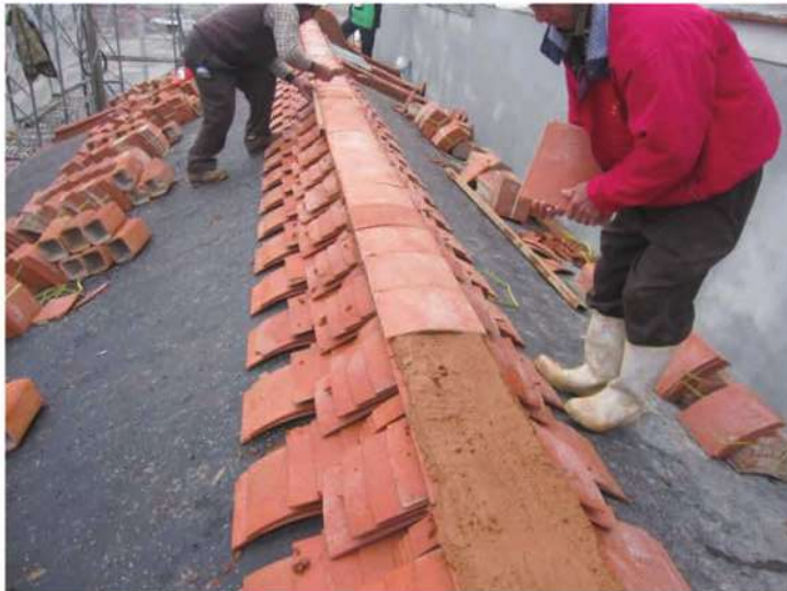
照片- 213：脊底放第二層瓦片（後落）
