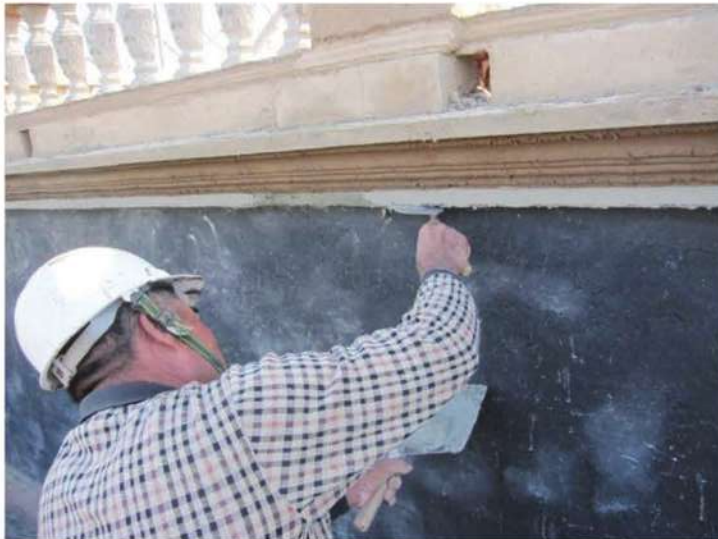
照片- 278：線角灰泥飾帶施作
