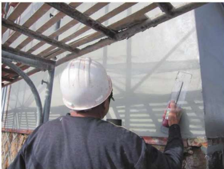
照片- 96：外壁麻絨灰漿粉光
