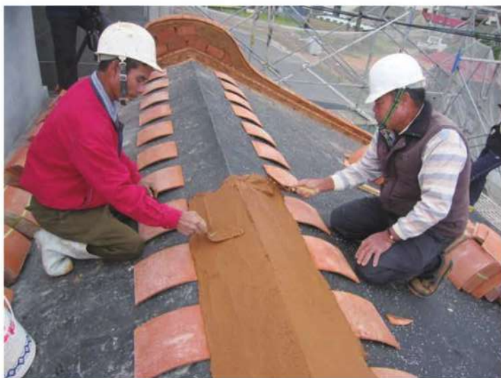
照片- 210：瓦攏槽數分配後填置三合土放樣(後落)
