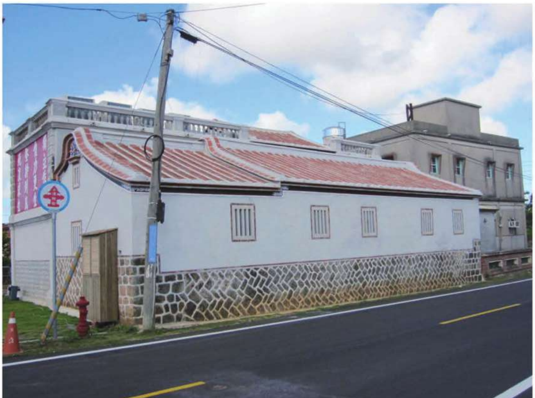
左後側立面-修復後
