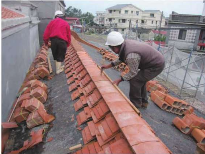
照片- 212：瓦槽上放置瓦片脊底（後落）
