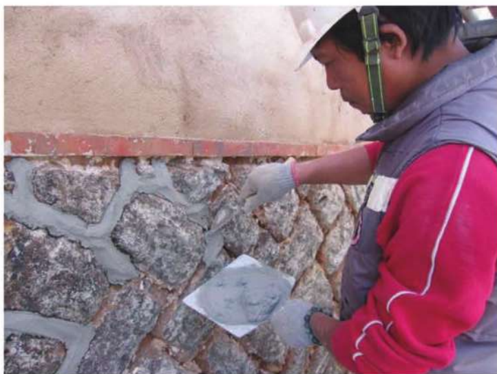
照片- 73：石砌牆台度灰漿勾縫
