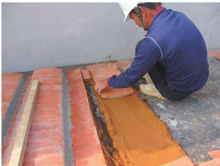
照片- 232：將底瓦逐片鋪貼於三合土，使瓦及屋面相互黏著(後落前坡)
