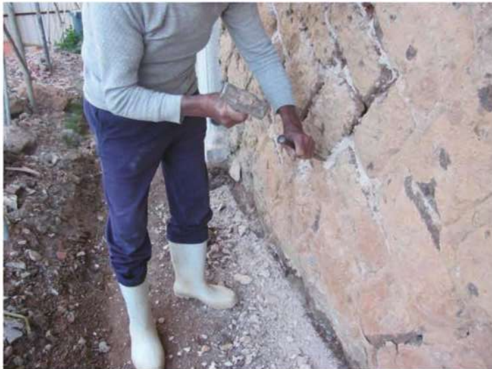
照片- 70：外壁石牆面既有灰縫人工打除
