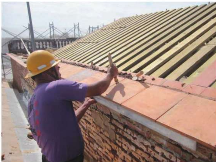
照片- 202：一層出簷磚施作(後落)
