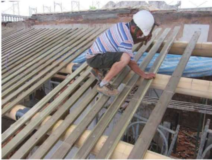
照片- 157：屋面桷木釘製(後落)
