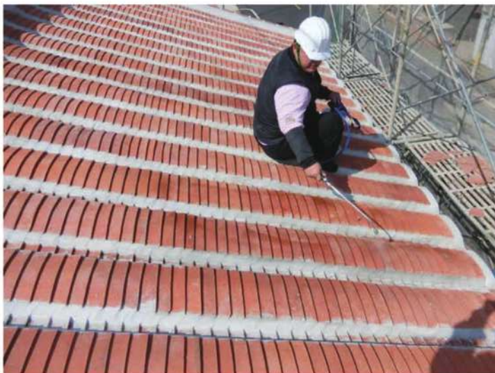
照片- 355：屋頂噴塗防護劑
