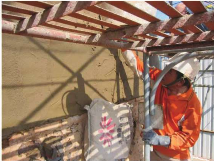
照片- 92：外壁三合土粉刷面整平
