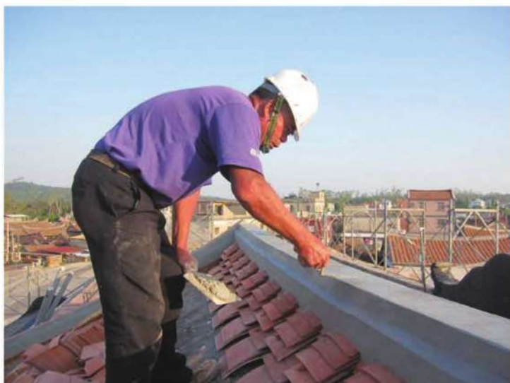
照片- 241 : 屋脊灰漿粉光收邊(洋樓)
