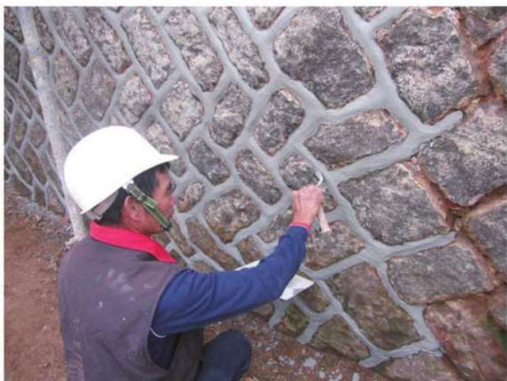
照片- 74：石砌牆台度灰漿勾縫
