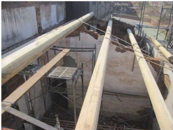
照片- 156：桁木上架完成(後落)
