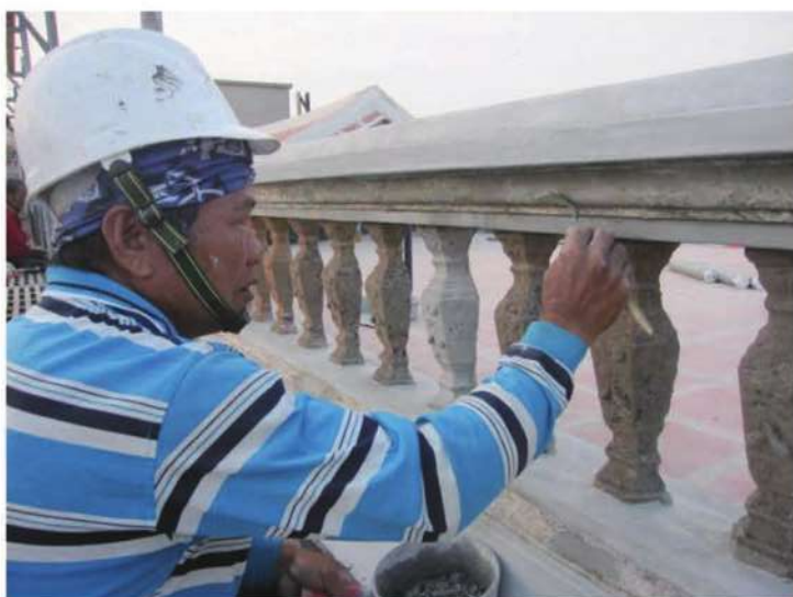
照片- 269：線角灰泥飾帶施作
