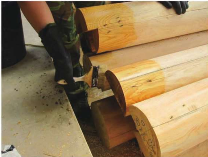
照片- 152：深入壁體之楹端塗刷防蟲防蟻
