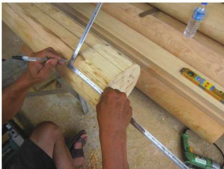
照片- 141：桁端榫頭中心線放樣
