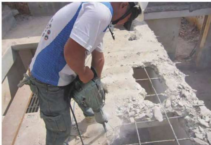
照片- 48：二樓版 RC 構造打除
