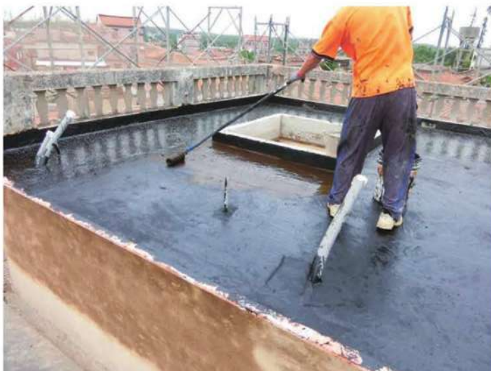
照片- 257：第二層防水膠施作(洋樓)
