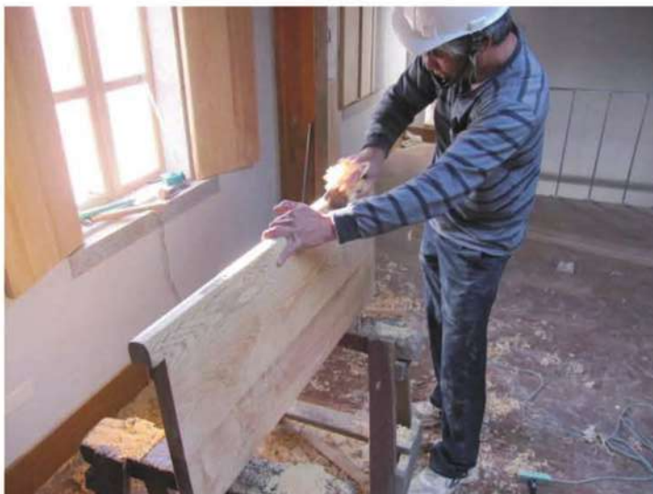
照片- 195：木板窗扇加工製作
