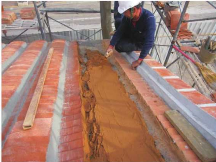
照片- 225：鋪設仰瓦前於底部填置三合土(後落後坡)
