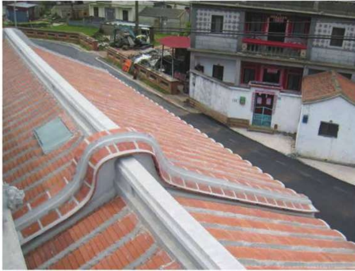
照片- 248：屋面瓦作施作完成
