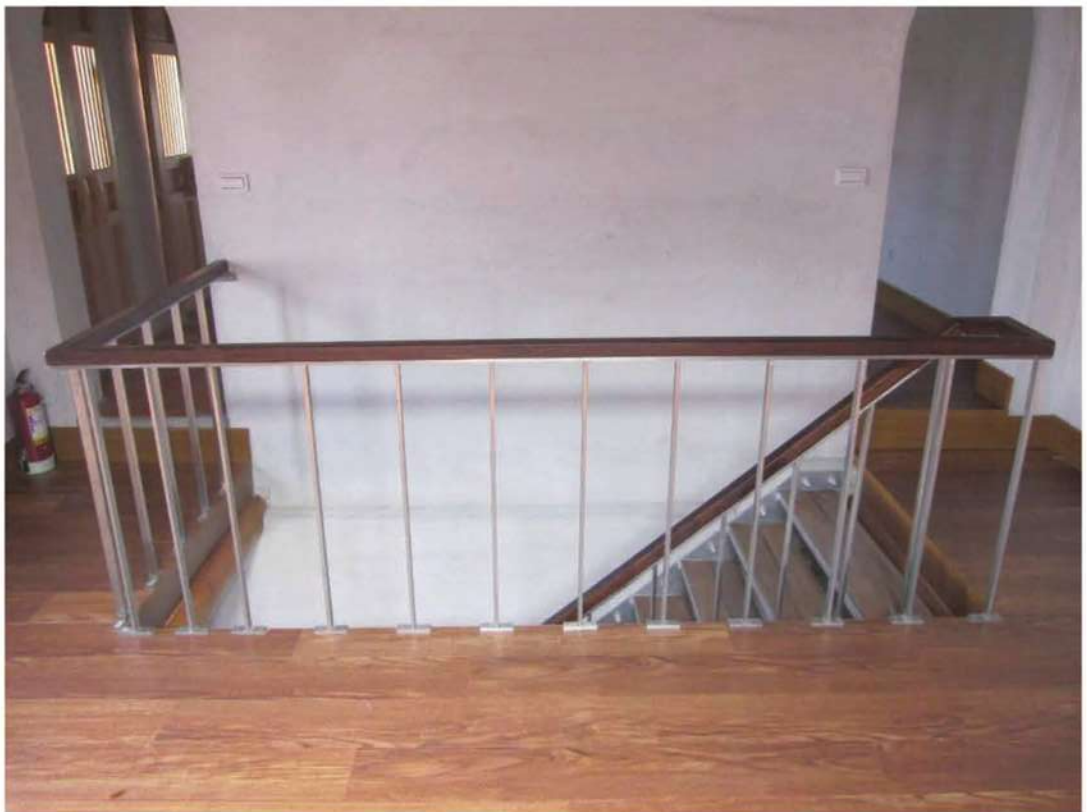
二樓左房樓梯-修復後
