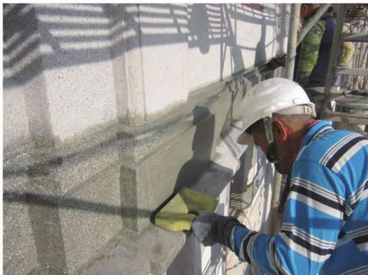
照片- 110：牆面蠟殼洗石子-表面水泥漿抹洗
