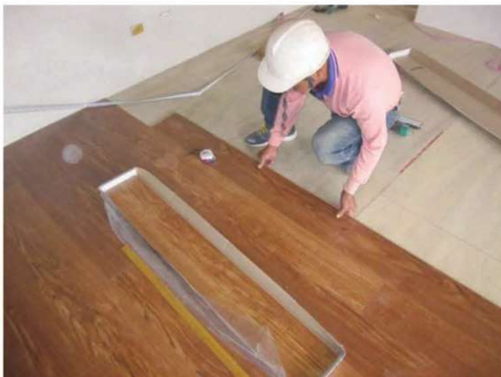
照片- 128：鋪設海島型超耐磨木地板
