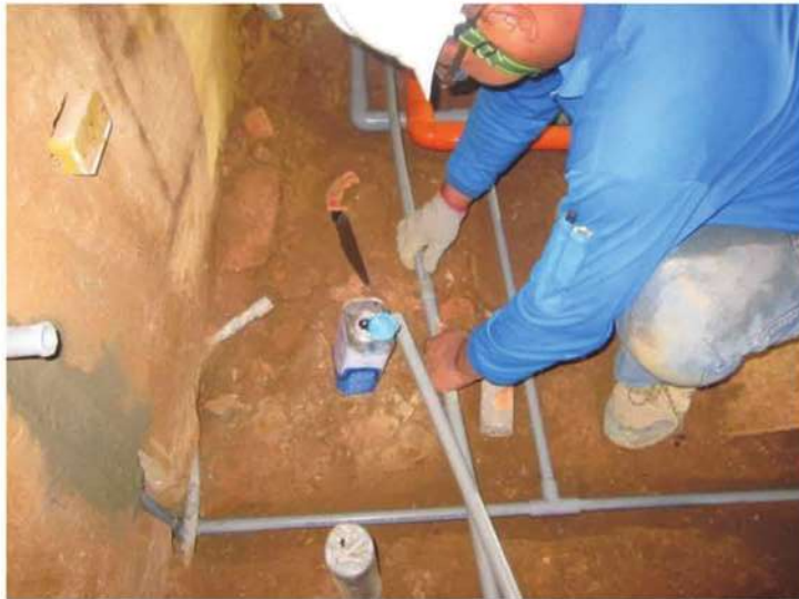
照片- 311：水電管路佈置
