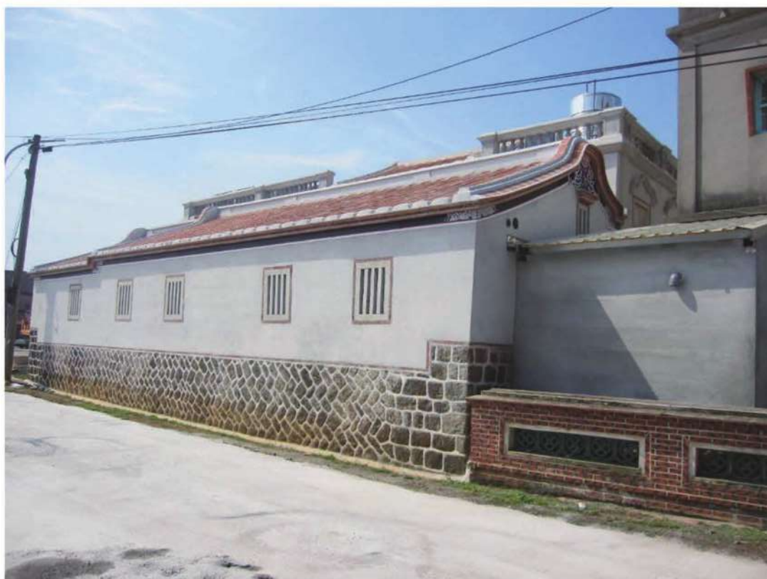
右後側立面-修復後
