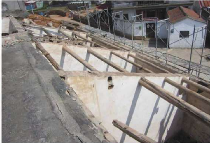
照片- 45：屋面解體清理後之樣貌
