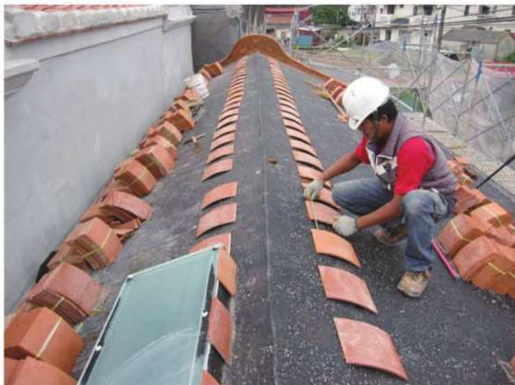
照片- 209：瓦攏槽數放樣，使中心為底瓦，並避開瓦隴數禁忌(後落)
