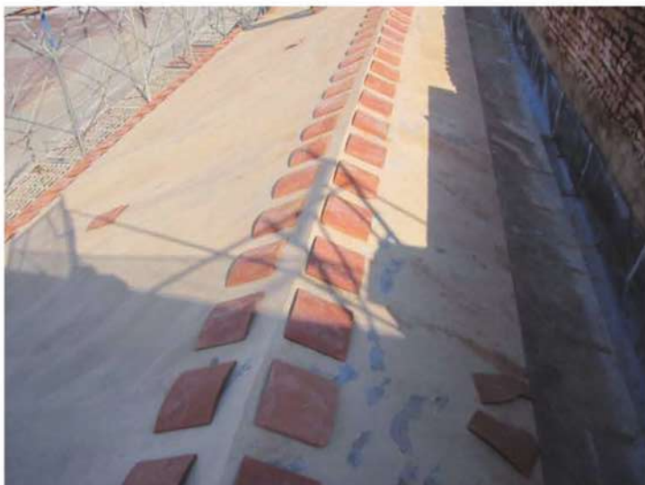
照片- 208：瓦攏槽數分配放樣(後落)
