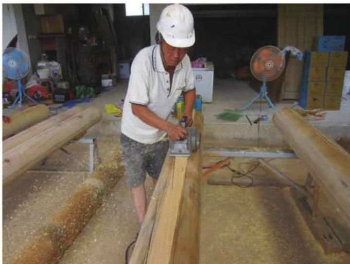
照片- 147：水掛刨除施作
