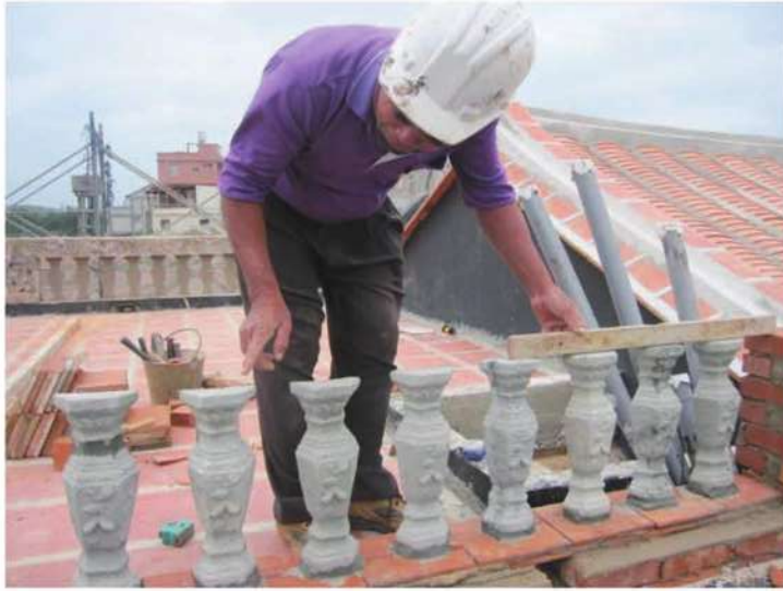
照片- 265：水泥預鑄花瓶欄杆安裝
