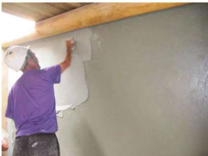
照片- 86：內壁麻絨灰漿粉光
