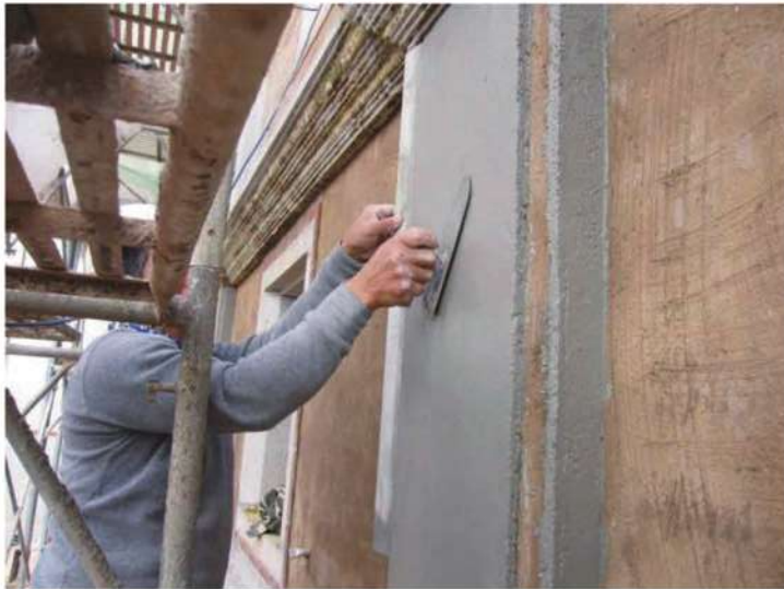
照片- 102：柱身重新蠣殼洗石子
