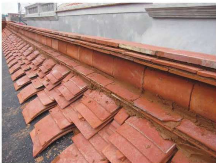
照片- 217：屋脊頂「上馬路」置壓磚(板+六寸磚)
