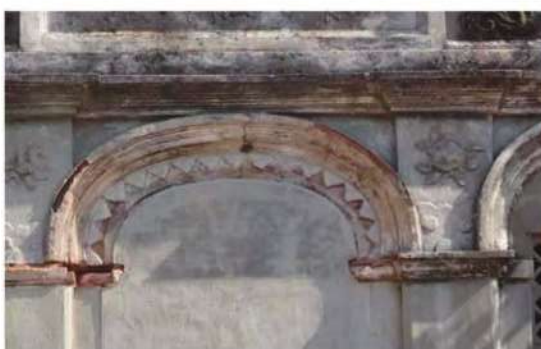
照片- 21：養拙樓弧拱圈線角
