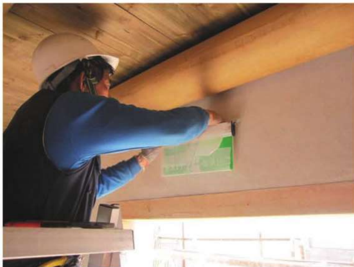
照片- 317：燈具設備安裝
