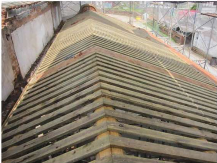
照片- 158：屋面桷木訂製完成(後落)
