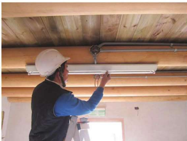
照片- 318：燈具設備安裝
