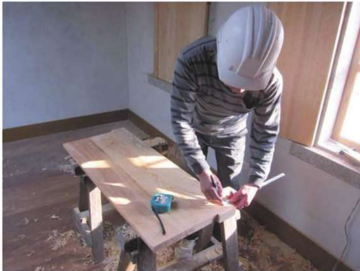
照片- 194：木板窗扇加工製作
