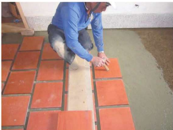
照片- 118：敲打磚面，將磚下空氣壓出，使磚與灰漿緊密結合
