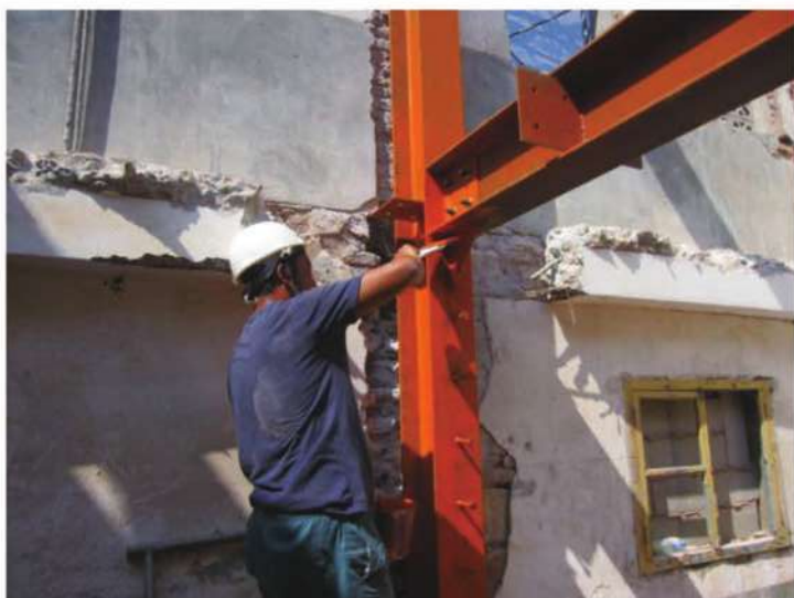
照片- 56 : H 型鋼防鏽漆塗刷
