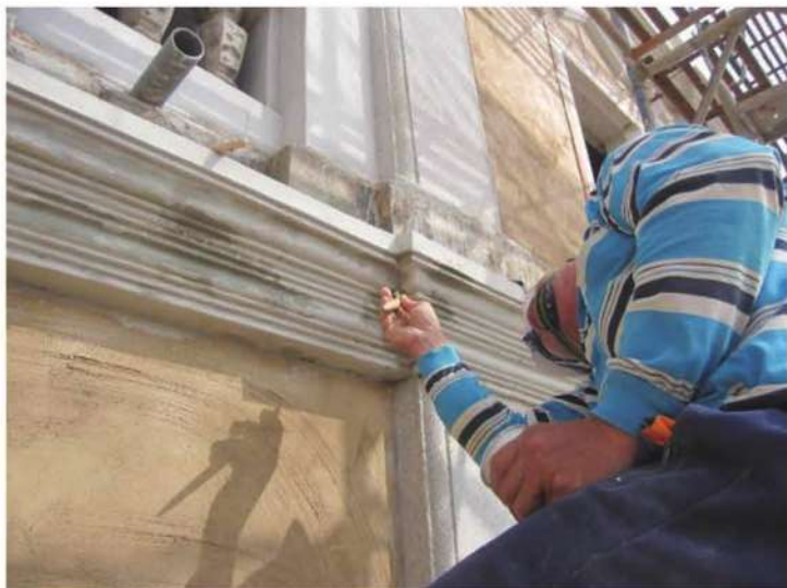
照片- 280：線角灰泥飾帶施作
