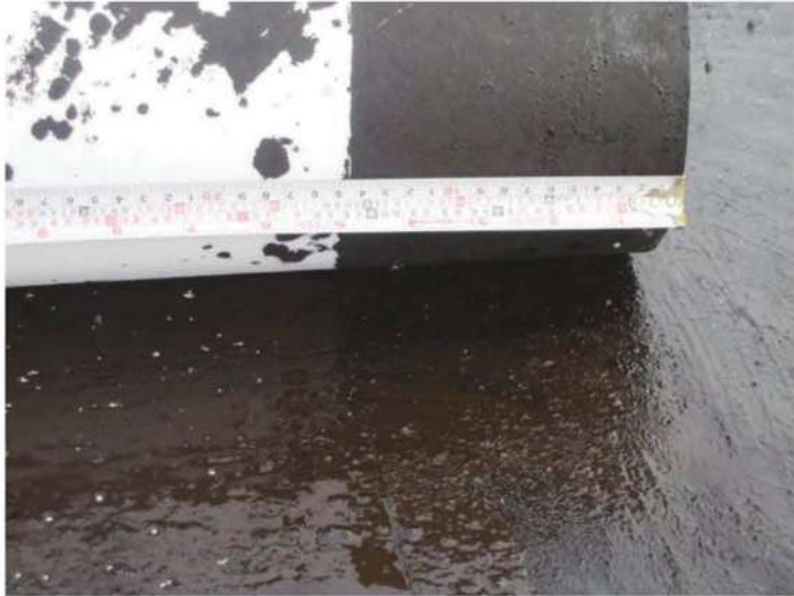
照片- 255：纖維棉搭接長度量測(洋樓)
