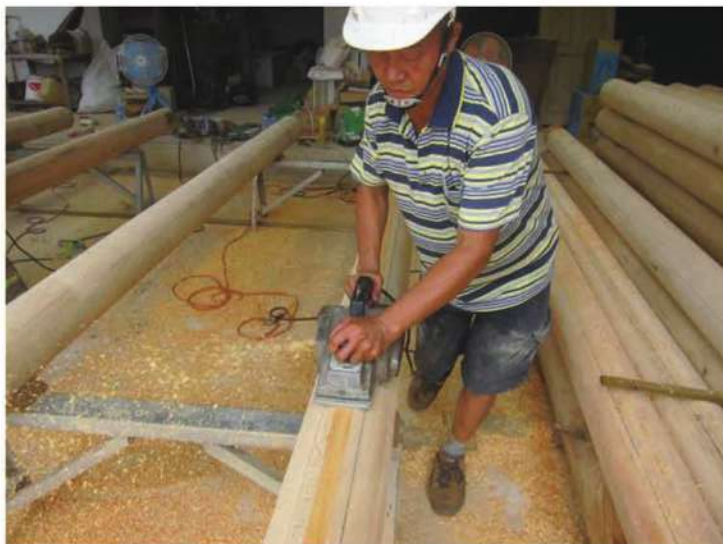
照片- 148 : 水掛刨除施作
