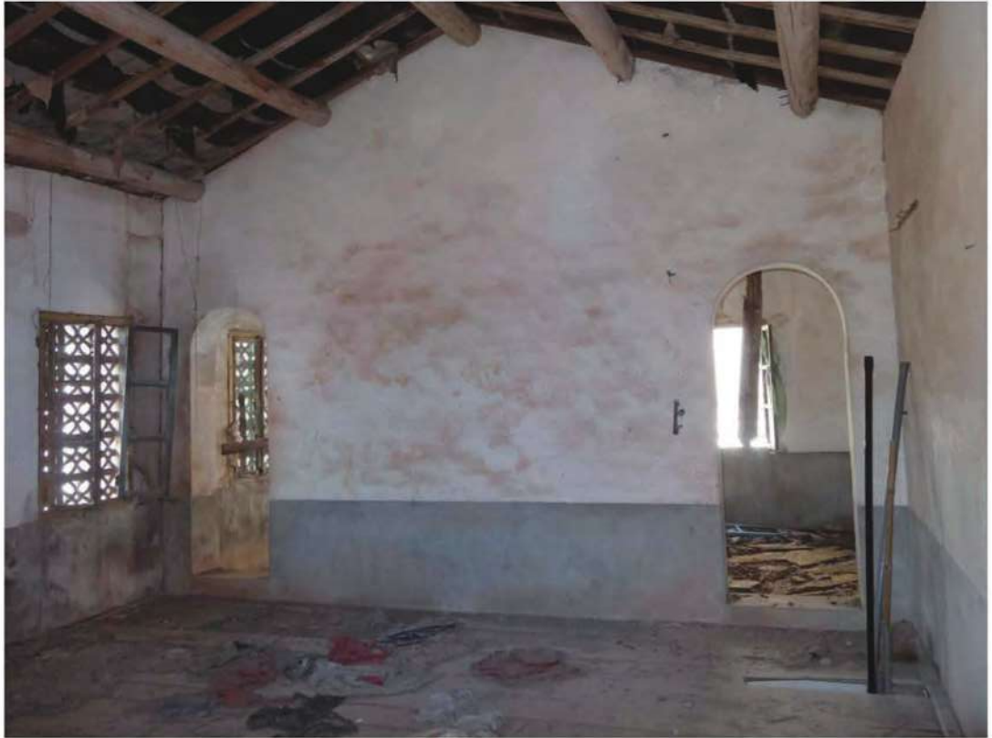
二樓大廳牆面-修復前
