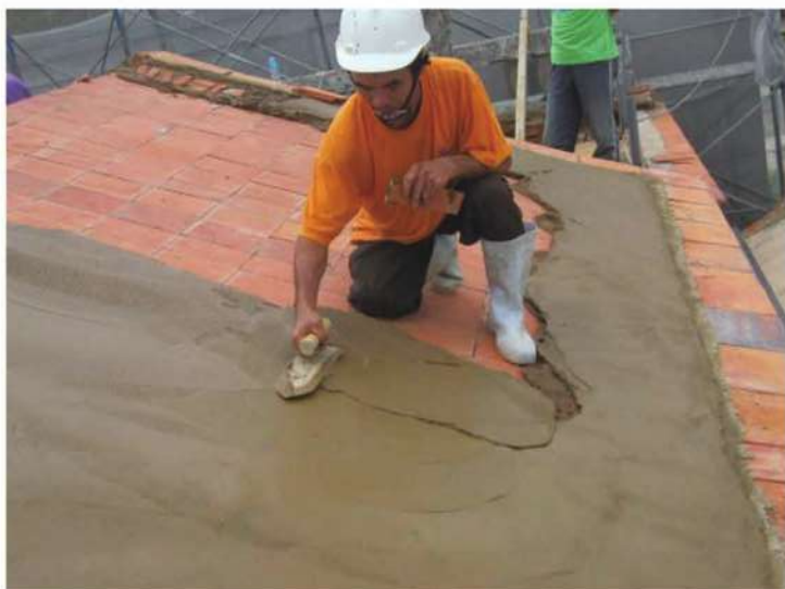
照片- 204：於養瓦上鋪設三合土(洋樓)
