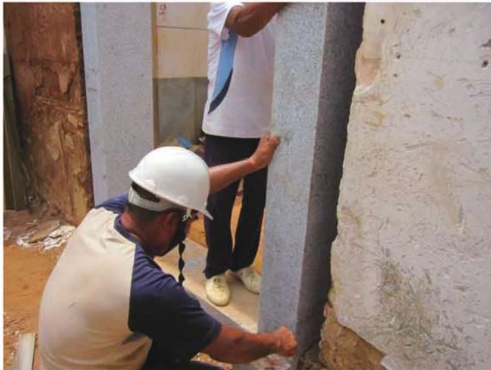
照片- 177：石門框安裝組立
