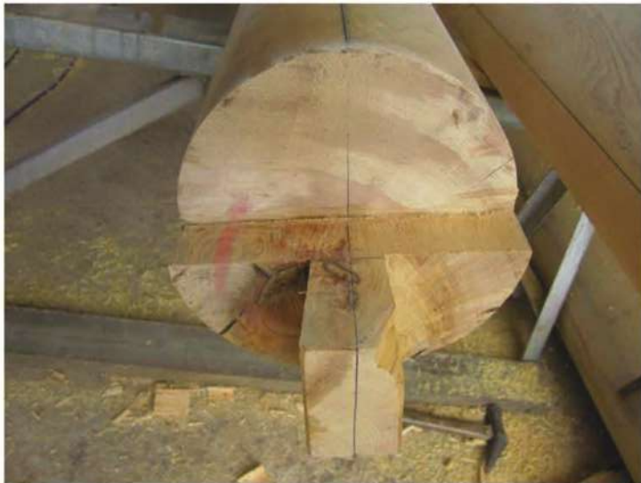
照片- 146：製作完成之樁頭
