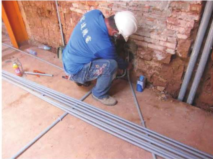
照片- 310：水電管路佈置
