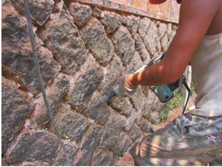
照片- 69：外壁石牆面既有灰縫打除
