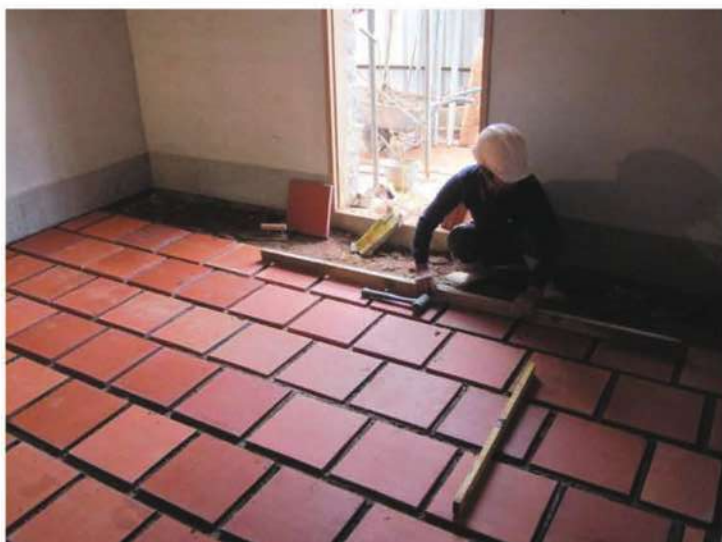
照片- 119：地坪磚面須以壓尺修正
