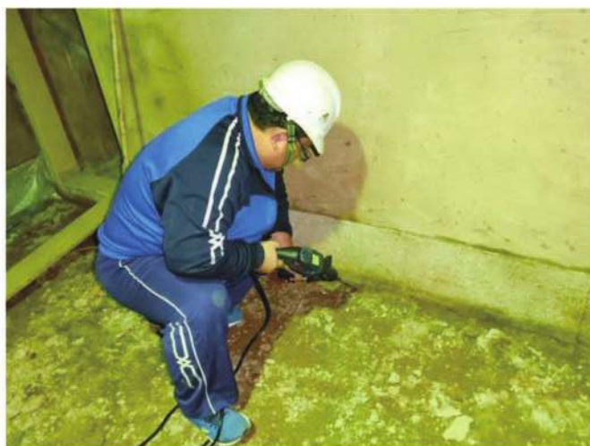
照片- 328：牆身阻絕帶-現場鑽孔
