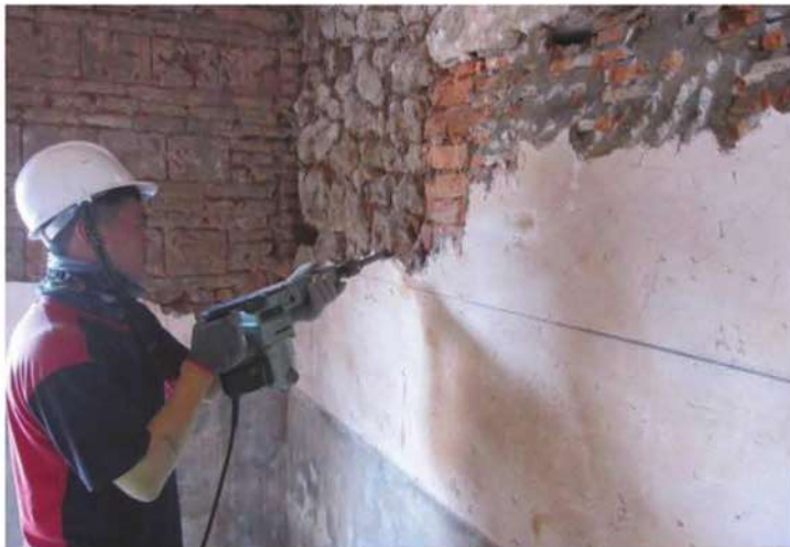
照片- 78：原有牆面粉刷層人工剔除
