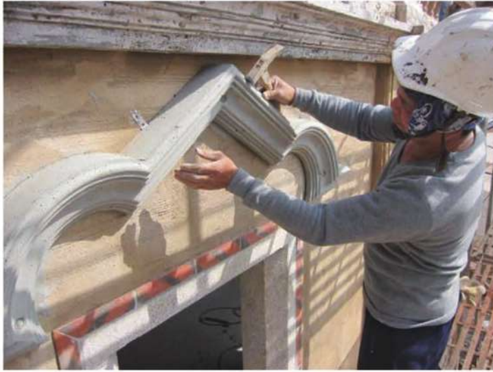
照片- 271：泥塑窗簷線角安裝
