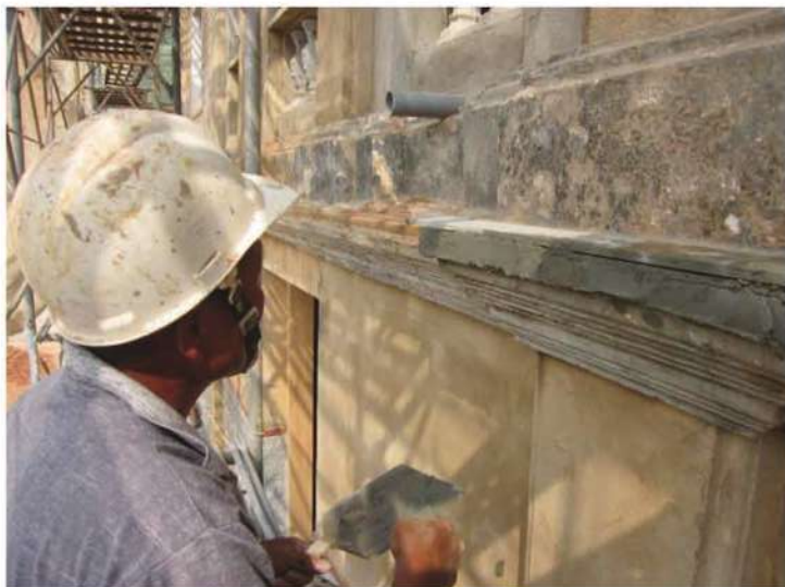
照片- 274：線角出磚修補及表面粉刷
