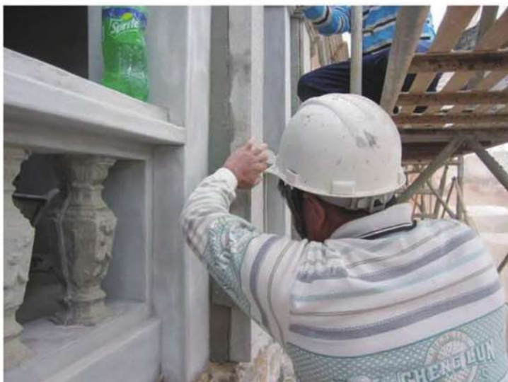
照片- 103：柱身重新蠣殼洗石子
