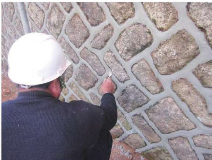
照片- 77 : 石砌牆台度灰漿勾縫
