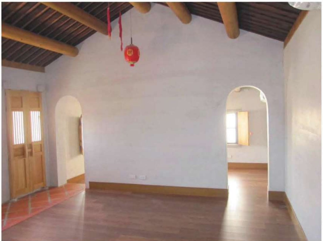
二樓大廳牆面-修復後
