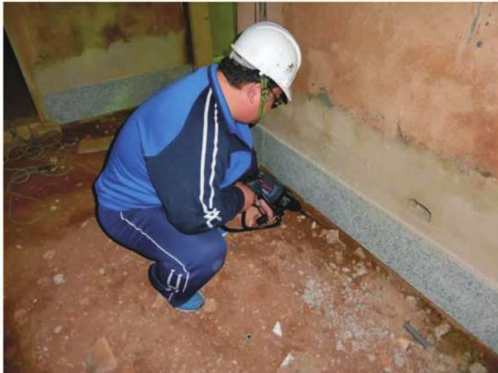
照片- 330：牆身阻絕帶-現場鑽孔
