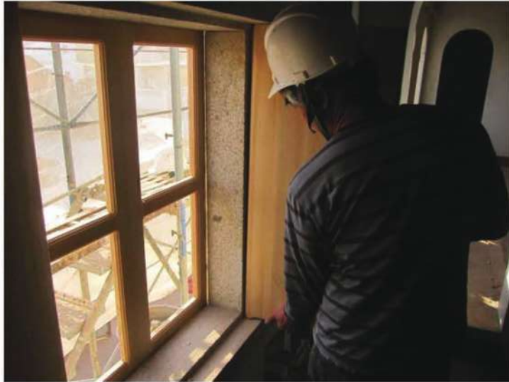
照片- 196：木板窗扇安裝
