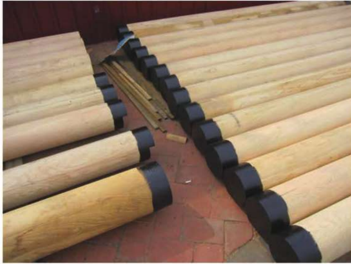
照片- 154：楹端防蟲防腐處理
