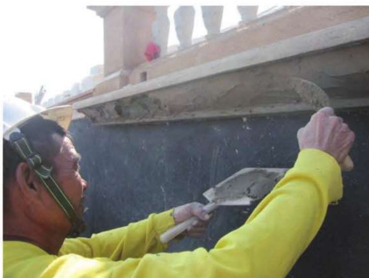
照片- 276：線角灰泥飾帶施作
