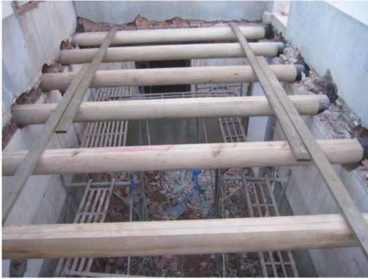
照片- 160：二樓桁木上架完成(洋樓)
