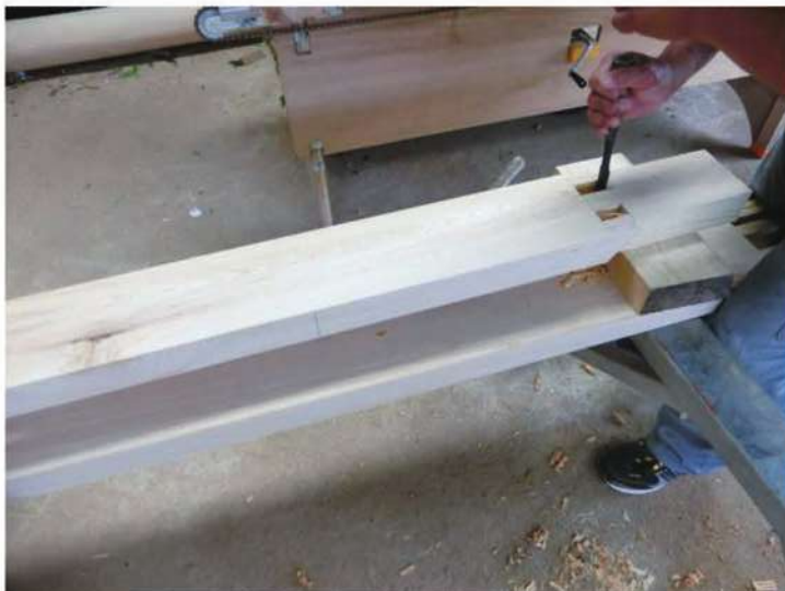
照片- 183：木製門框加工製作
