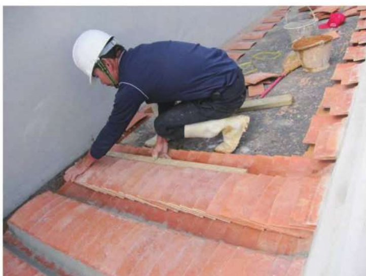
照片- 235：以導尺調校瓦面(後落前坡)
