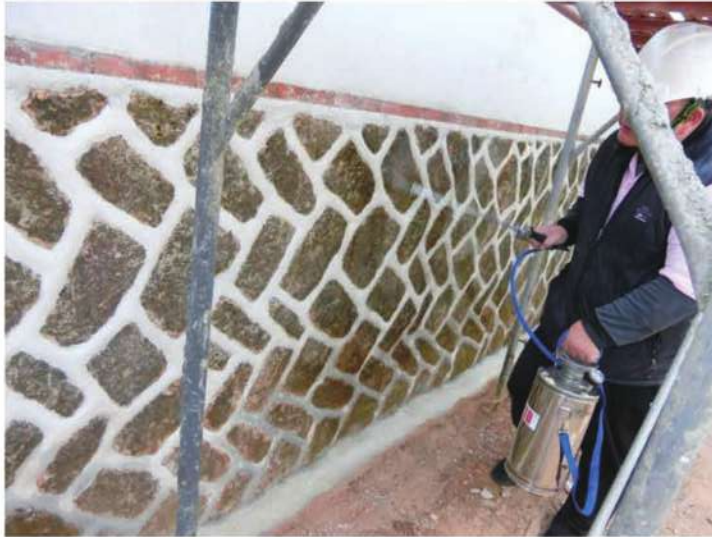
照片- 353：外牆噴塗防護劑
