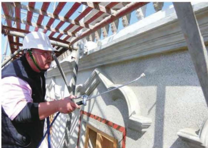
照片- 349：外牆噴塗防護劑
