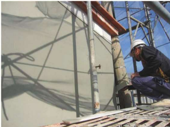
照片- 95：外壁麻絨灰漿粉光
