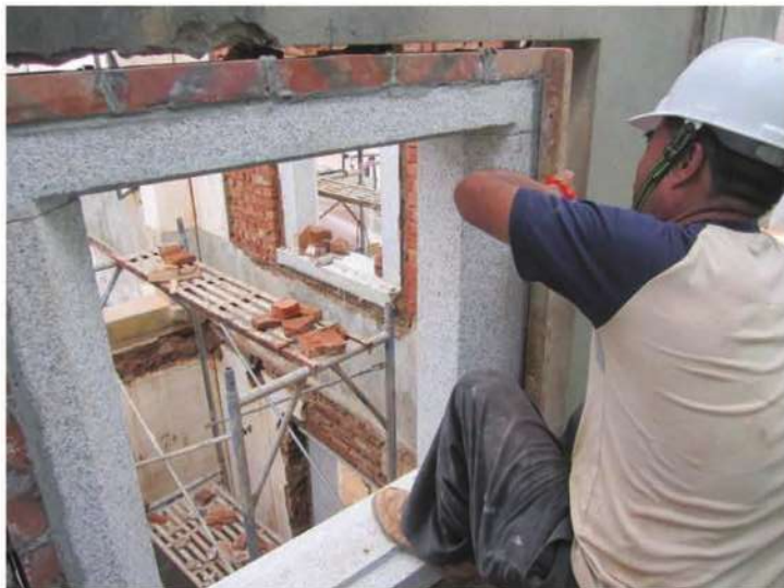
照片- 180：花崗石窗框安裝
