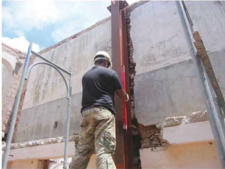
照片- 54 : H 型鋼立柱
