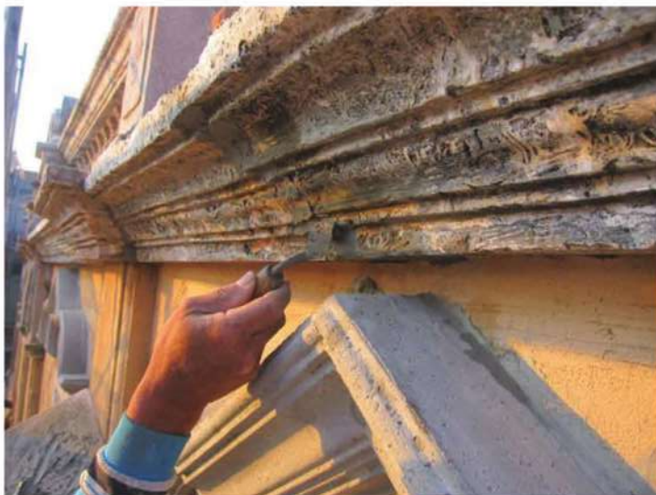
照片- 273：線角出磚修補
