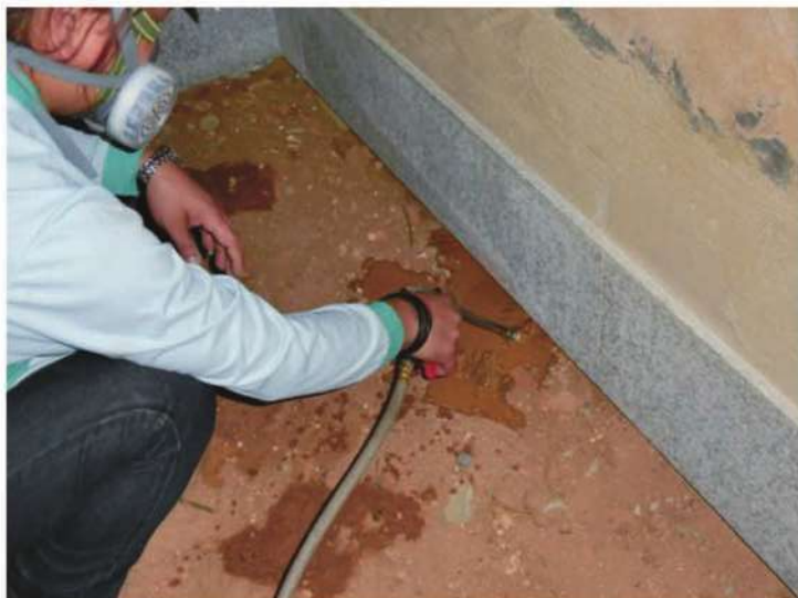
照片- 332 : 牆身阻絕帶-機械加壓灌注
