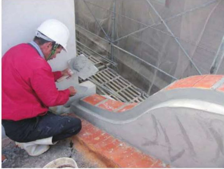
照片- 224：規帶灰漿收邊粉光(後落)
