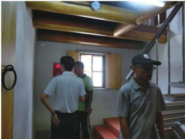
照片- 381：主辦機關、監造單位、承攬廠商合同複驗
