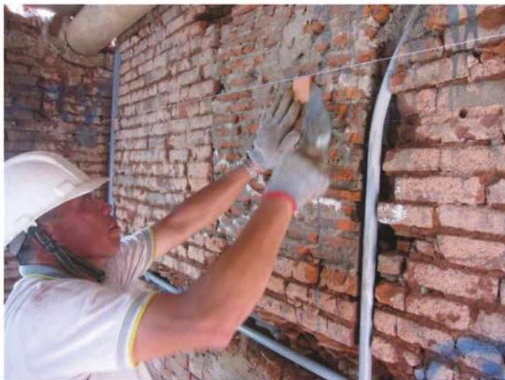
照片- 80：壁面灰誌及吊線
