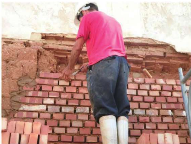
照片- 57：牆體崩塌處補砌紅磚
