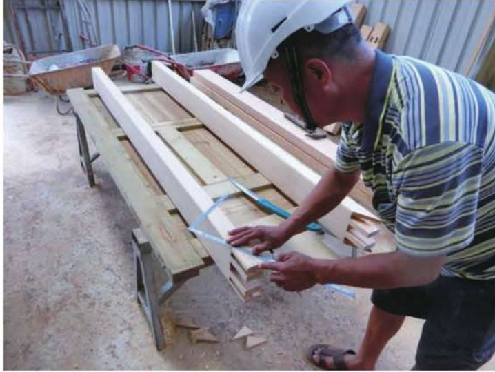
照片- 181：木製門框加工製作
