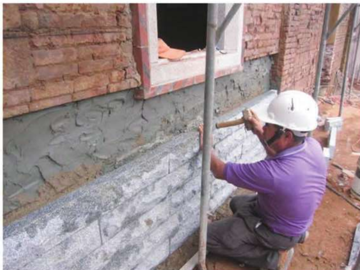
照片- 66：正立面花崗石台度施作
