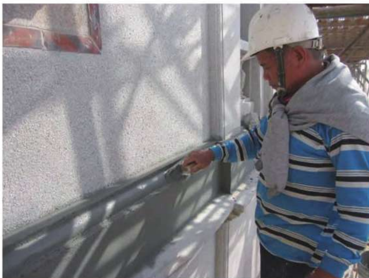
照片- 109：牆面重新蠣殼洗石子
