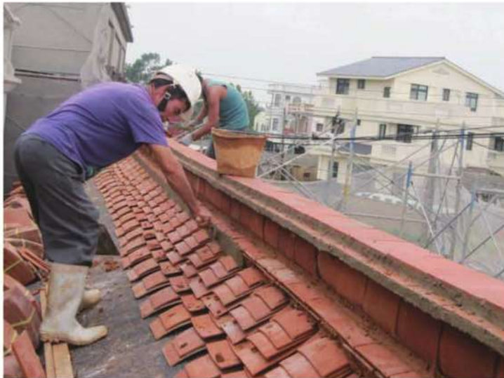
照片- 219：屋脊以三合土填實(後落)
