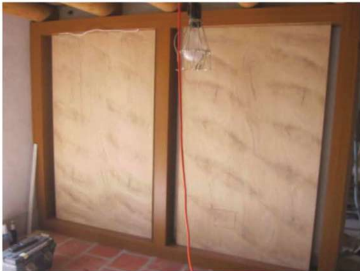
照片- 302：展示面板施作
