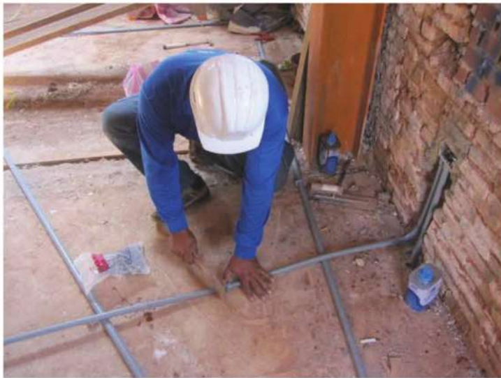
照片- 309：水電管路佈置
