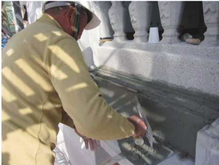
照片- 108：牆面重新蠣殼洗石子
