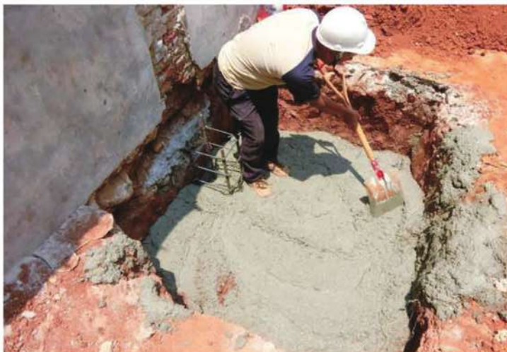
照片- 53 : H 型鋼基礎混凝土澆置
