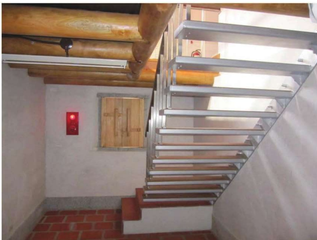
通往二樓樓梯-修復後
