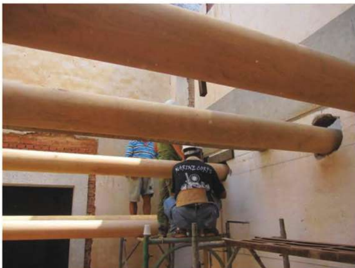
照片- 159：二樓桁木上架及校正(洋樓)
