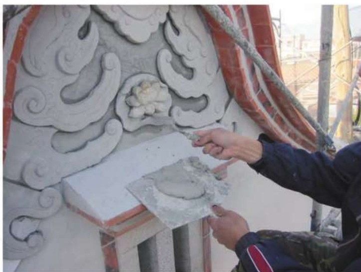
照片- 293：山牆脊墜泥塑塑型
