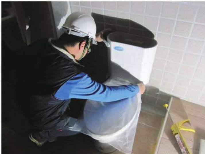
照片- 320：衛浴設備安裝
