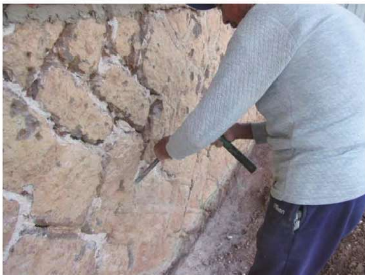
照片- 71：外壁石牆面既有灰縫人工打除
