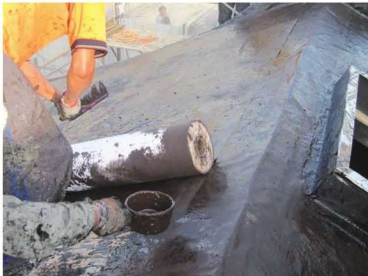
照片- 260：於纖維棉上塗佈第二道纖維膠(後落)
