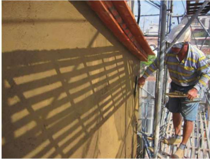
照片- 91：外壁三合土粉刷面整平
