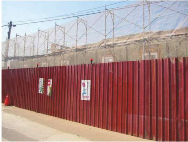
照片- 40：安裝安全警示燈及標語
