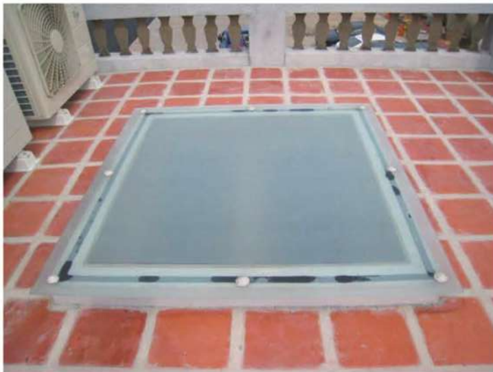
照片- 249：玻璃採光天窗施作完成
