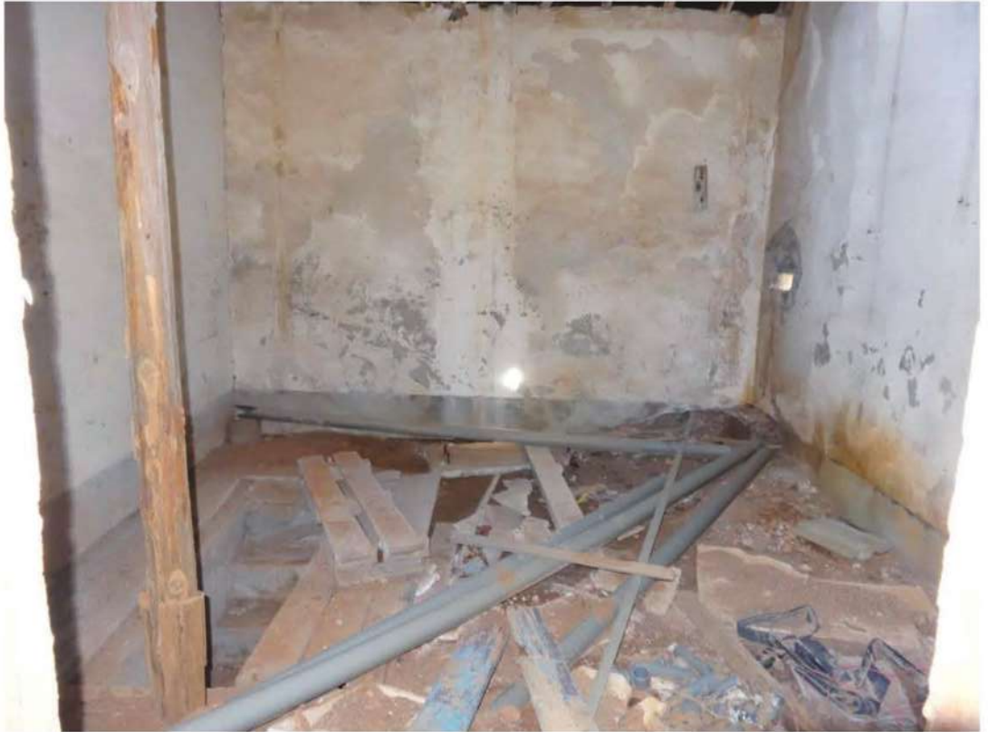
後落左外房及民防通道入口階梯-修復前
