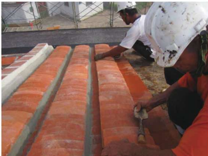
照片- 244：於兩槽仰瓦之間鋪合瓦(洋樓)
