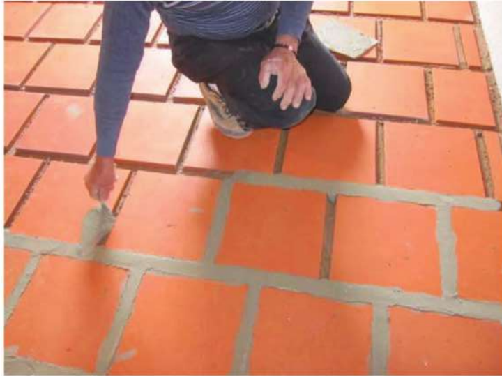
照片- 123：地坪尺磚鋪貼後灰漿勾縫
