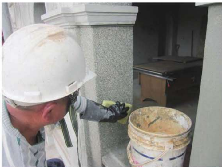
照片- 111：牆面蠟殼洗石子-表面水泥漿抹洗
