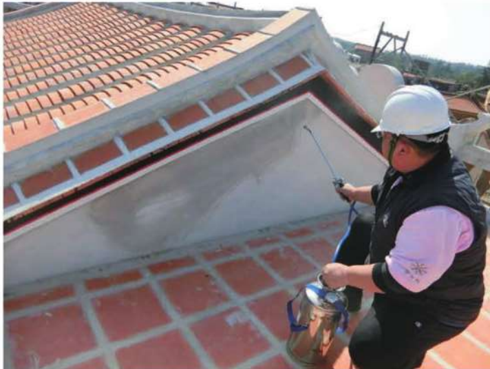
照片- 348：外牆噴塗防護劑
