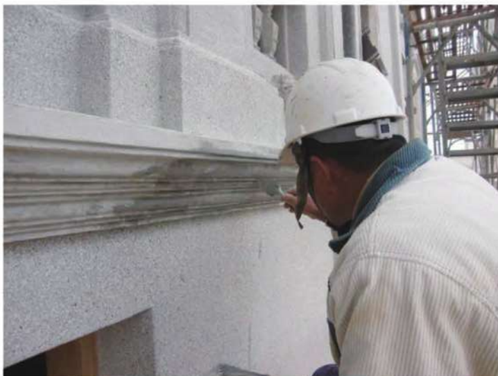
照片- 285：線角灰泥飾帶施作
