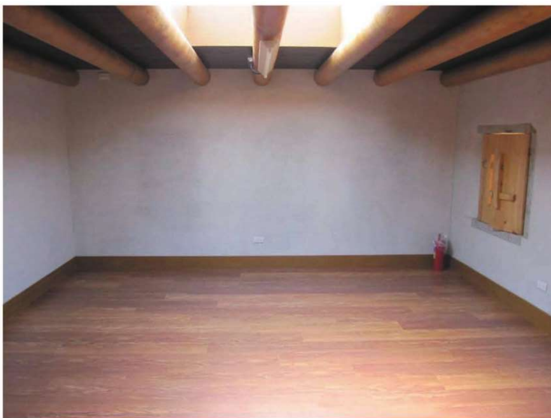
二樓左房-修復後
