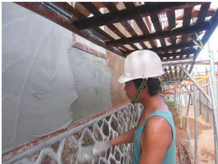
照片- 93：外壁麻絨灰漿粉刷
