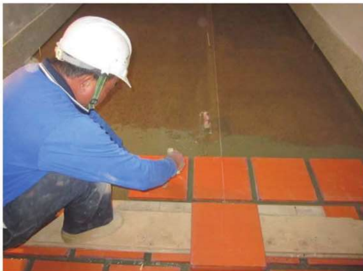
照片- 117：依分金線尺磚丁字鋪
