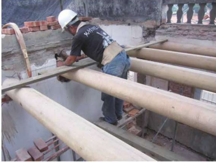
照片- 163：屋頂桁木上架及校正(洋樓)
