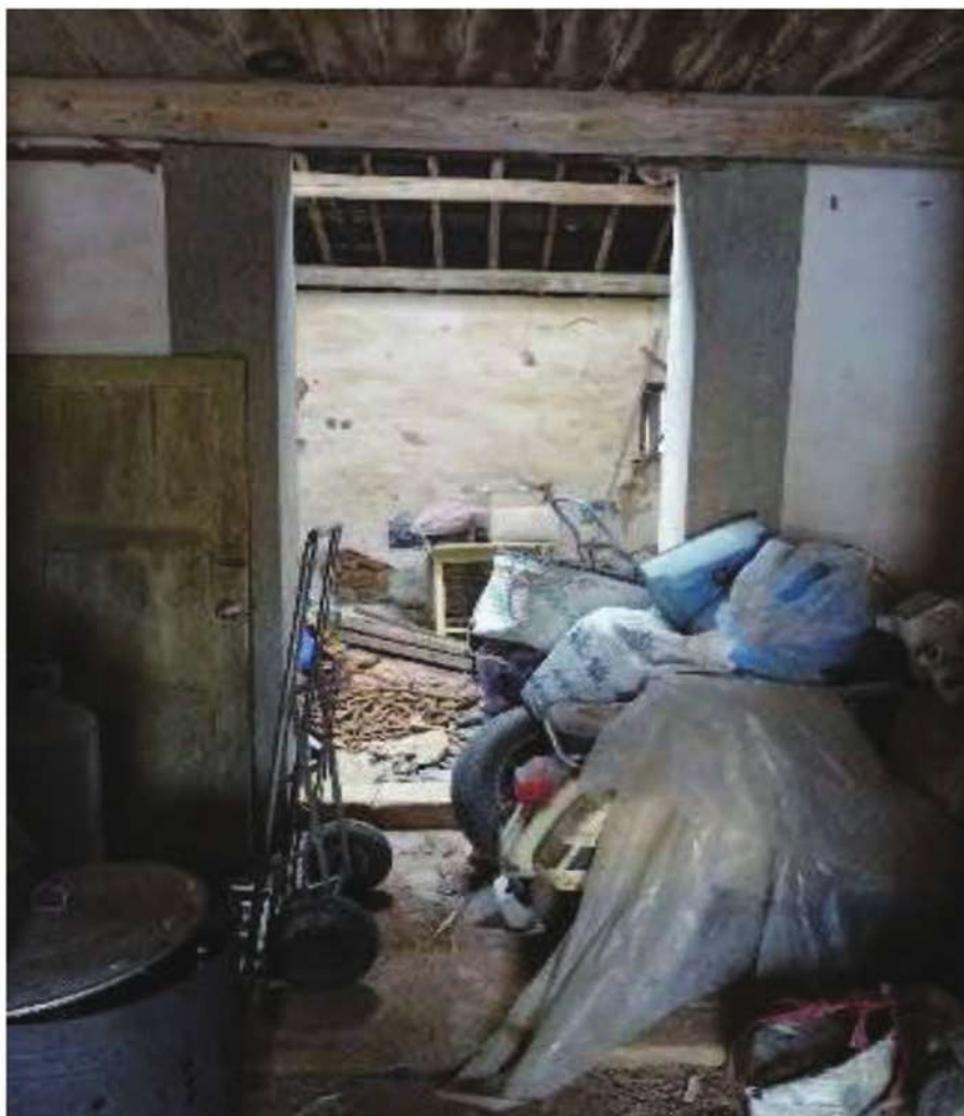
照片-13：正間後方入口現況
