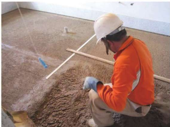
照片- 113：地坪整平後三合土打底整平
