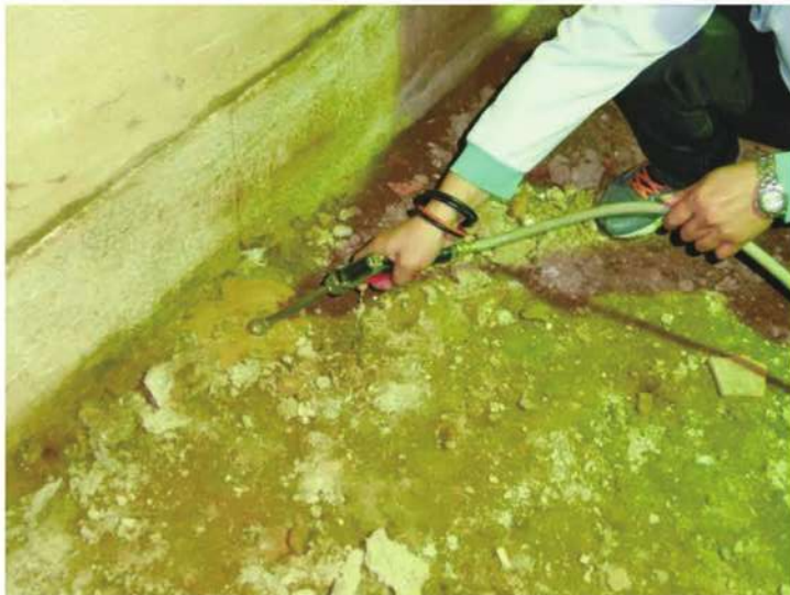
照片- 331：牆身阻絕帶-機械加壓灌注
