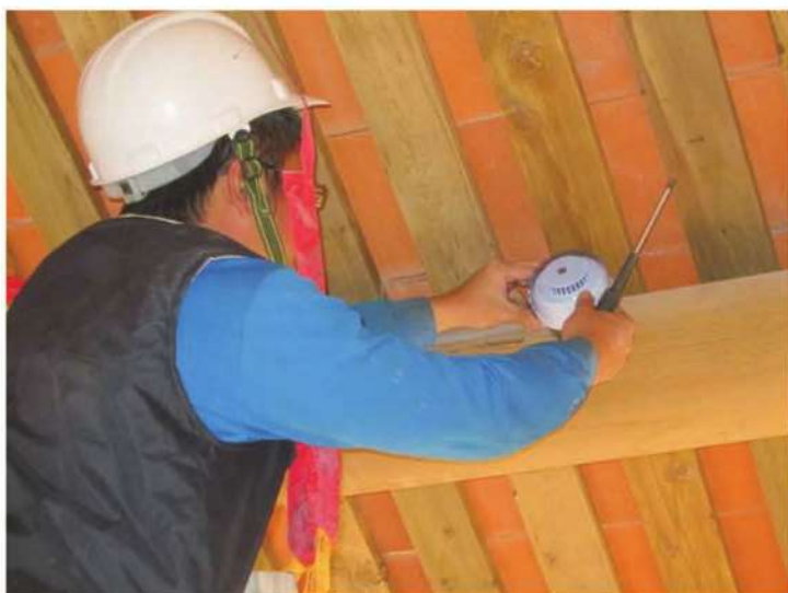
照片- 324：消防設備安裝
