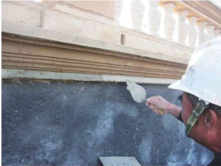
照片- 277：線角灰泥飾帶施作
