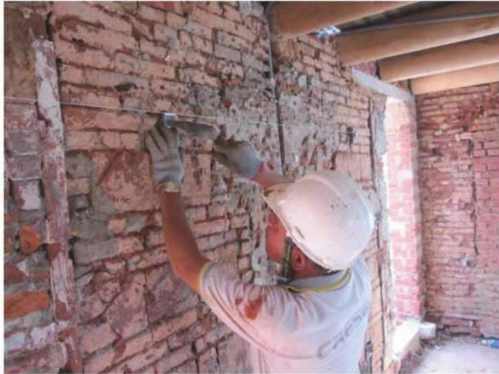
照片- 79：壁面灰誌及吊線
