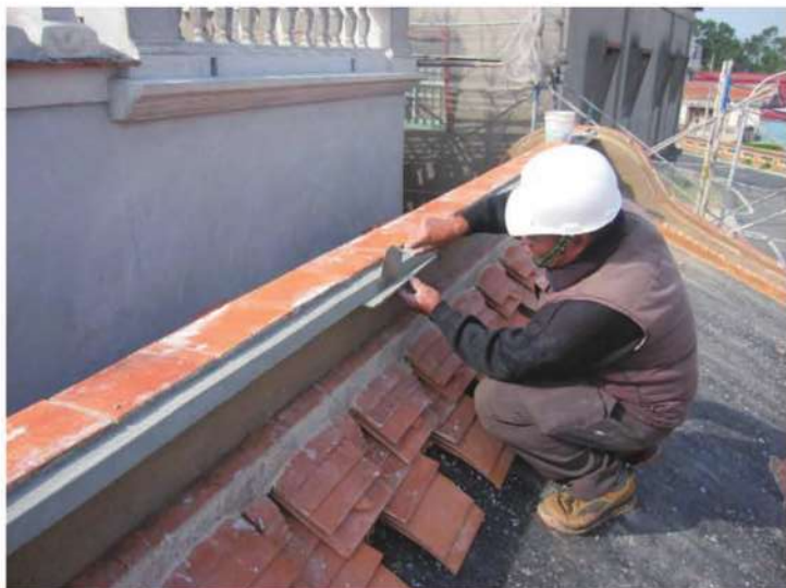
照片- 221：屋脊壓磚灰漿收邊粉光(後落)
