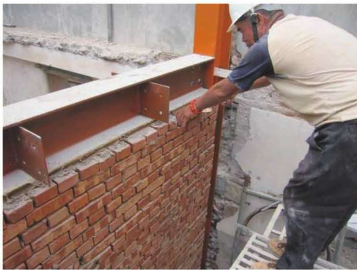
照片- 61：新砌紅磚牆體
