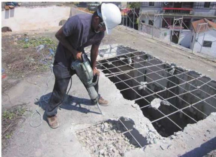
照片- 46：屋頂版 RC 構造打除
