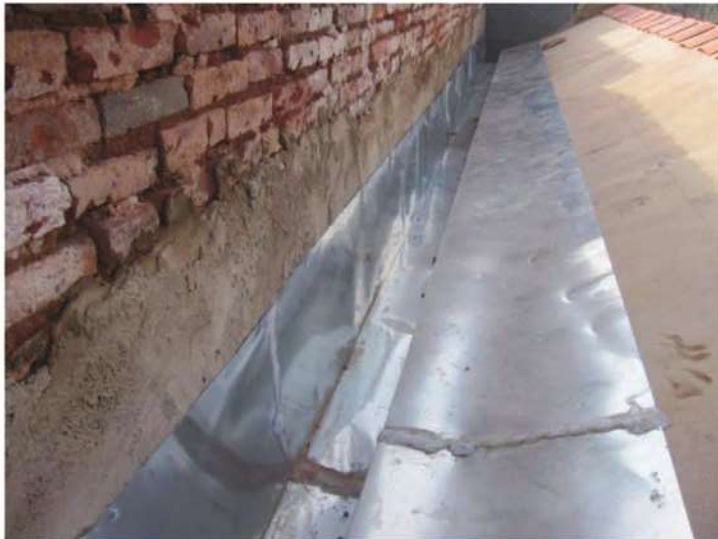
照片- 207：不銹鋼天溝安裝完成(後落)
