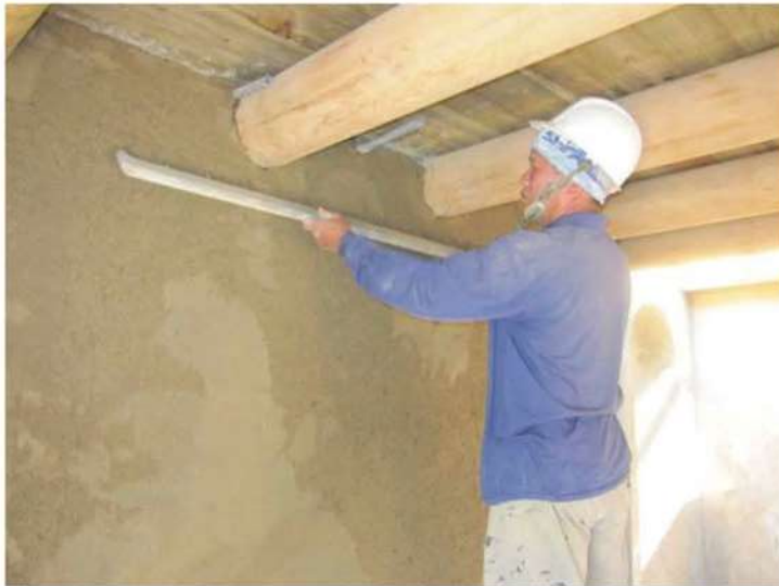
照片- 83：內壁三合土粉刷面整平
