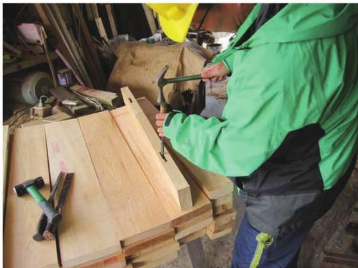
照片- 190：窗框樺頭加工製作
