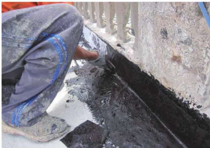
照片- 252：地面與牆面垂直角補強(洋樓)
