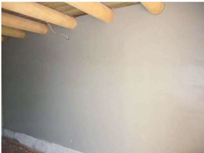
照片- 90 : 內壁麻絨灰漿粉光
