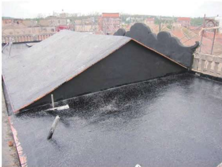
照片- 259：鋪設完成(洋樓)
