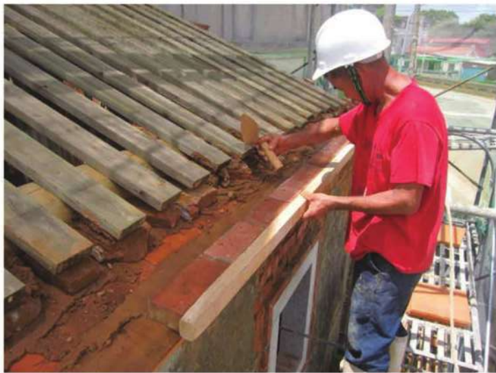
照片- 199：三層出簷磚施作(後落)
