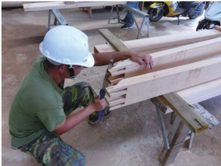
照片- 182：木製門框加工製作
