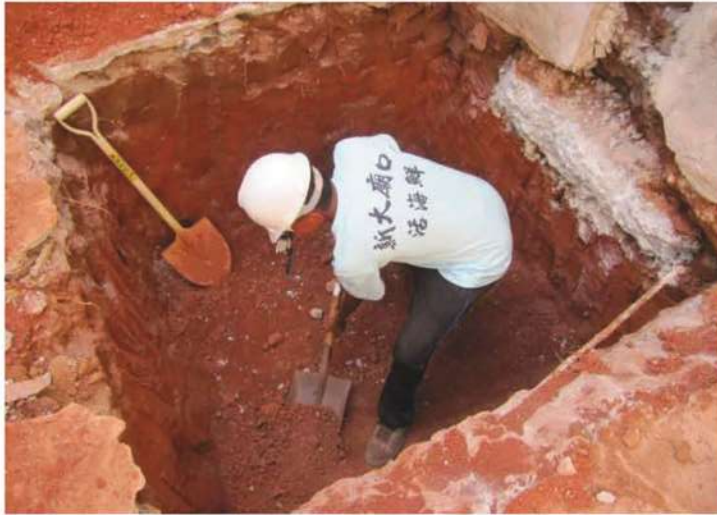
照片- 51 : H 型鋼基礎開挖
