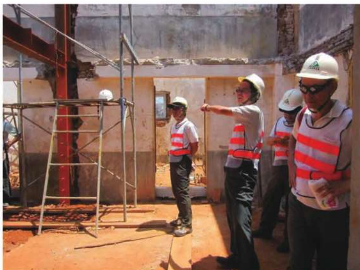
照片- 365：謝召集人偉松督導工地現況
