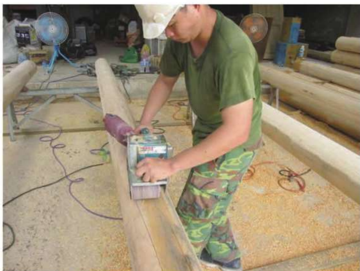
照片- 150 : 以研磨機打磨處理
