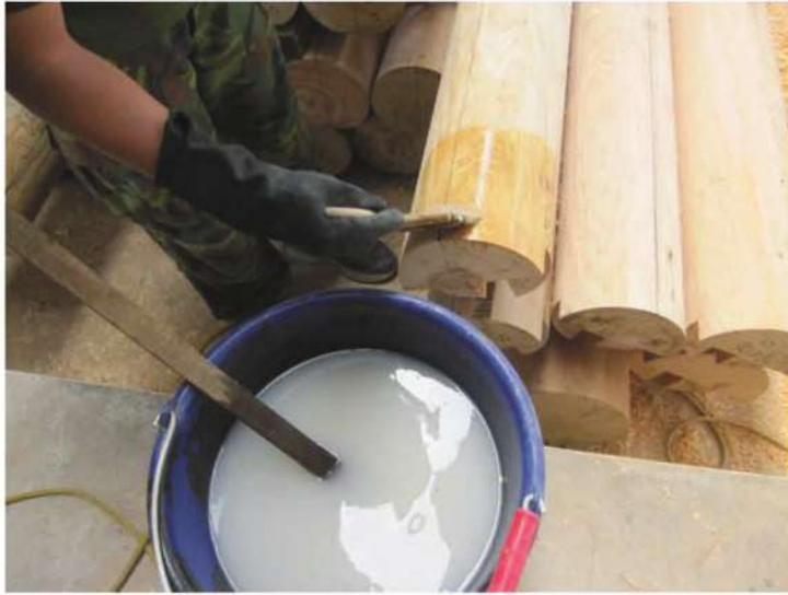
照片- 151：深入壁體之楹端塗刷防蟲防蟻
