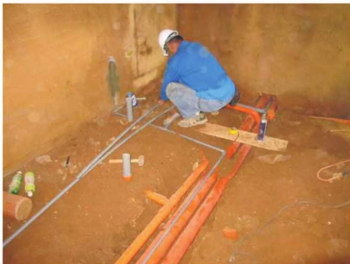
照片- 312：水電管路佈置
