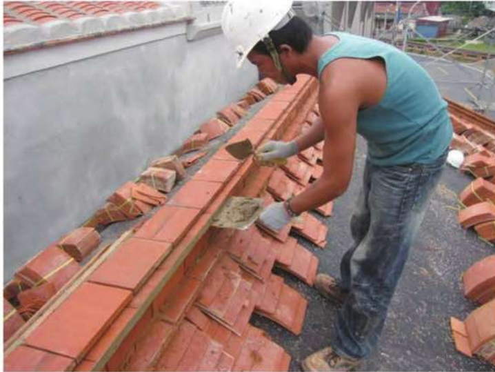
照片- 218：屋脊蓋磚須以三合土填實(後落)
