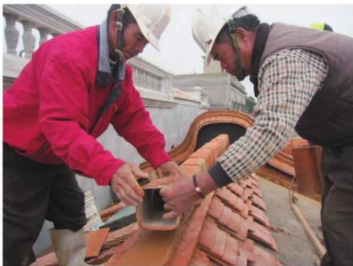
照片- 216：安置脊涵(後落)
