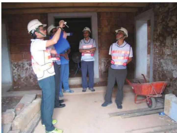
照片- 369：謝召集人偉松督導工地現況
