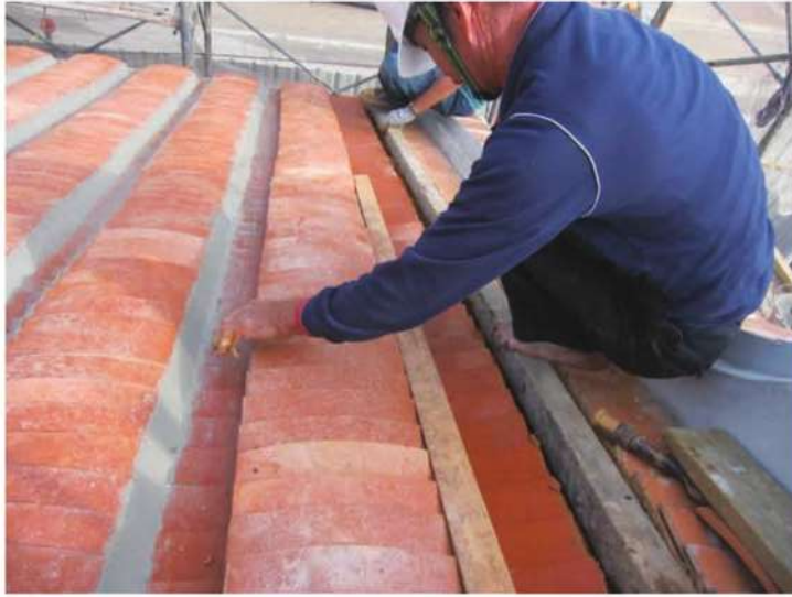
照片- 230：以導尺調校瓦面(後落後坡)
