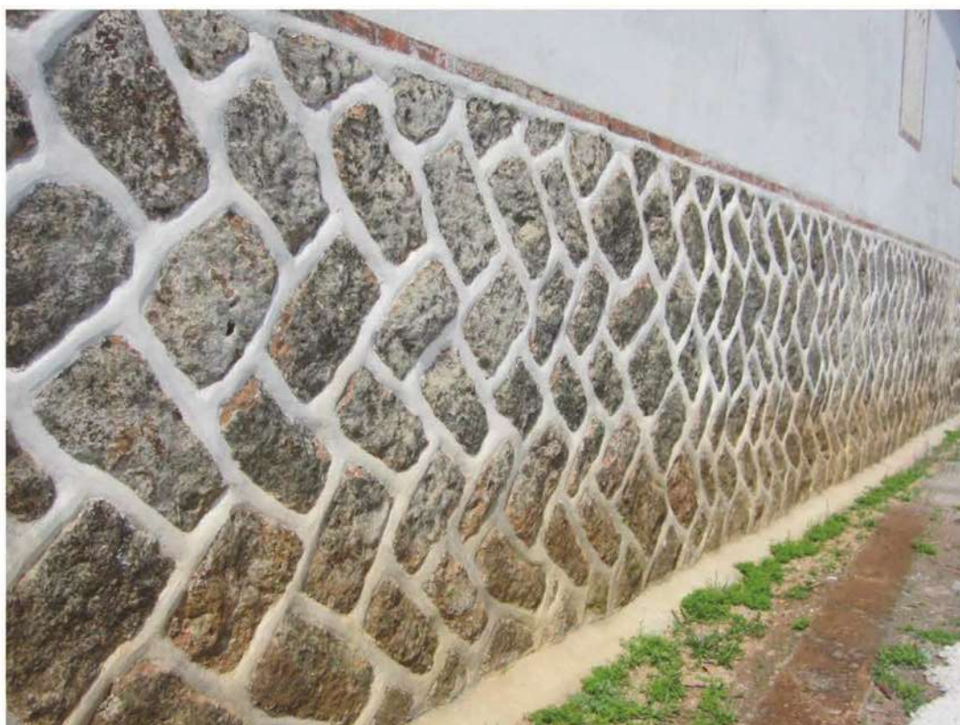
後側米香石(玄武岩)台度-修復後
