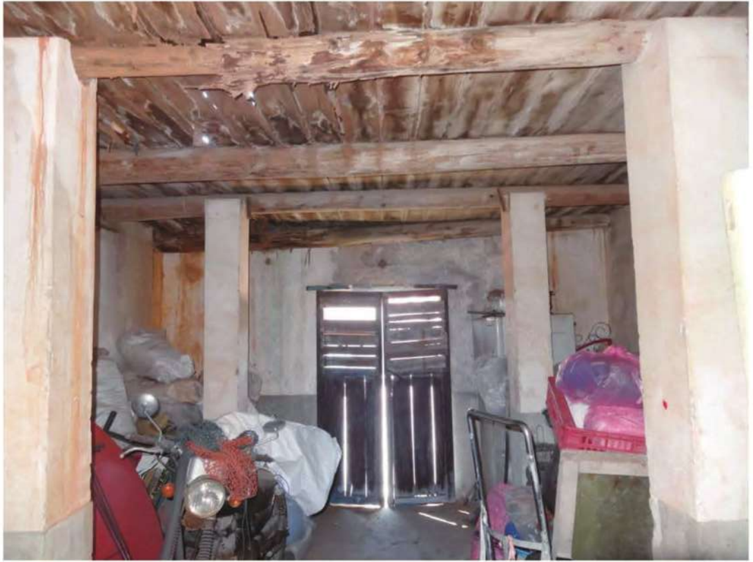
一樓門廳-修復前
