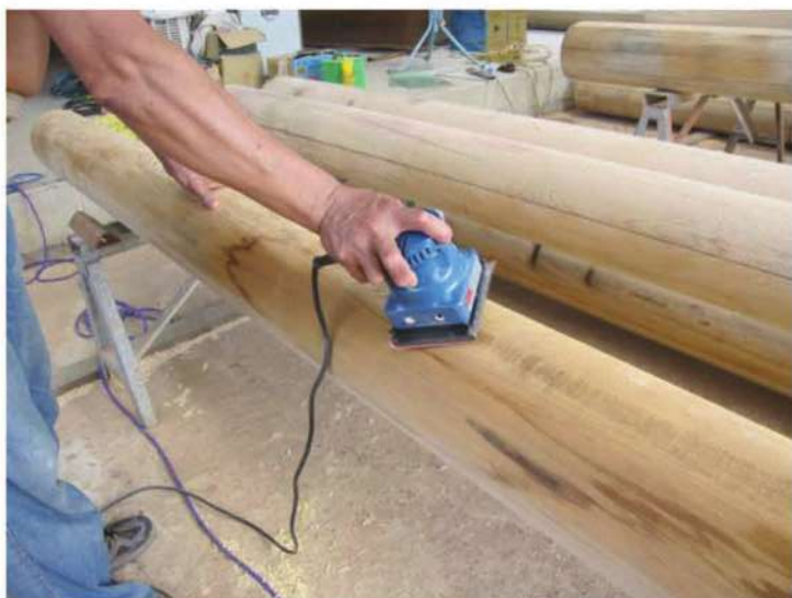
照片- 149 : 以研磨機打磨處理
