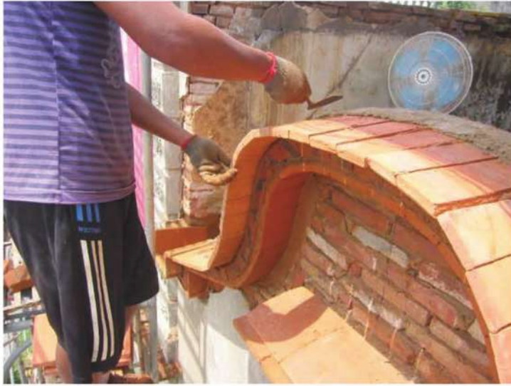
照片- 200：規帶出簷磚施作(後落)
