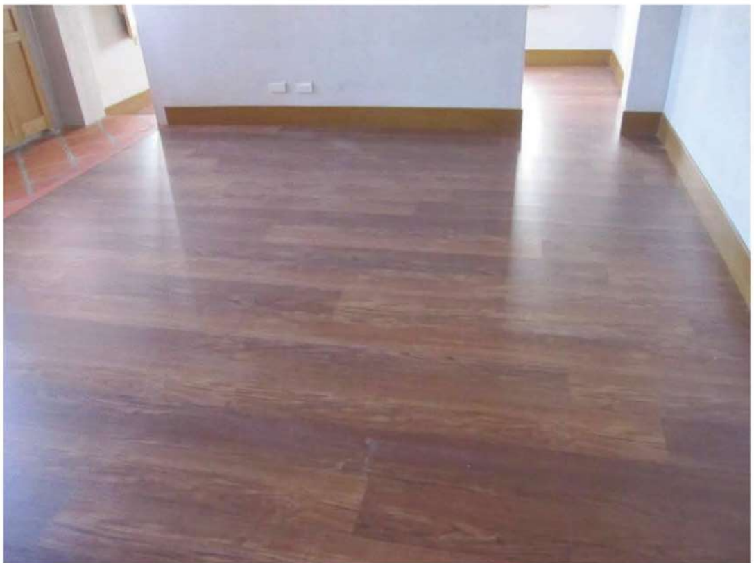
二樓大廳地坪-修復後
