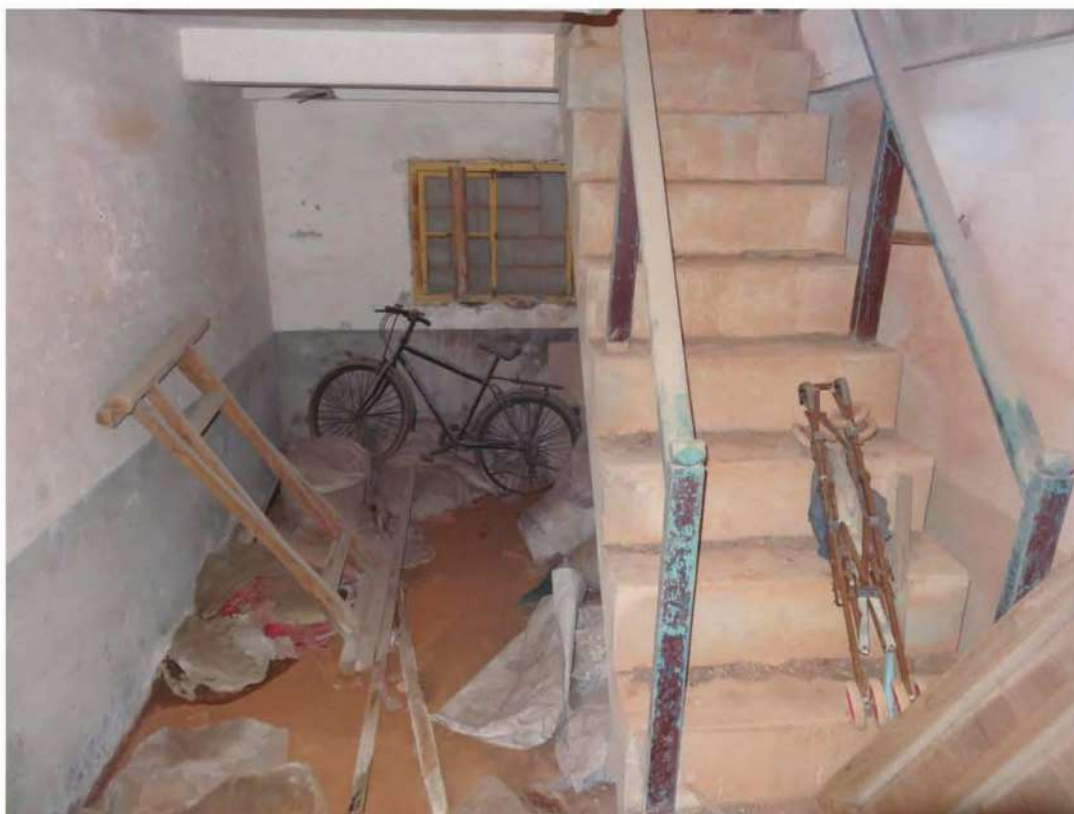
通往二樓樓梯-修復前
