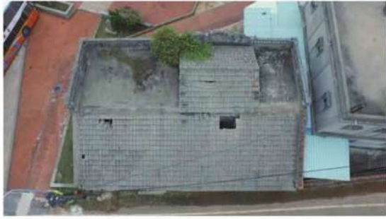
照片- 17：養拙樓屋頂空拍圖
