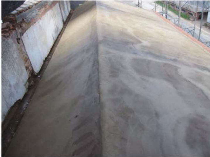
照片- 206：於養瓦上鋪設三合土(後落)
