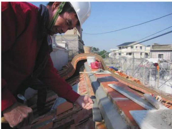
照片- 220：屋脊壓磚灰漿收邊粉光(後落)
