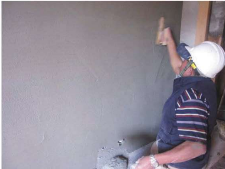
照片- 89 : 內壁麻絨灰漿粉光
