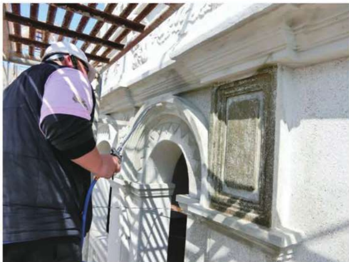
照片- 350：外牆噴塗防護劑
