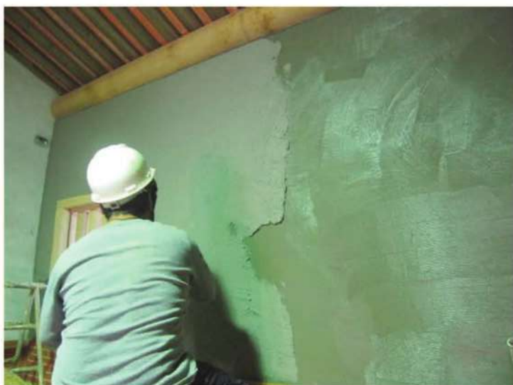
照片- 87：內壁麻絨灰漿粉光
