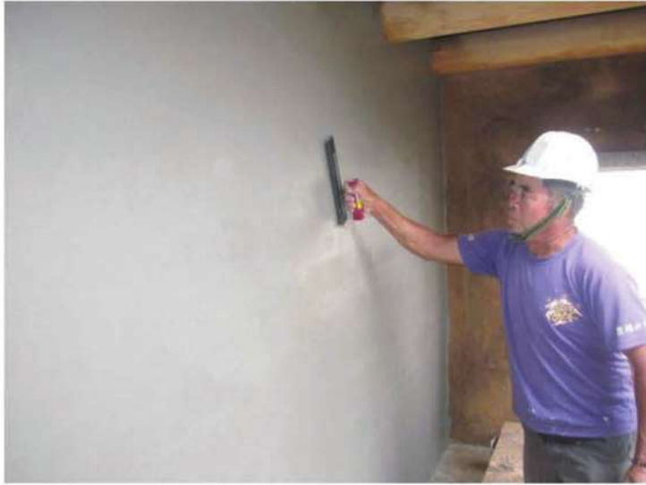
照片- 88 : 內壁麻絨灰漿粉光
