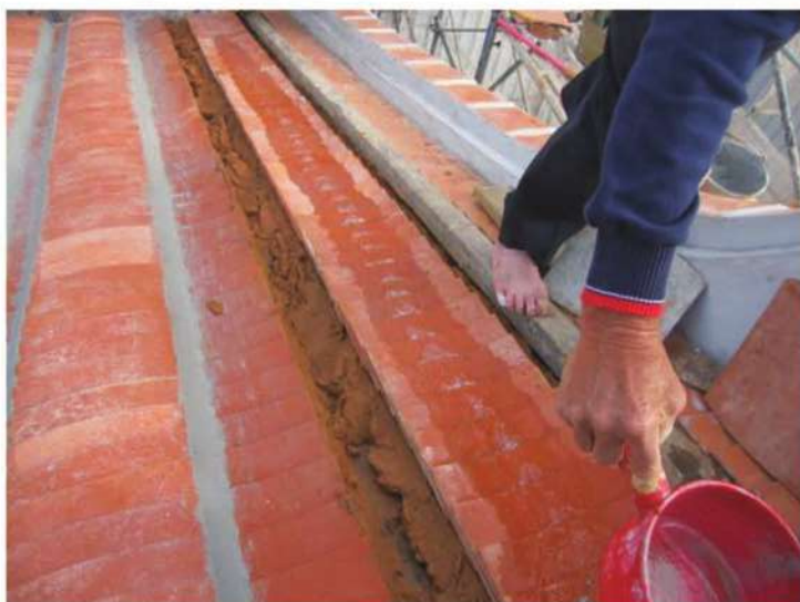
照片- 228：試水路：將水由頂端徐徐倒於仰瓦凹處，觀察水流是否順暢 (後落後坡)
