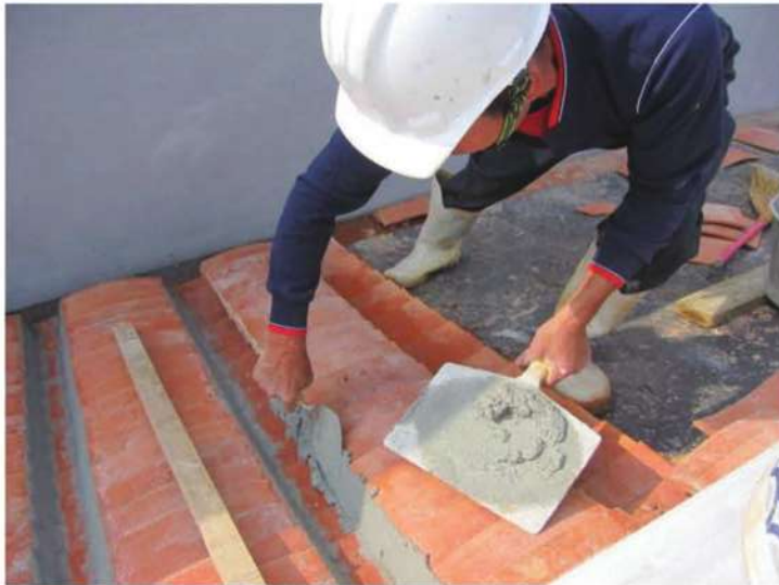
照片- 237：瓦溝及縫隙以灰漿勾縫收邊(後落前坡)
