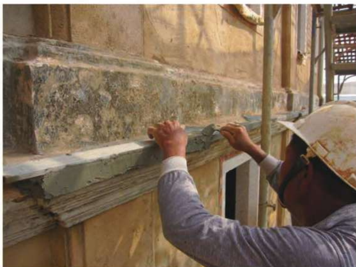
照片- 275：線角出磚修補及表面粉刷
