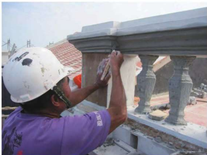
照片- 268：女兒牆欄杆飾帶施作
