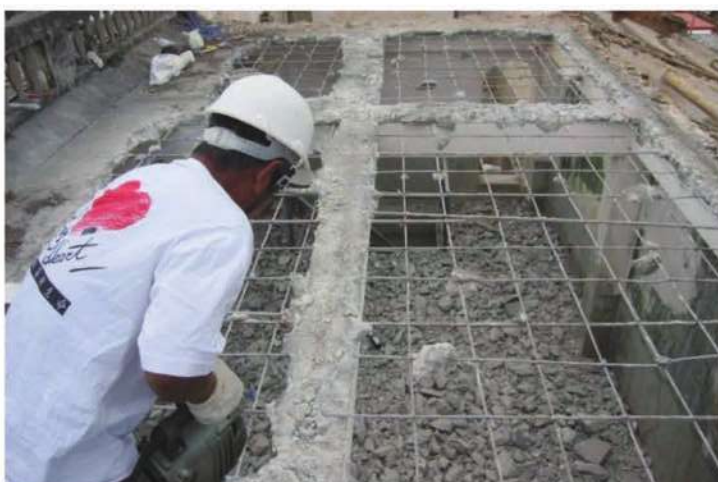
照片- 47：屋頂版 RC 構造打除
