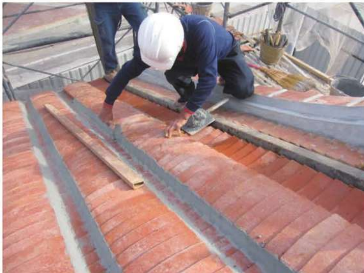
照片- 231：瓦溝及縫隙以灰漿勾縫收邊(後落後坡)
