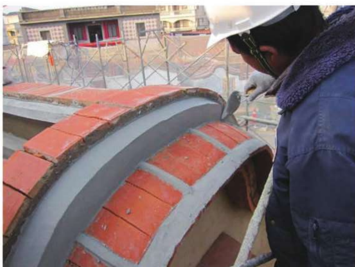
照片- 223：規帶灰漿收邊粉光(後落)
