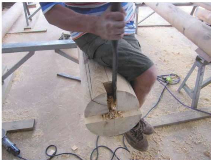
照片- 144：桁木樺頭開鑿及修正
