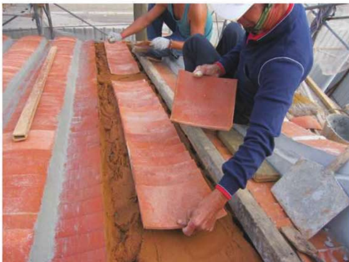
照片- 226：底瓦逐片鋪貼於三合土，使瓦及屋面相互黏著(後落後坡)
