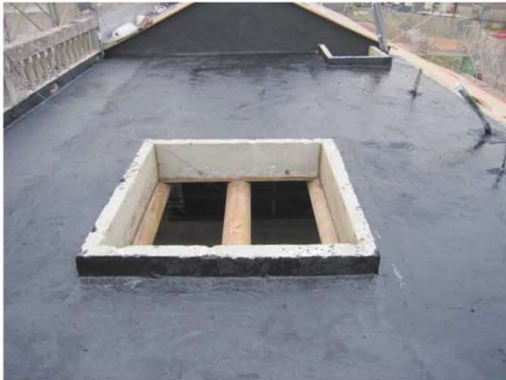
照片- 256：第一層鋪設完成(洋樓)
