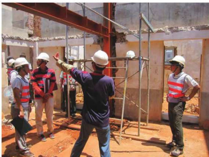
照片- 366：承包商工地主任現場說明
