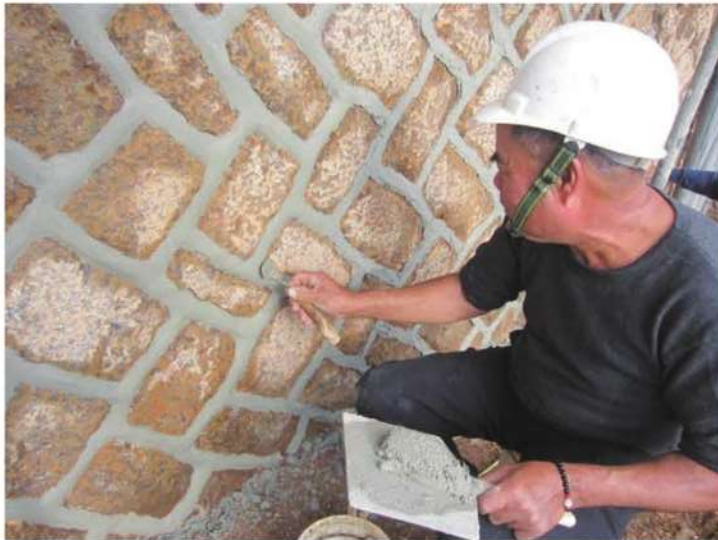
照片- 76 : 石砌牆台度灰漿勾縫
