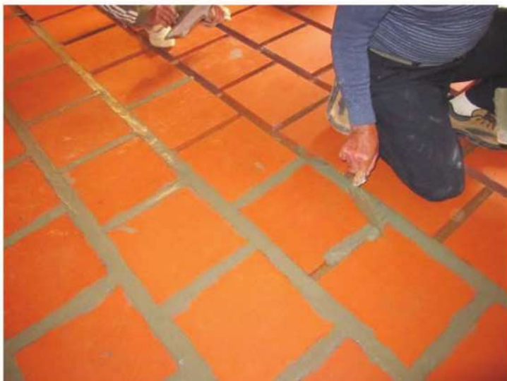
照片- 122：地坪尺磚鋪貼後灰漿勾縫
