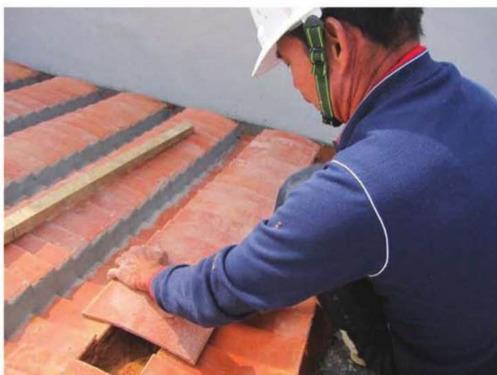
照片- 234：兩槽仰瓦間鋪合瓦(後落前坡)
