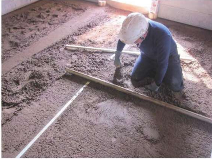
照片- 114：地坪整平後三合土打底整平
