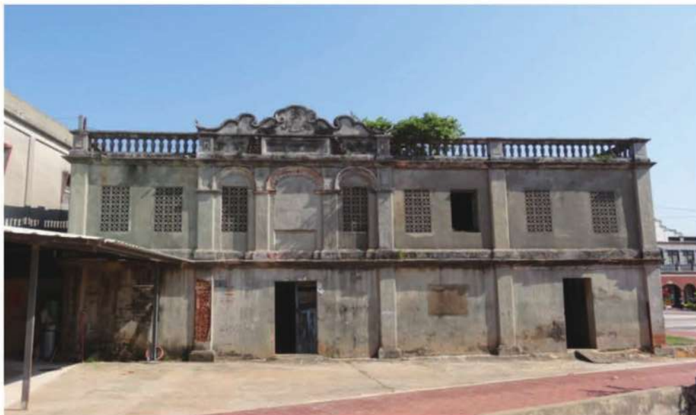
照片-1：養拙樓現況立面
