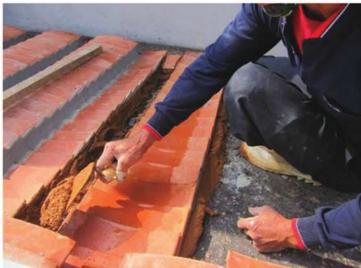
照片- 233：於兩槽仰瓦之間填置三合土(後落前坡)
