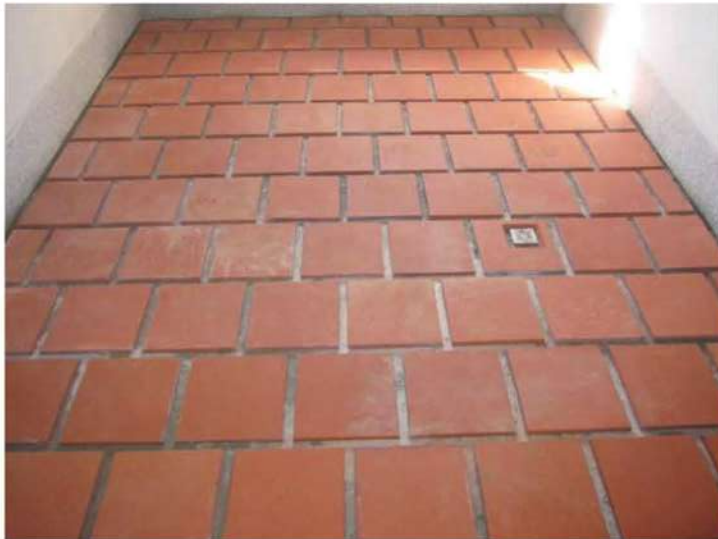
照片- 121：地坪尺磚丁字鋪完成
