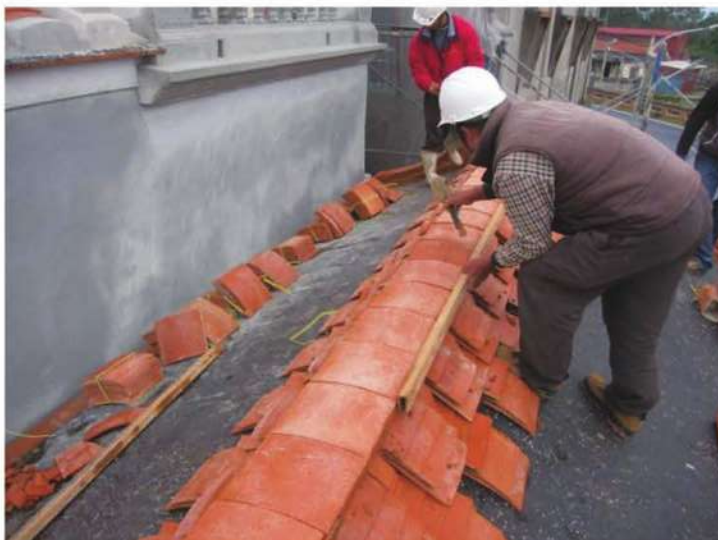
照片- 214：調整脊底瓦片（後落）
