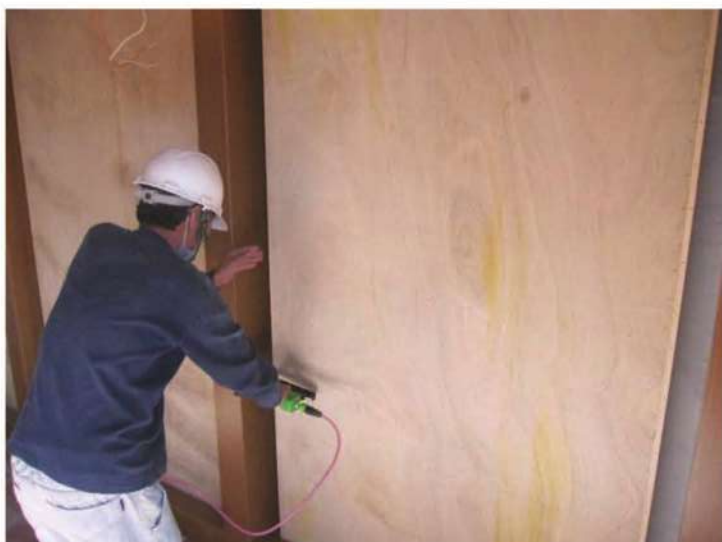
照片- 300：展示面板施作
