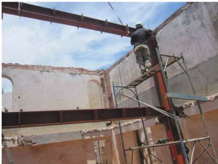
照片- 55 : H 型鋼橫樑吊裝組立
