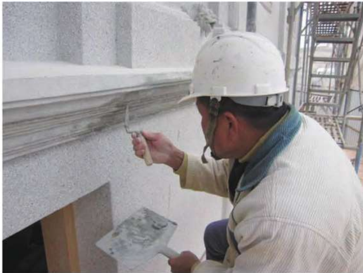
照片- 284：線角灰泥飾帶施作
