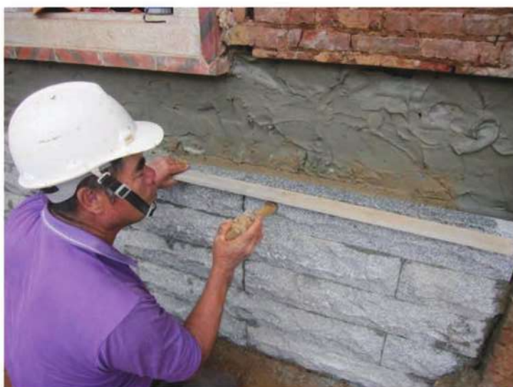
照片- 67：正立面花崗石台度施作
