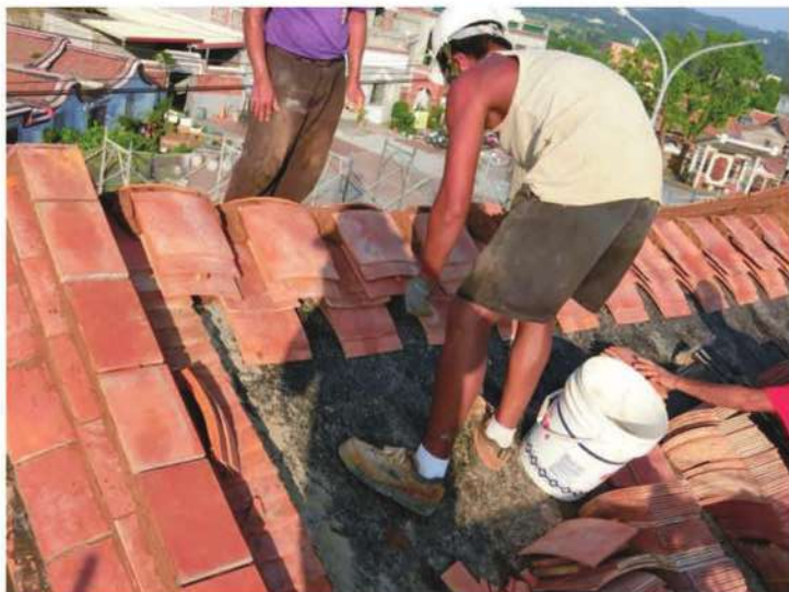
照片- 239 : 屋脊施作(洋樓)
