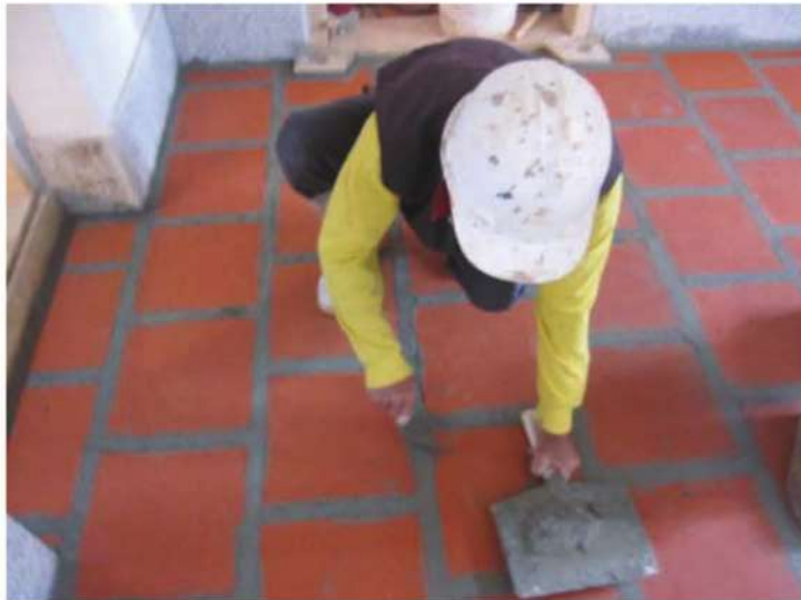
照片- 124：地坪尺磚鋪貼後灰漿勾縫
