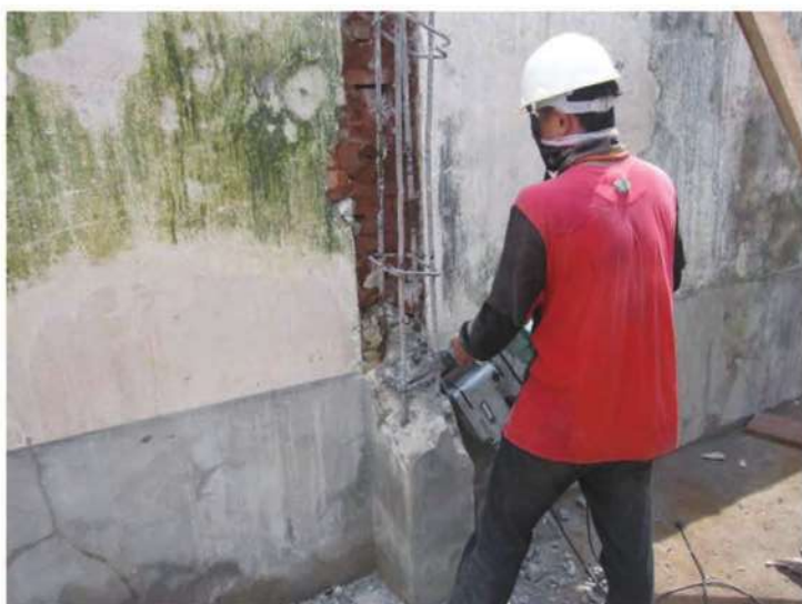
照片- 50：一樓柱、樑 RC 構造打除
