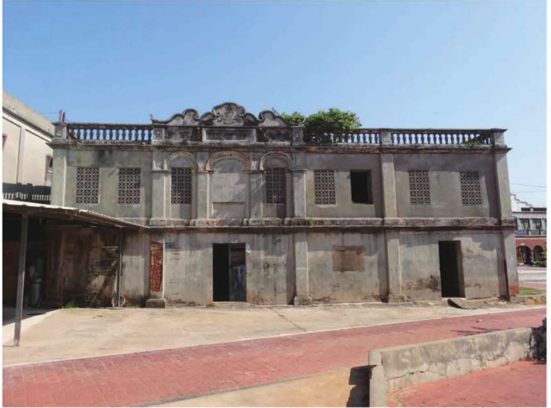
正立面-修復前
