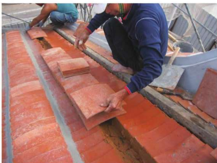
照片- 229：兩槽仰瓦間鋪合瓦(後落後坡)
