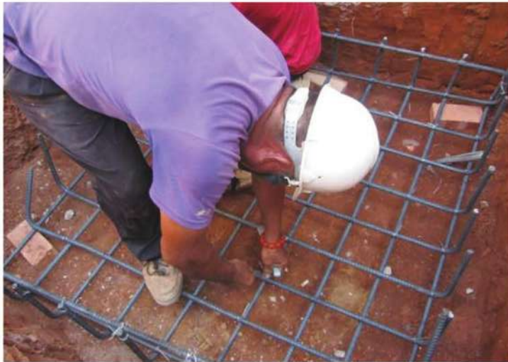
照片- 52 : H 型鋼基礎鋼筋綁紮
