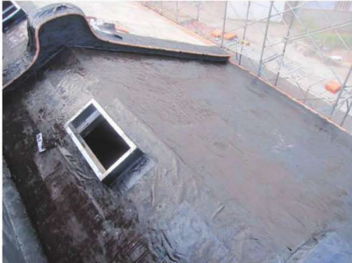
照片- 262：第一層鋪設完成(後落)
