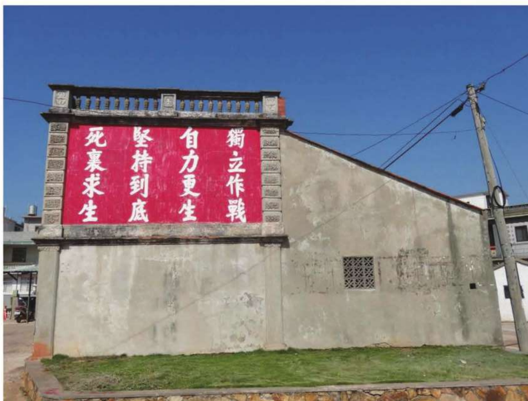
左側立面-修復前
