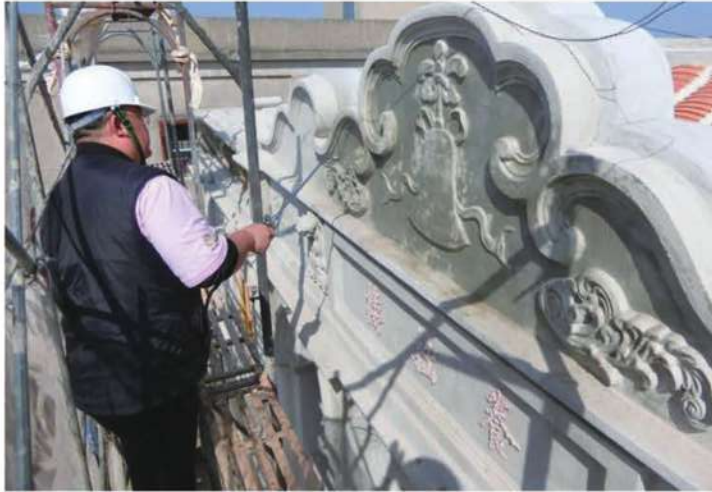
照片- 347：外牆噴塗防護劑
