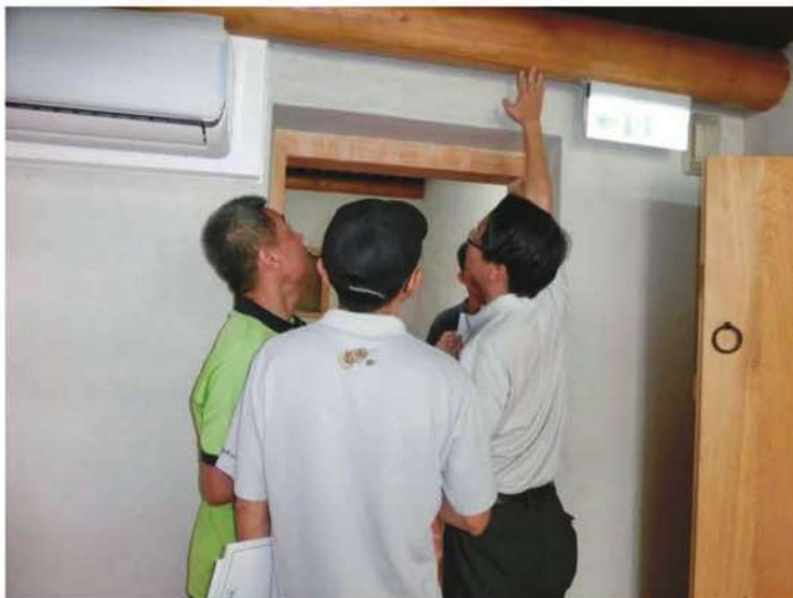
照片- 382：主辦機關、監造單位、承攬廠商合同複驗
