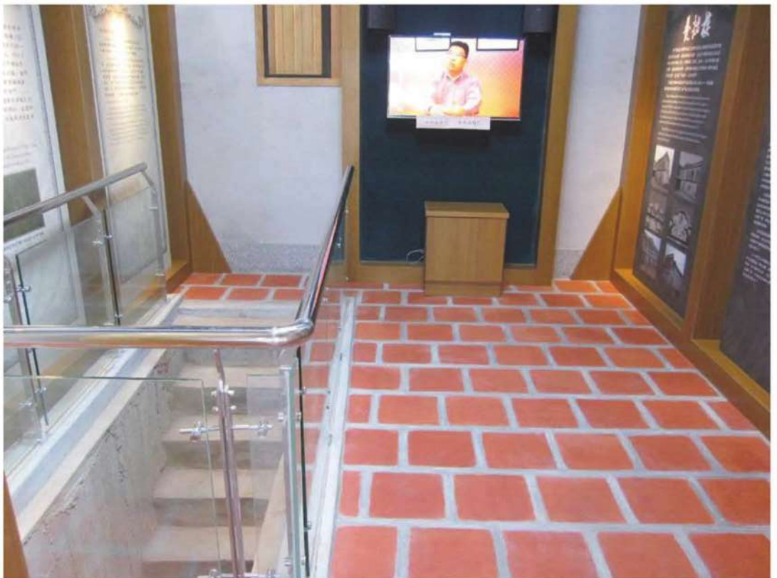
後落左外房及民防通道入口階梯-修復後
