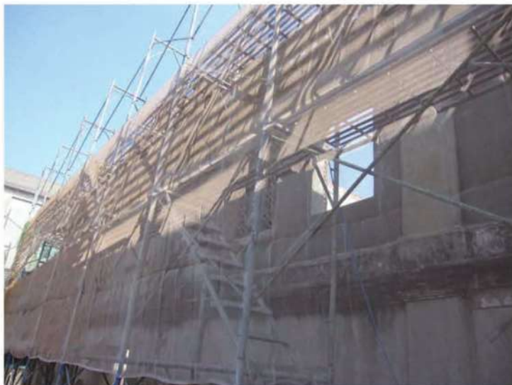
照片- 39：施工鷹架搭設
