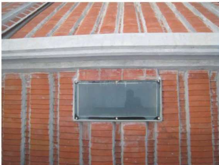
照片- 250：斜屋頂天窗施作完成
