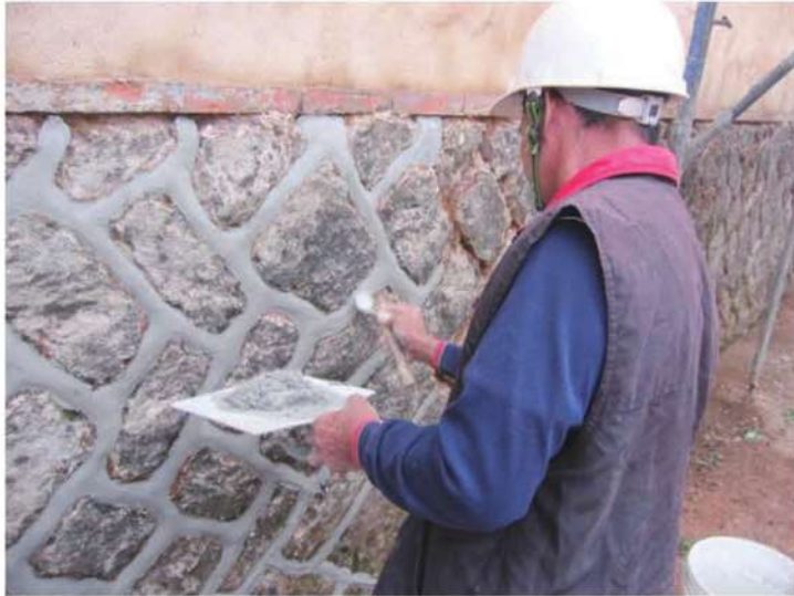
照片- 75 : 石砌牆台度灰漿勾縫
