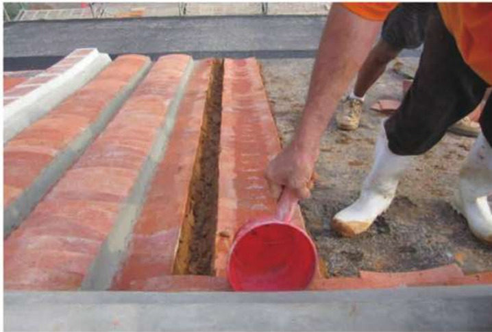
照片- 243：試水路：將水由頂端徐徐倒於仰瓦凹處，觀察水流是否順暢 (洋樓)
