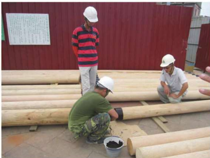
照片- 153：楹端防蟲防腐處理
