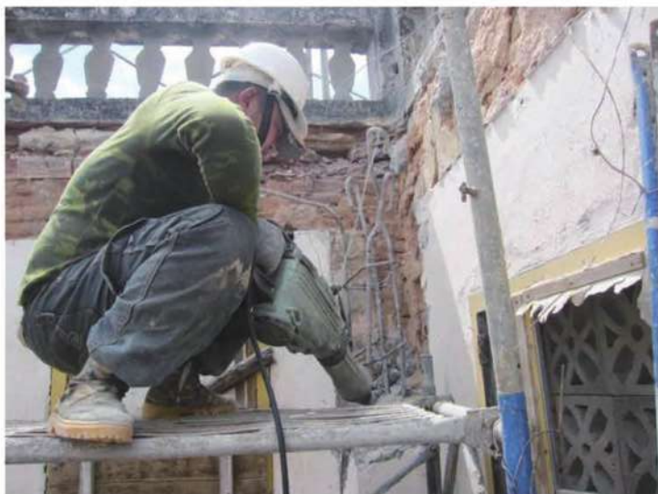
照片- 49：二樓柱、樑 RC 構造打除
