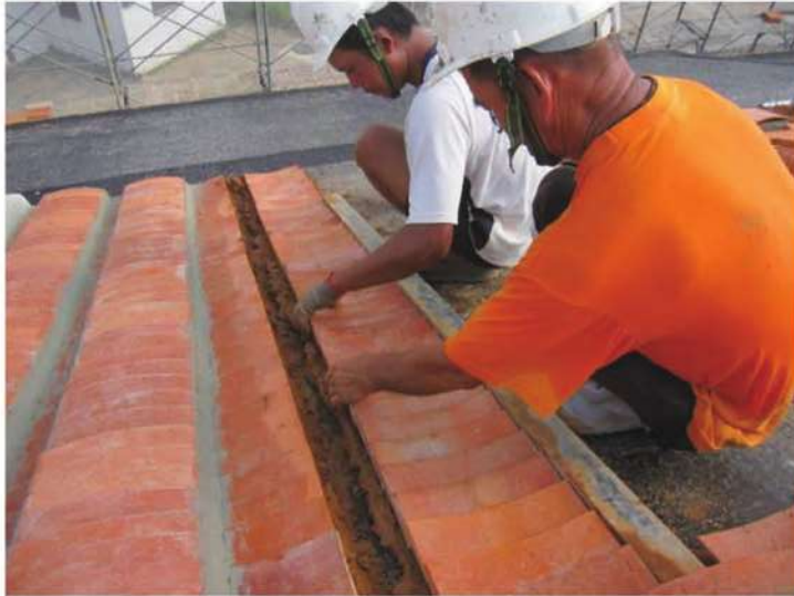
照片- 242：將底瓦逐片鋪貼於三合土，使瓦及屋面相互黏著(洋樓)
