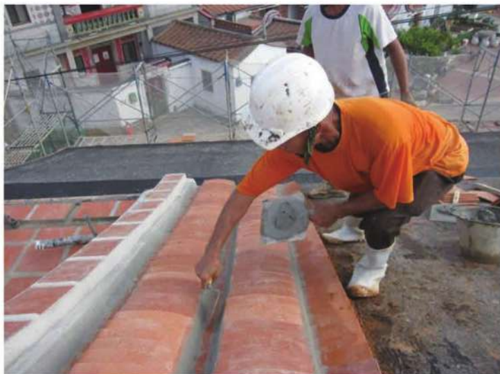
照片- 245：瓦溝及縫隙以灰漿勾縫(洋樓)
