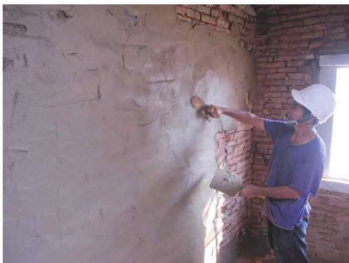
照片- 81：內壁三合土粉刷打底
