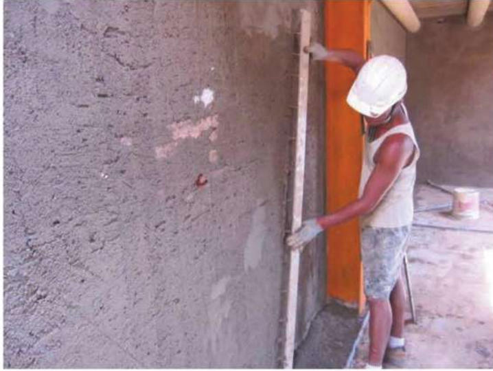
照片- 82：內壁三合土粉刷面整平
