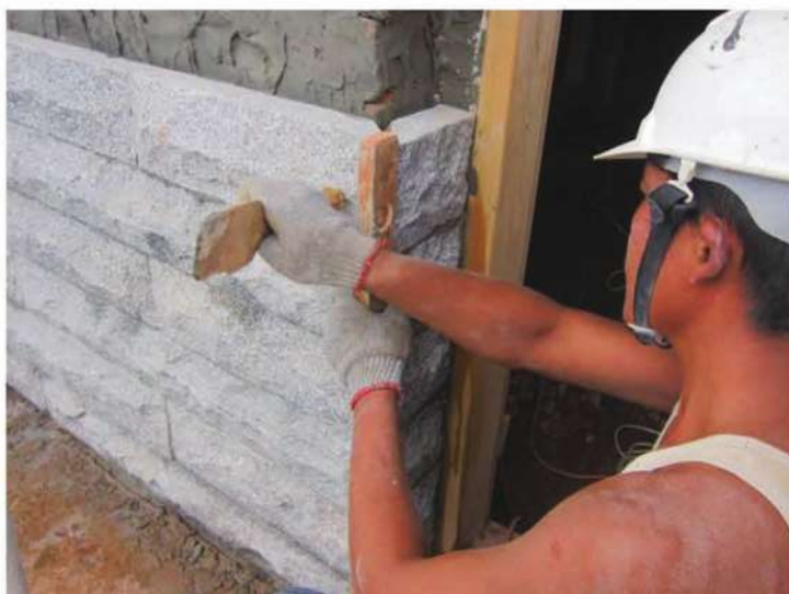
照片- 68：正立面花崗石台度施作
