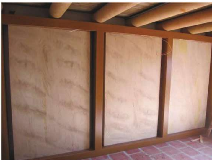
照片- 303：展示面板施作
