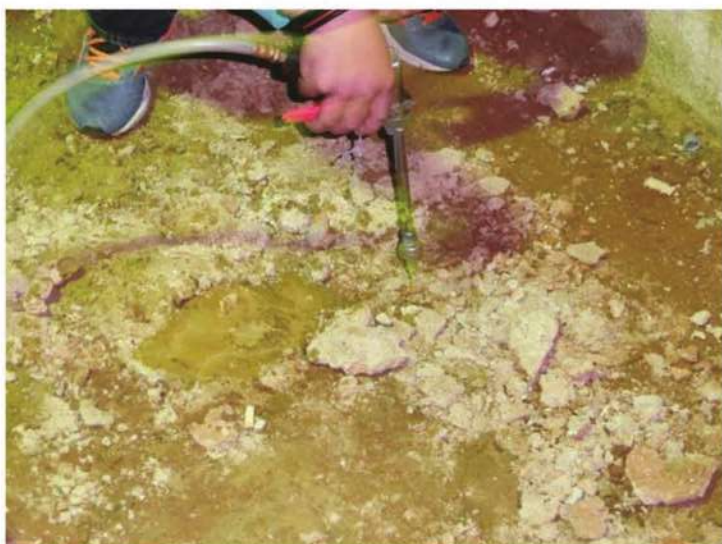
照片- 334 : 牆身阻絕帶-機械加壓灌注
