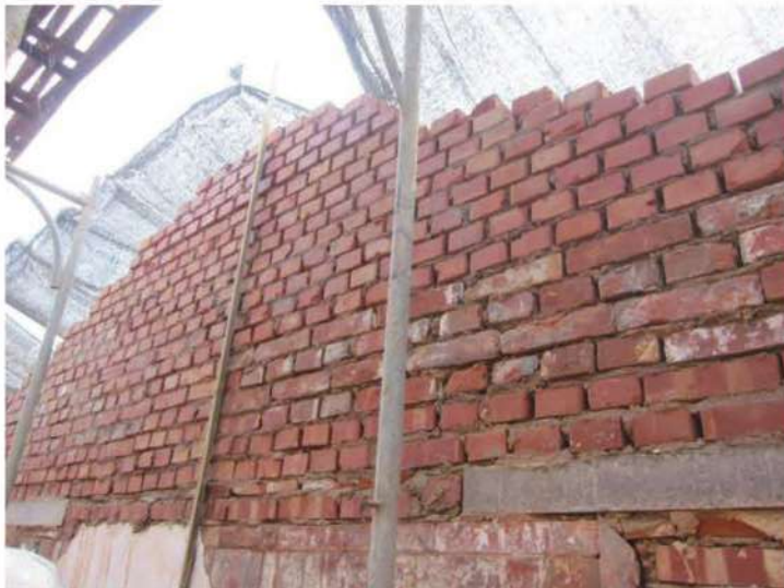
照片- 63：洋樓山牆砌紅磚牆
