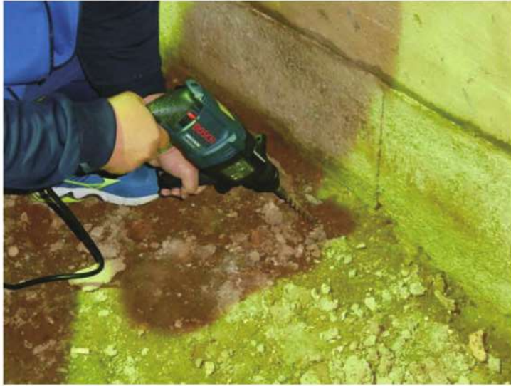
照片- 329：牆身阻絕帶-現場鑽孔
