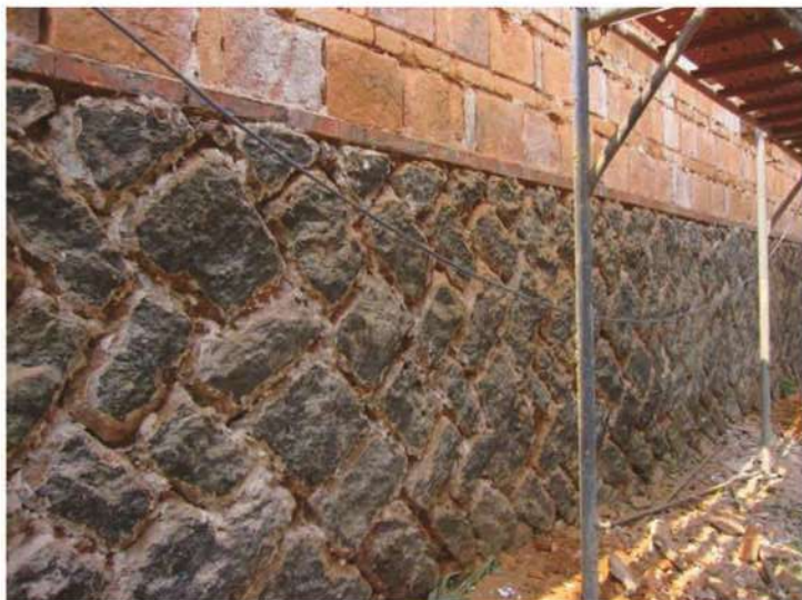
照片- 72：外壁石牆面既有灰縫打除完成
