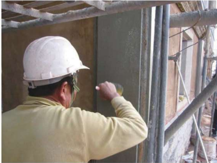
照片- 101：柱身重新蠣殼洗石子
