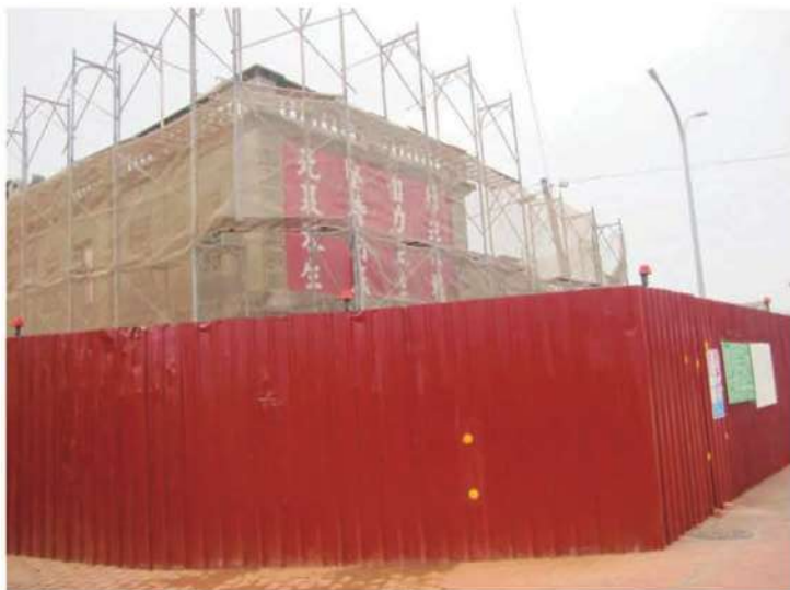
照片- 38：工地四周架設安全圍籬、施工鷹架及防護網
