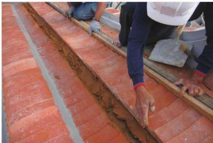
照片- 227：以導尺調校瓦面(後落後坡)
