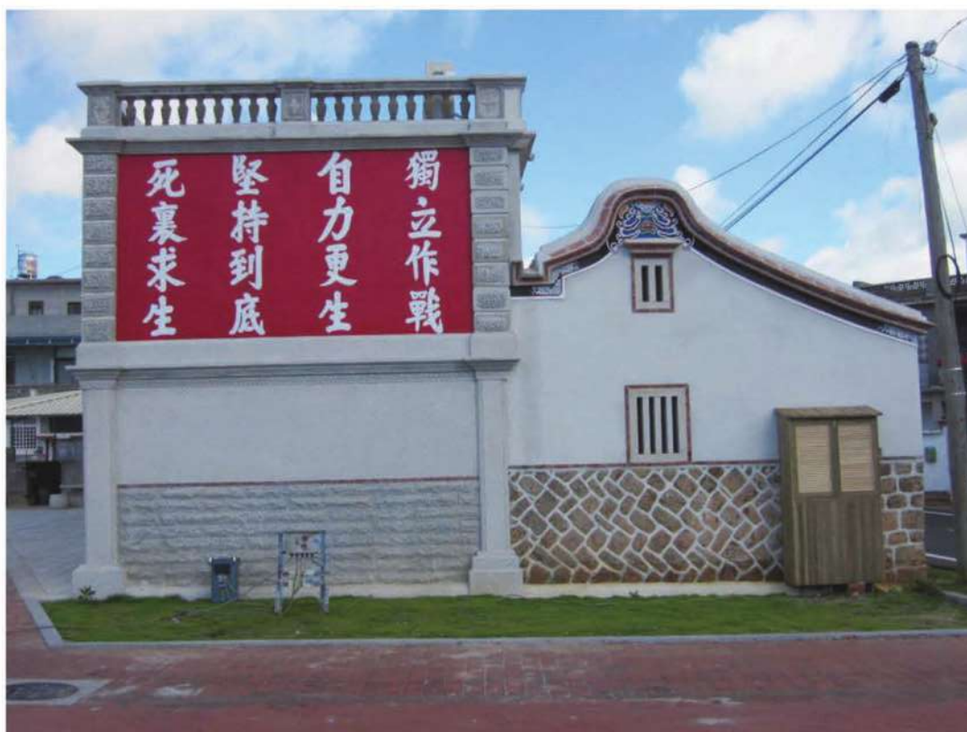
左側立面-修復後
