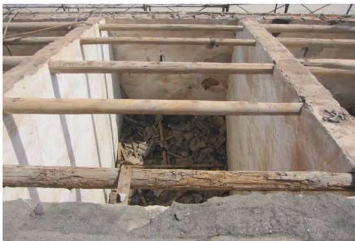
照片- 44：屋面解體清理後之樣貌
