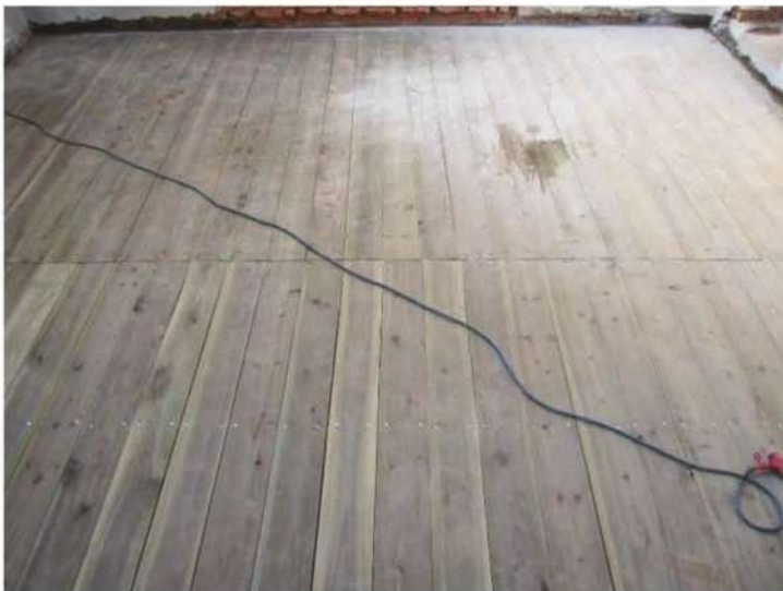
照片- 162：二樓企口板訂製完成(洋樓)
