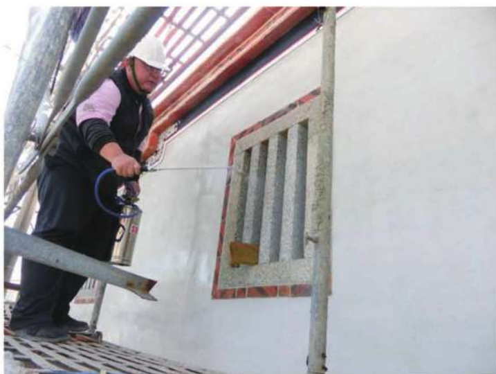
照片- 352：外牆噴塗防護劑
