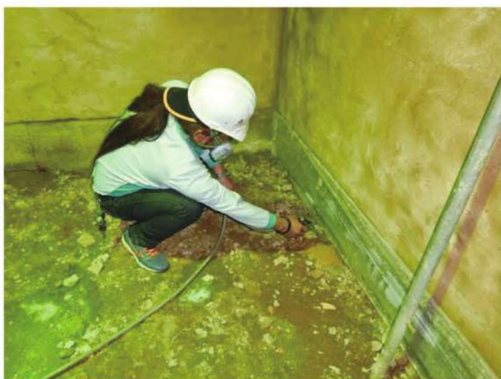
照片- 333 : 牆身阻絕帶-機械加壓灌注
