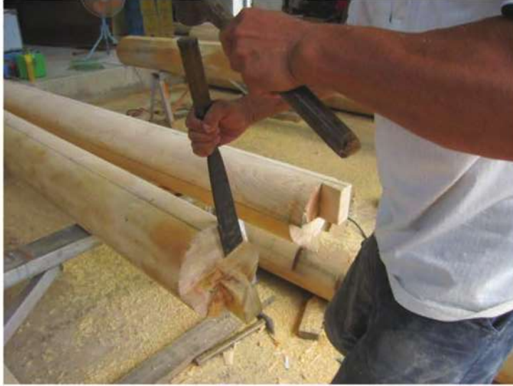
照片- 145：桁木樁頭開鑿及修正
