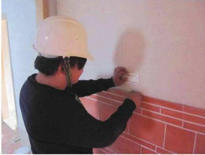
照片- 319：開關插座設備安裝
