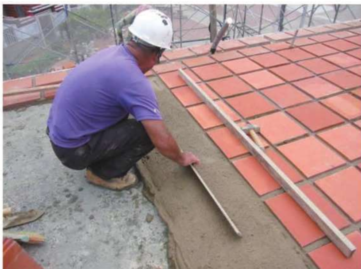
照片- 246：於三合土打底後鋪設尺磚(洋樓磚坪)
