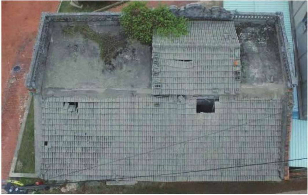
照片-11：建築空拍俯視
