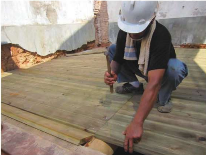
照片- 161：二樓企口板訂製(洋樓)
