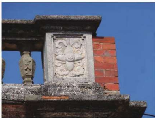
照片- 22：養拙樓女兒牆欄杆
