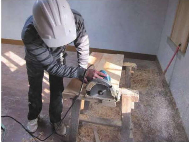
照片- 193：木板窗扇加工製作
