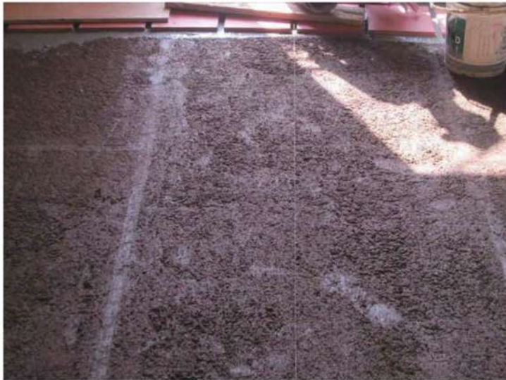
照片- 115：地坪三合土打底整平完成
