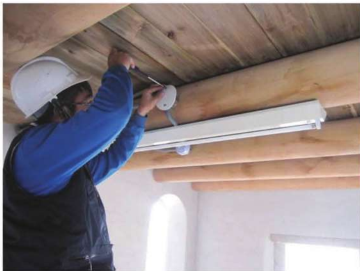
照片- 322：消防設備安裝
