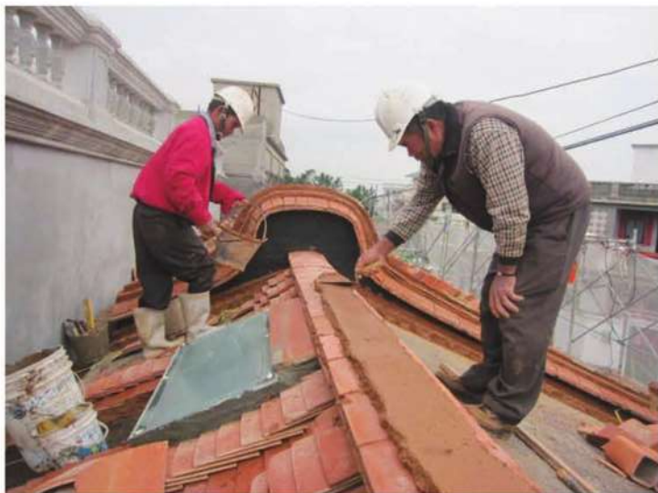
照片- 215：脊底瓦片上放置三合土(後落)
