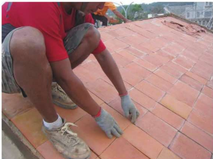
照片- 203：於桷木上鋪設養瓦 (洋樓)
