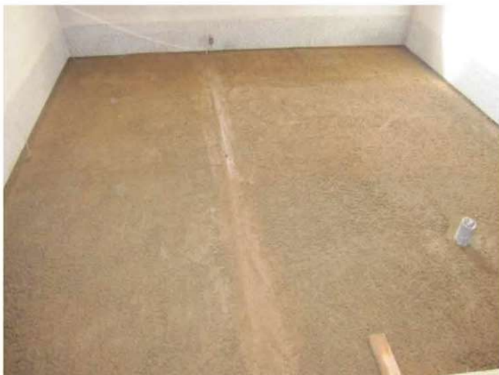
照片- 116：地坪三合土打底整平完成
