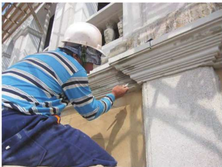
照片- 281：線角灰泥飾帶施作
