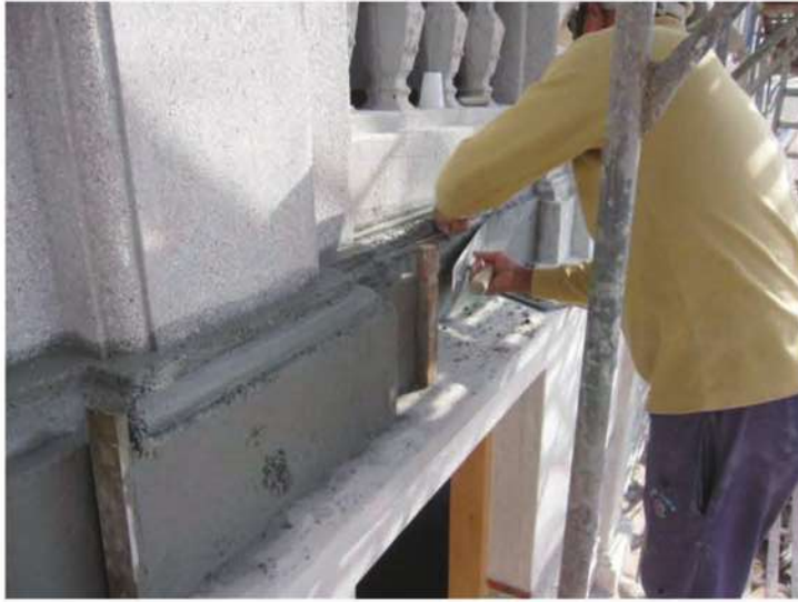
照片- 107：牆面重新蠣殼洗石子
