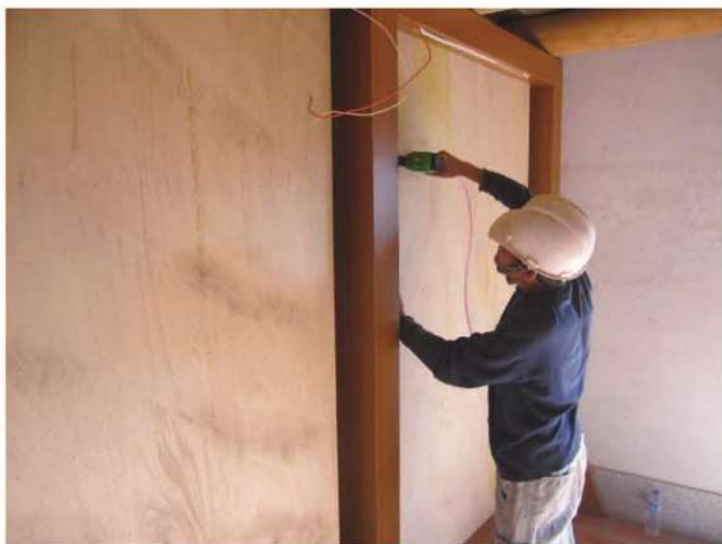
照片- 299：展示面板施作
