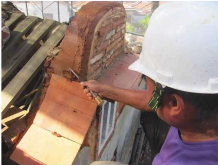
照片- 201：規帶出簷磚施作(後落)
