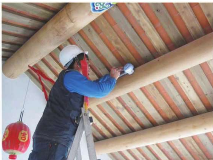
照片- 323：消防設備安裝
