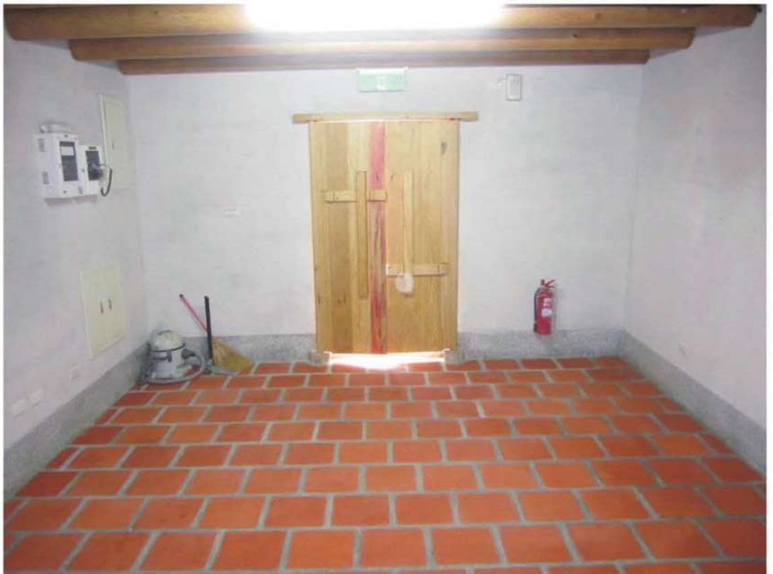
一樓門廳-修復後
