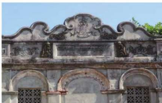
照片- 20：養拙樓正面山頭
