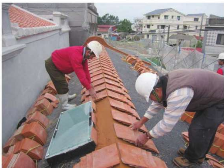
照片- 211：依瓦槽作脊底 (後落)
