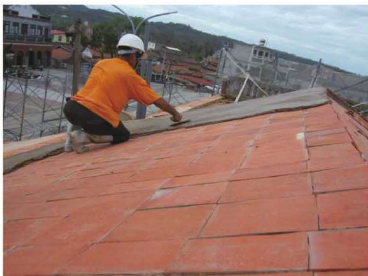
照片- 205：於養瓦上鋪設三合土(後落)
