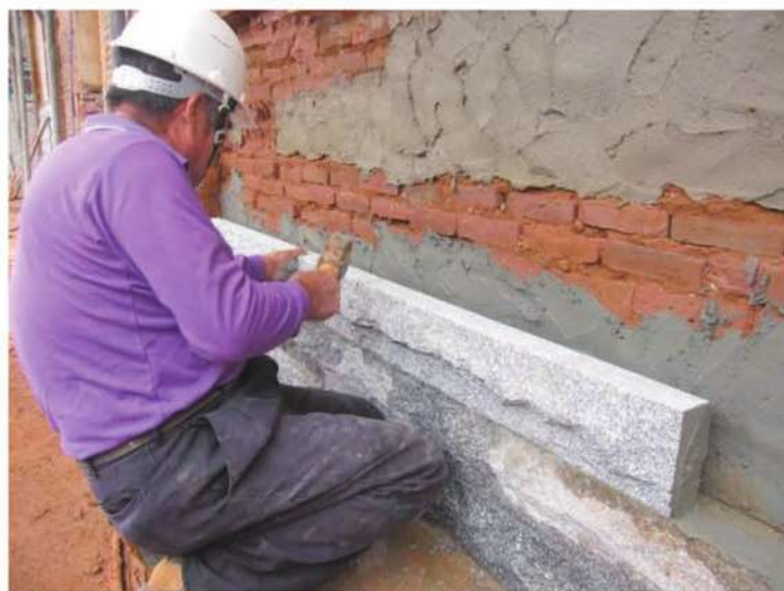
照片- 65 : 正立面花崗石台度施作
