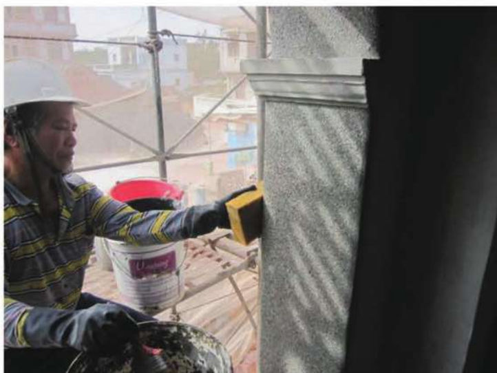
照片- 112：牆面蠟殼洗石子-表面水泥漿抹洗
