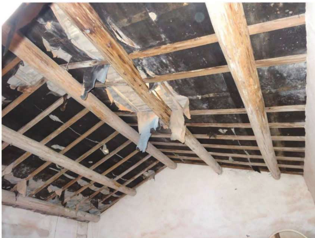
二樓大廳屋架-修復前
