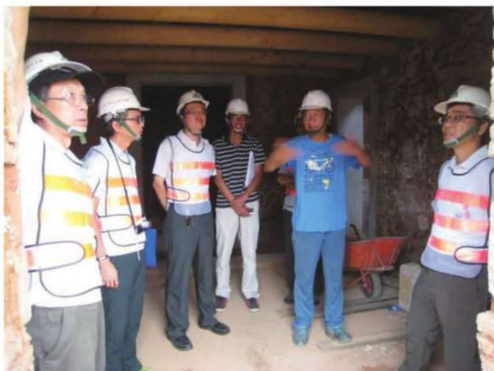
照片- 370：謝召集人偉松督導工地現況
