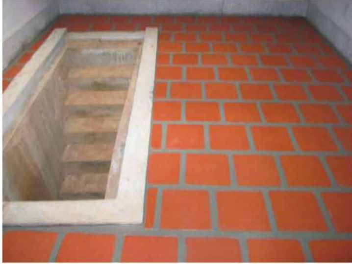
照片- 126：地坪尺磚鋪貼完成
