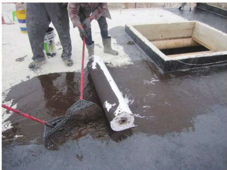
照片- 253：將纖維膠塗佈於施工面層上，再使用塑膠刮板將底油塗佈均勻(洋樓)
