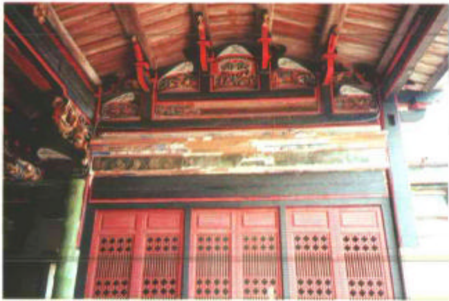
· 軒亭棟架修護前
