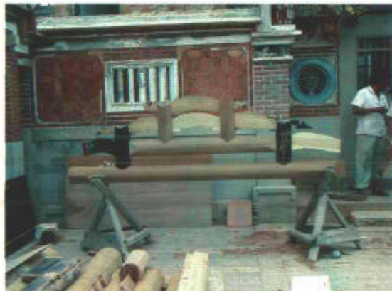
圖3-26-2 棟架於工地組立(二)
