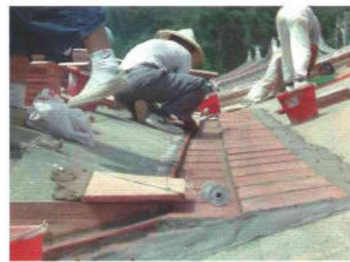
圖3-32 天溝鋪設尺磚
