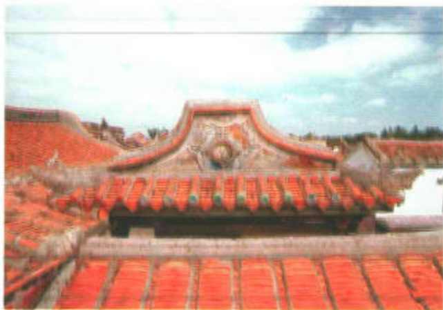
· 軒亭山牆修護前
