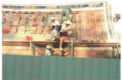
圖3-50-2 鋪設板瓦
