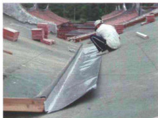
圖3-31 排水天溝表面加鋪不鏽鋼板
