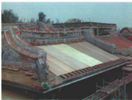
• 屋面搭設防水板，以防雨淋造成再度破壞
