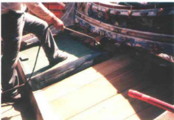
圖3-17 門廳屋面鋪設防水毯
