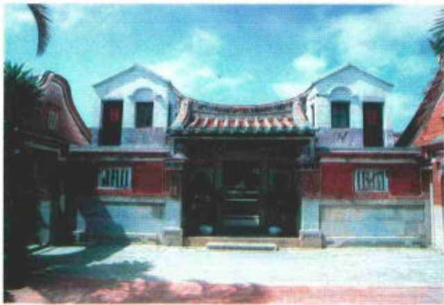
· 正立面修護前
