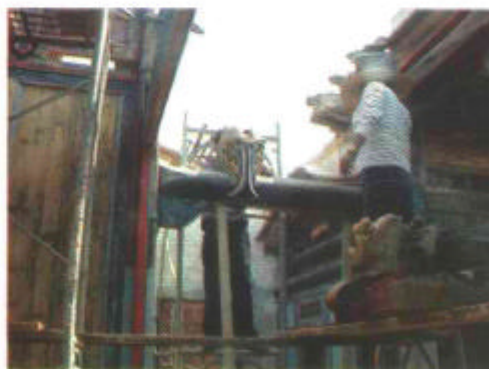
圖3-44 木棟架由上而下依序拆解 下來，以便整修
