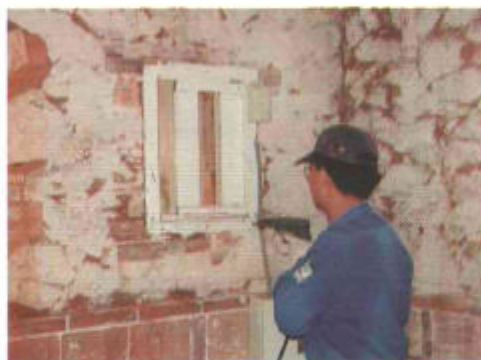
· 壁體鑽孔防蟲處理
