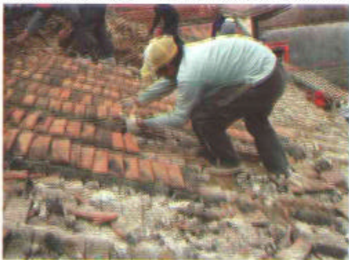
圖3-40 舊瓦以手工小心拆除
