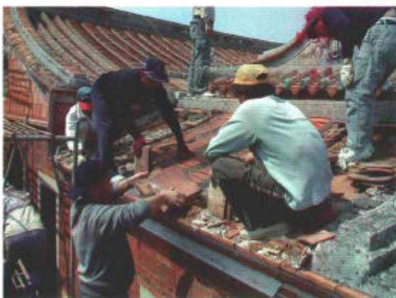
圖3-22 屋面舊瓦小心拆卸
