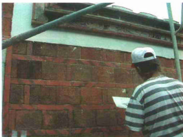
圖3-52-1 斗子砌牆面勾縫整修
