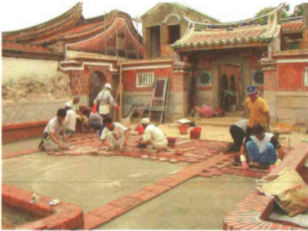
圖3-61-2 施作「龍鬚」鋪設外埕地磚
