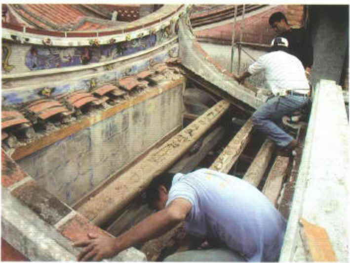
圖3-7 腐朽桁木拆解下來，以便整修或抽換
