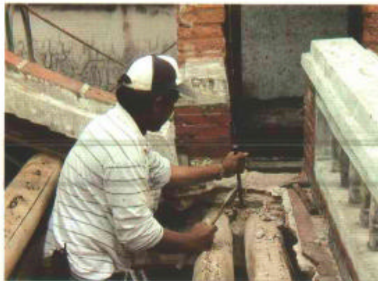
圖3-6 桁木拆解
