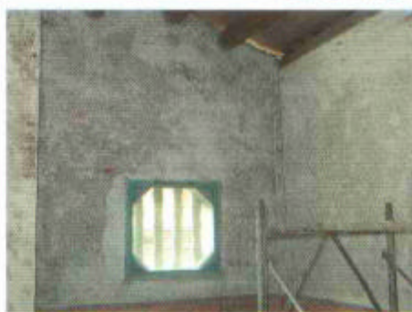
圖3-3 樺頭壁面粉刷層以手工敲除
