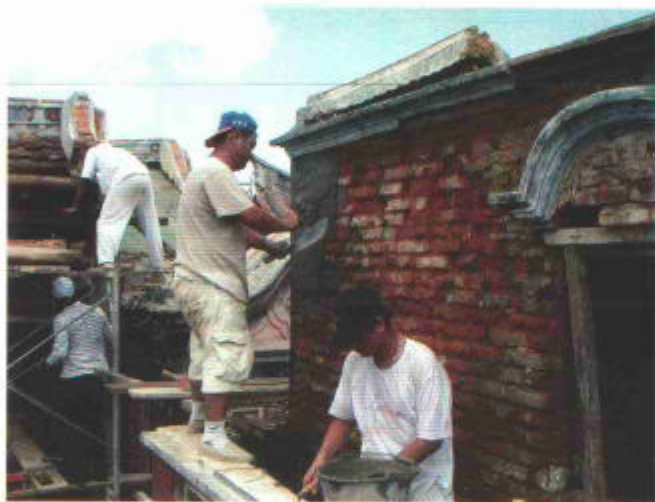
圖3-20 壁體以灰土打底
