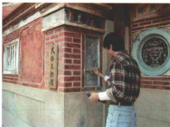
圖3-11 水車堵及泥塑裝修堵清理
