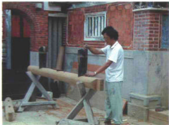
圖3-26-1 棟架於工地組立(一)
