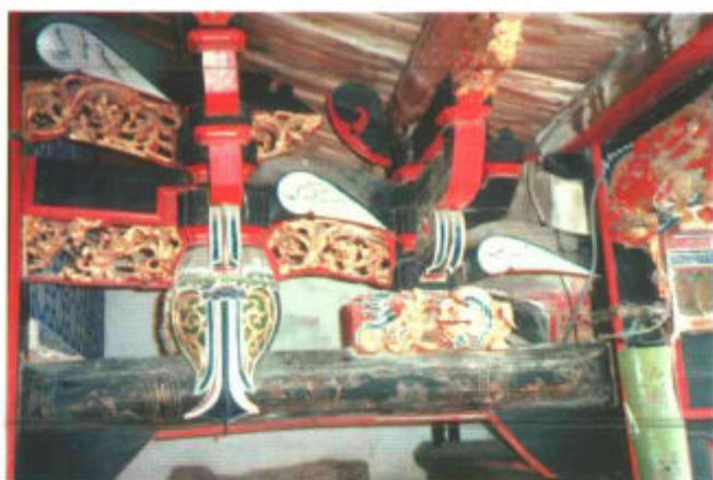
· 子孫巷棟架修護前
