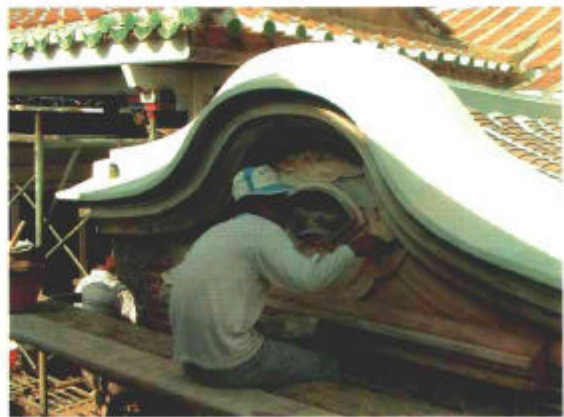
樺頭山牆泥塑整修
