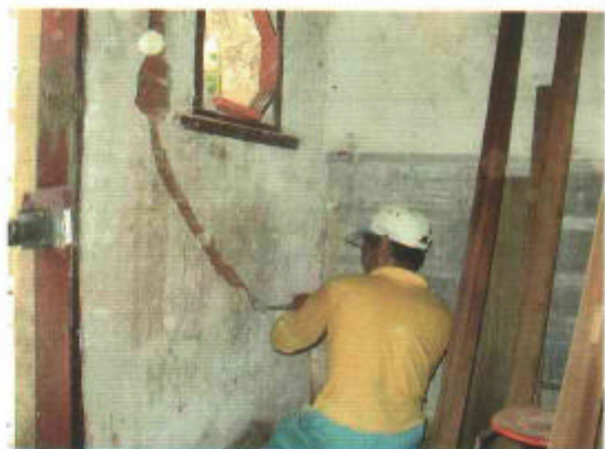
圖3-13 壁面鑿出水電管線
