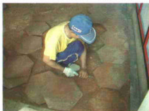
圖3-54-1 地面磚塊敲除，舊料保留留用
