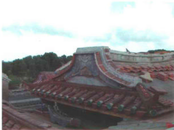
圖3-32 軒亭四垂坡屋面瓦鋪設，規帶仿作
