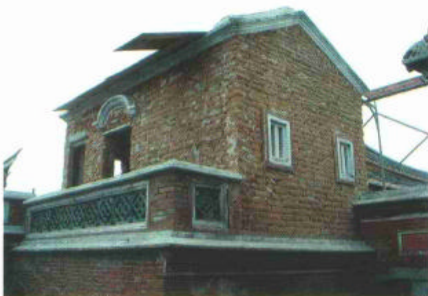
圖3-4 粉刷層刮除，直至露出牆體結構
