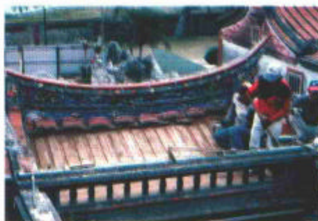
圖3-1 屋面舊瓦拆除、清理
