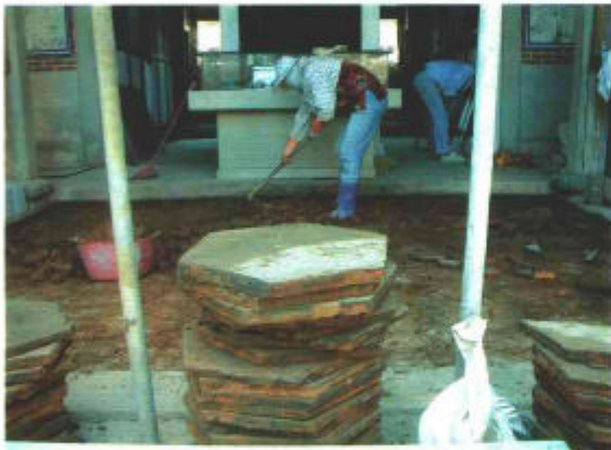
圖3-38-1 地坪磚塊敲除，良好之舊磚保存留用
