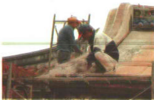
圖3-42 屋脊及規帶保留，表面 粉刷層刮除
