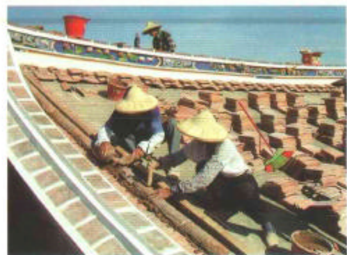
圖3-50-1 鋪設筒瓦
