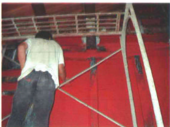
圖3-55-2 隔間牆堵板打底漆及二度油漆
