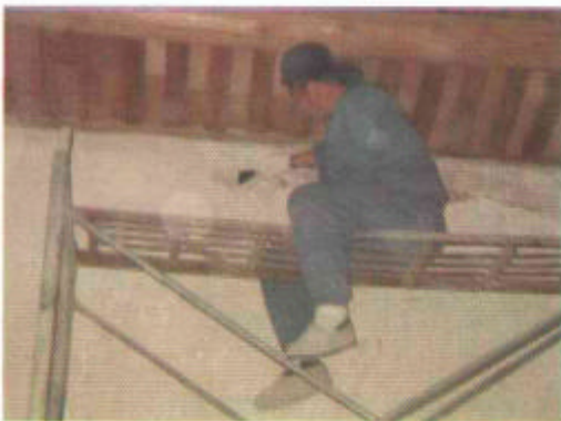
圖3-41 壁面粉刷層刮除
