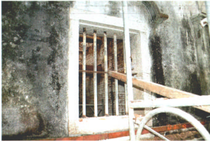
原有窗戶用鋼筋
