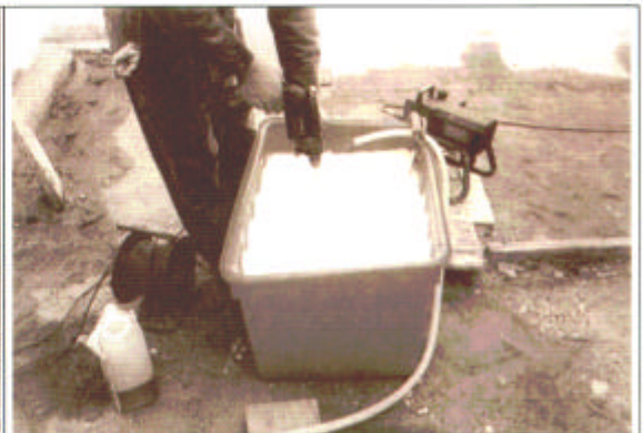
圖 5 - 2 防蟲工程施工機具準備
