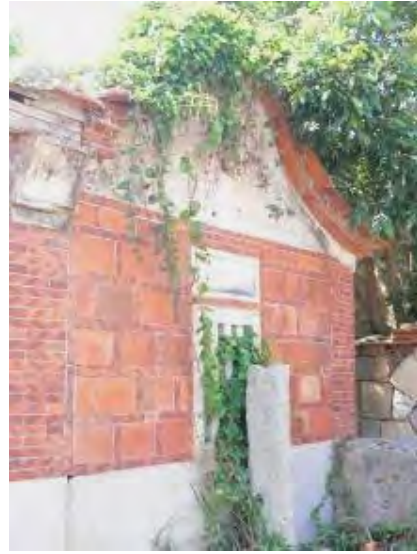
照片 5-2-15 左側正面牆基及磚面良好
