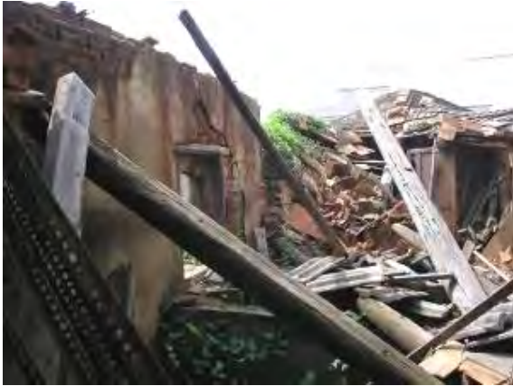
照片 5-1-337 左前一架有腐朽現象
