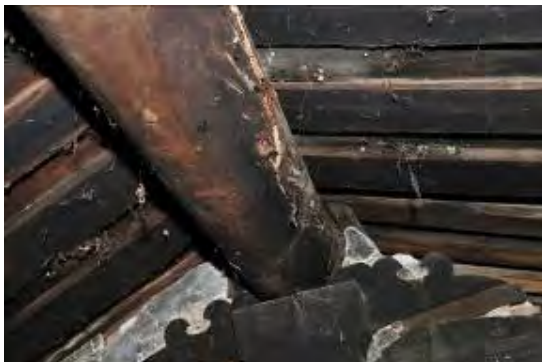
照片 5-3- 70 前落右房中脊左側前緣有蟻路、局部蛀蝕
