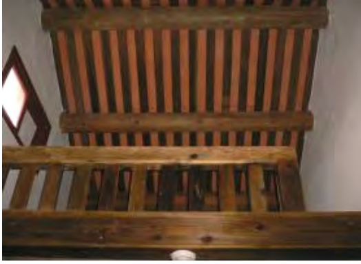
照片4-2-107 整修完成二樓右前屋架
