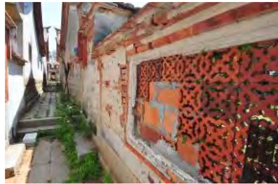
照片 5-1- 59 圍牆花磚窗破損修補
