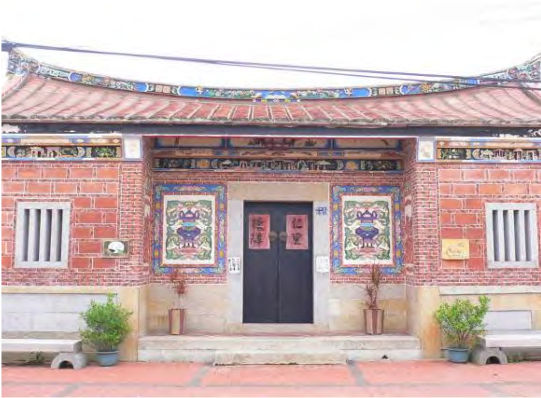
照片 4-2- 202 南山 5 號整修完成之立面外觀
