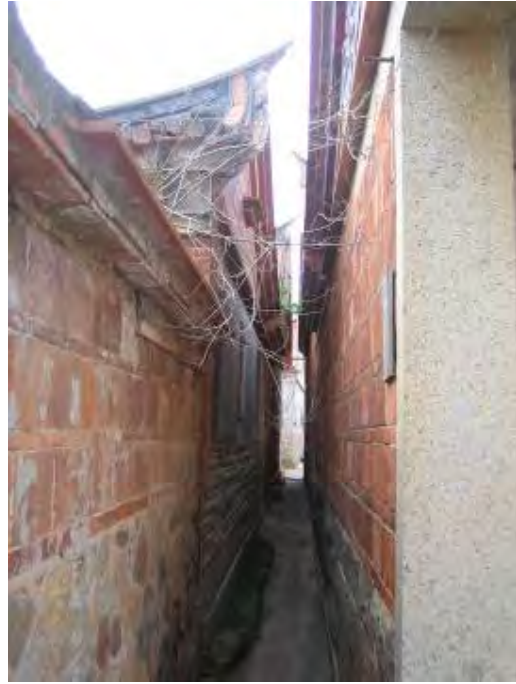
照片 5-3- 146 側牆面及大規壁現況良好
