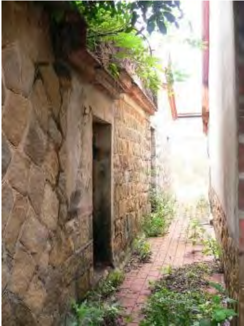
照片 5-7- 51 建物外牆現況
