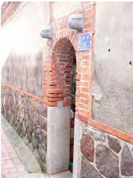
照片5-3-75 入口灰縫風化
