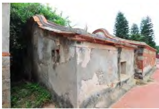
照片 5-7-18 左凸規牆面損壞修補過
