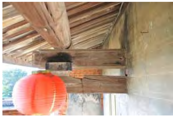
照片 5-1- 91 前落右前關刀拱狀況良好
