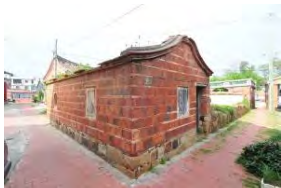
照片 5-3- 132 倉庫屋頂坍塌、外牆現況良好
