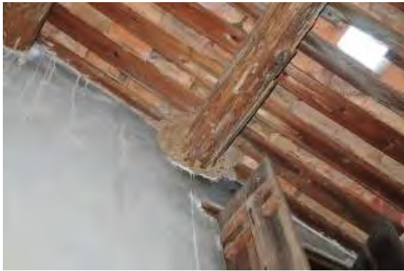
照片 5-3- 173 後落左房後三架蟻巢外露
