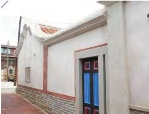
照片4-2-109 整修完成二落右側外牆
