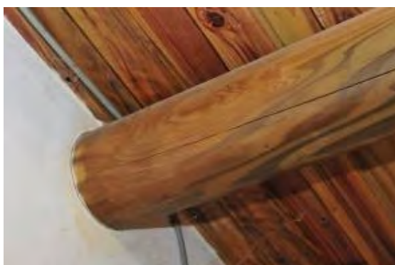
照片4-2-23 後落左房前二架有劈裂但材質良好
