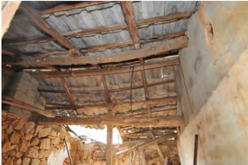
照片 5-2-8 歐厝 64 號右擡頭臨時建築非制式之屋架
