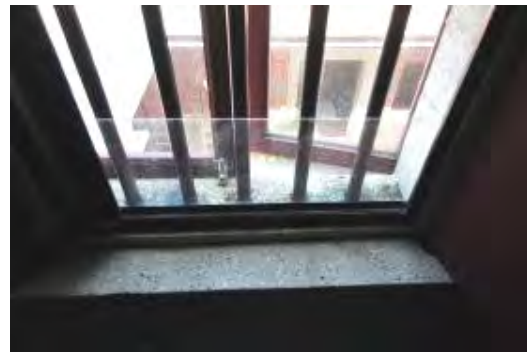
照片4-2-99 洋樓窗戶採壓克力防潑水
