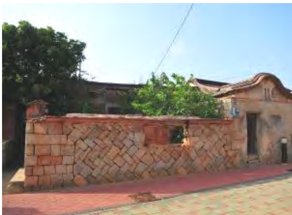
照片 5-2- 40 歐厝 66 號建物立面外觀
