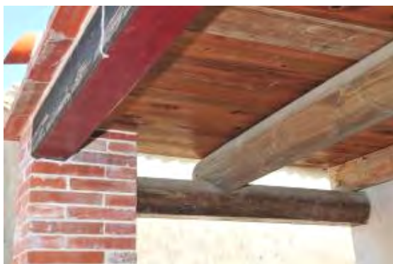
照片4-2-25 後落右側入口磚平下木樑良好
