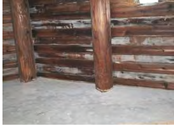
照片 5-1-95 前落右房左端局部劈裂、材質尚可
