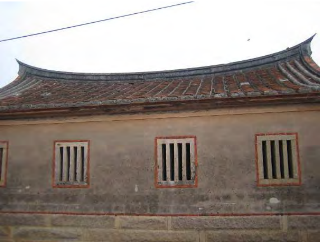
照片 5-3-6 瓊林 92 號背牆立面外觀
