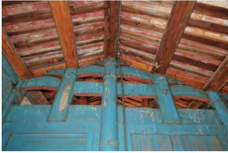
照片 4-2- 139 穿斗式構架之穿、筒仔及彎束等構件
