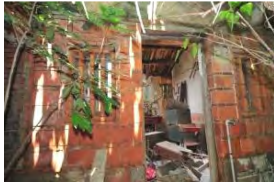
照片 5-6-12 右護龍正面壁體採斗砌造
