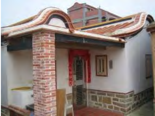
照片4-2-1 南山84-1號整修完成外觀
