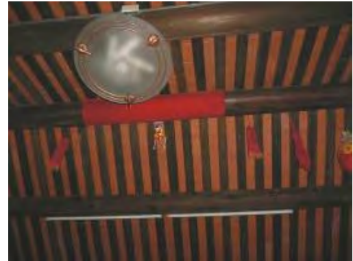
照片 4-2- 104 整修完成之二樓大廳屋架
