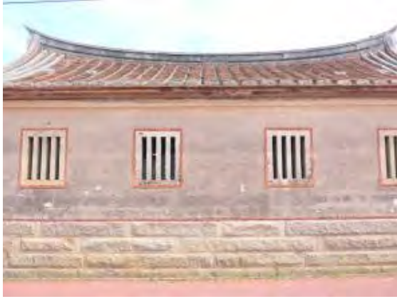
照片 5-3-13 正廳屋脊、屋面、牆基、牆面現況良好
