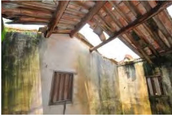
照片5-6-13 右護龍屋面崩塌構件均已腐朽損壞
