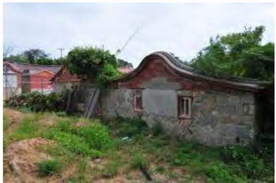
照片 5-5-14 右凸規磚造牆體及斗砌牆山尖
