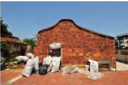
照片 5-1- 140 四維堂後落左側斗砌牆
