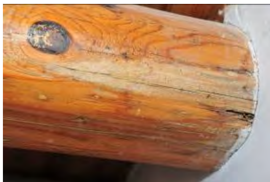
照片 4-2-12 右擗頭前一架下緣局部蛀蝕
