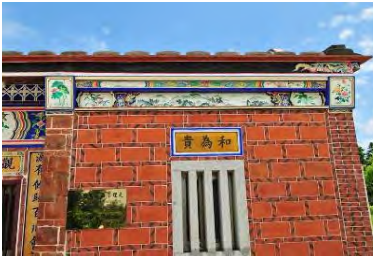
照片 4-2- 45 前落牆身為斗砌造，上接水車堵彩繪
