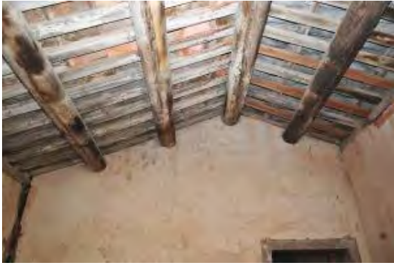
照片 5-1-22 水頭 7 號明間左牆體及屋架左端
