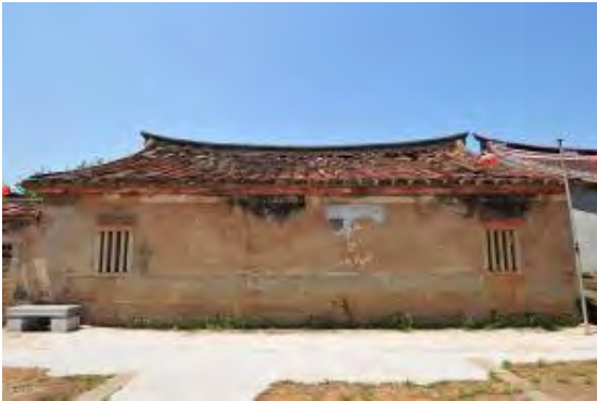
照片5-1-52 後落後寮牆
