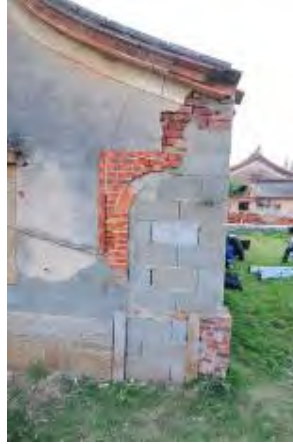
照片 5-1-19 右員光門損壞以空心磚修補
