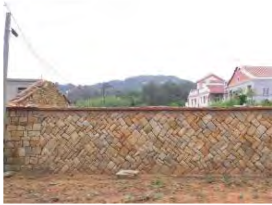
照片 5-5-4 屋面坍塌，後側石砌牆面完整
