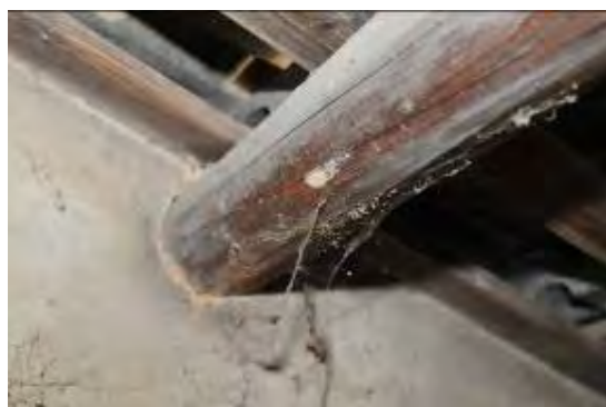
照片 5-6-33 後二架表面有蟻道，內部局部蛀蝕
