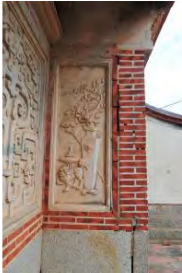
照片 5-3-21 前落凹壽左側牆泥塑
