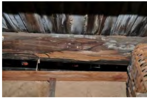
照片 5-1- 119 後落左房後一架嚴重蛀蝕
