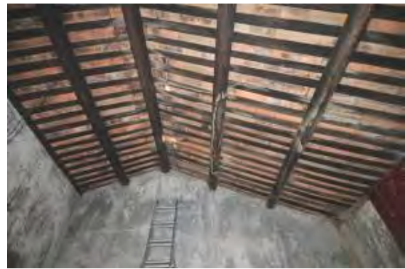
照片 5-2-59 後落正廳右側全貌
