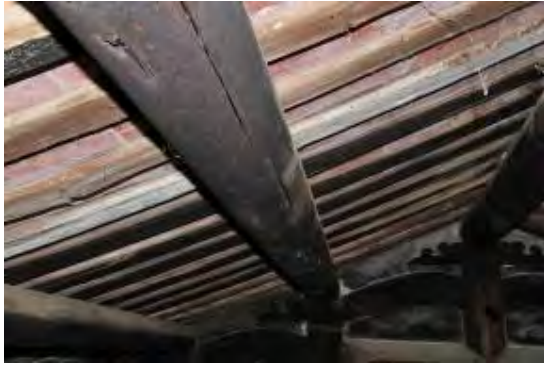
照片 5-3-97 後一架左端輕微蛀蝕尚可、全根下緣劈裂
