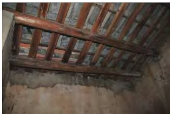
照片5-6-49 左前擡頭後坡全景
