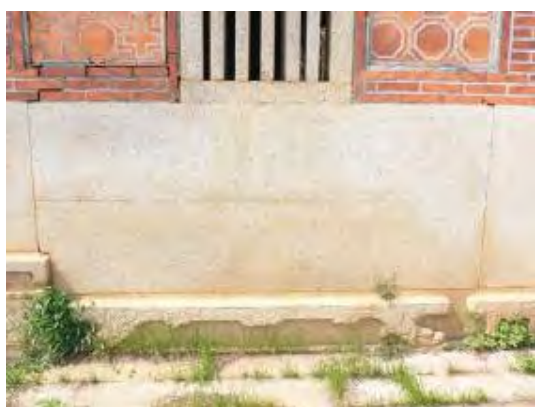
照片 5-1- 249 建物牆基及牆堵可再利用
