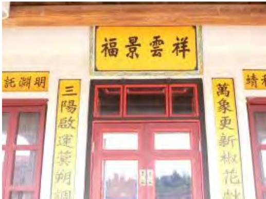
照片4-2- 105 二樓大廳立面局部
