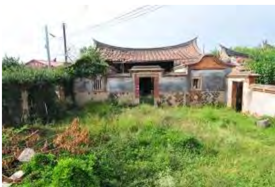
照片 5-3-123 一落二擡頭之建築
