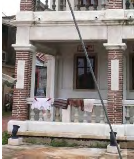
照片 4-2- 102 整修完成之右前外觀
