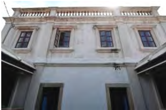
照片4-2- 94 洋樓背牆與天井
