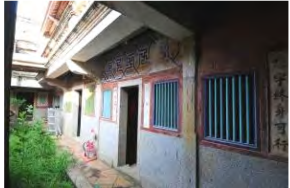
照片 4-2- 135 洋樓一樓外觀
