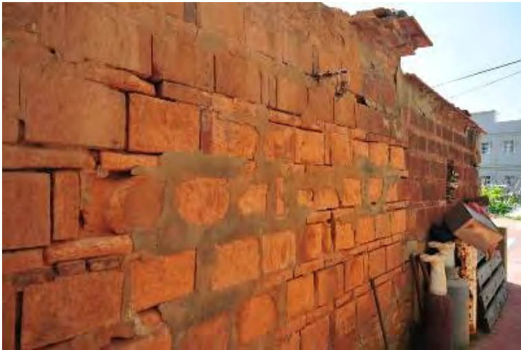
照片 5-1- 307 右二擡之斗砌牆體
