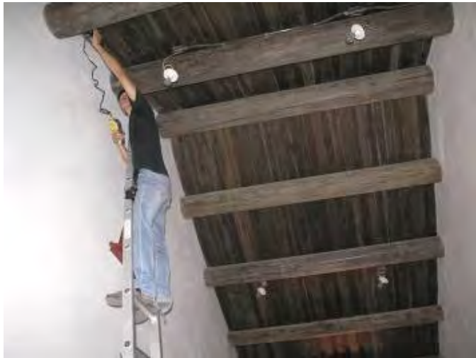
照片 4-2- 200 後落右房屋架狀況良好
