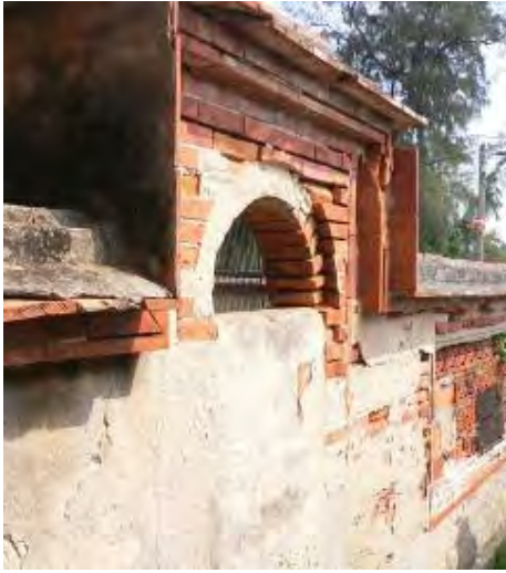
照片5-1-35 前庭右側原有門洞封閉
