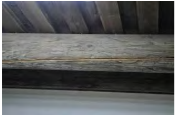
照片 4-2- 78 左後三架下緣全根劈裂
