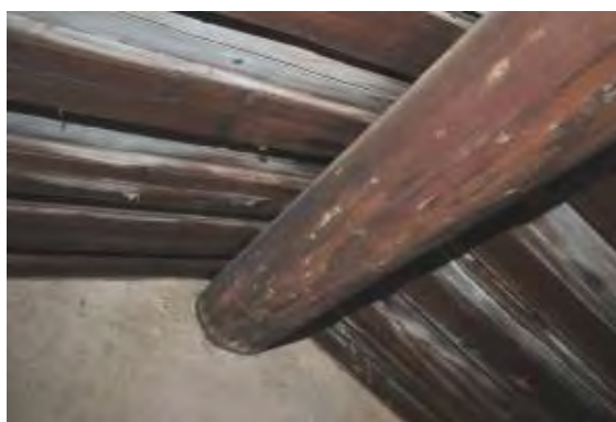
照片 5-1-93 前落左房中脊右半下緣中央劈裂、左端表面多處輕微蛀蝕
