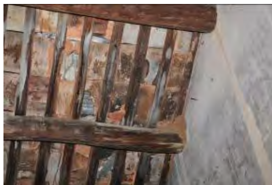
照片 5-7- 64 右房前一架右側與壁體交接處有明顯蟻窩
