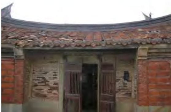
照片 5-3- 149 前落立面及屋面現況
