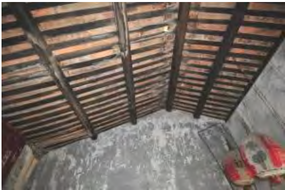
照片 5-2-58 後落正廳左側全貌
