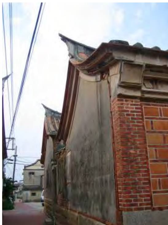
照片 5-3-2 右側外牆立面大致良好
