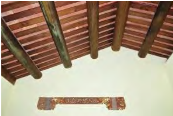
照片4-2- 239 後落正廳屋架左側
