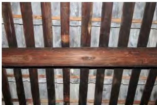
照片5-3- 106前一架全根下緣蛀蝕，材料尚可
