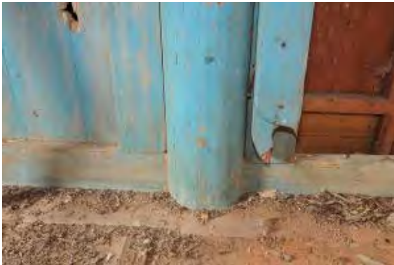
照片 4-2- 170 二樓左構架前柱大致良好
