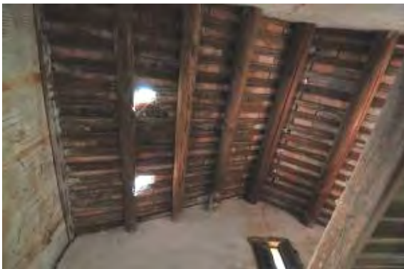
照片 5-1- 230 前落屋架為九架硬山擱楹造
