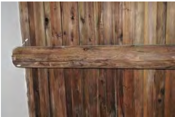
照片 4-2- 59 前一架楹仔左端有微裂
