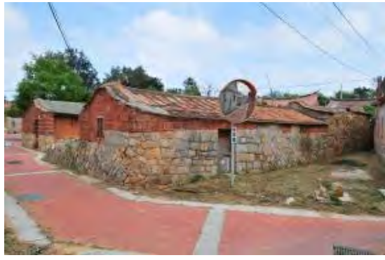
照片 5-5-8 左護龍牆體及屋面仍存
