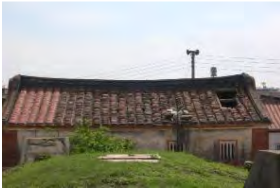
照片 5-4-5 正廳後坡屋面外觀、屋脊良好
