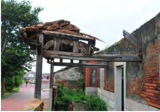
照片 5-1- 146 前庭軒由正廳前檐牆伸出左右二通支承屋架
