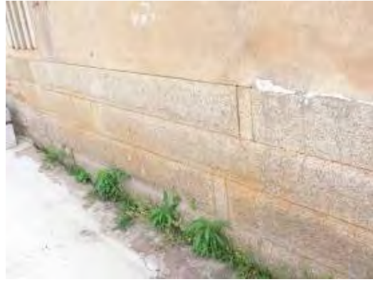
照片 5-1- 43 正廳後牆牆基完整尚可使用
