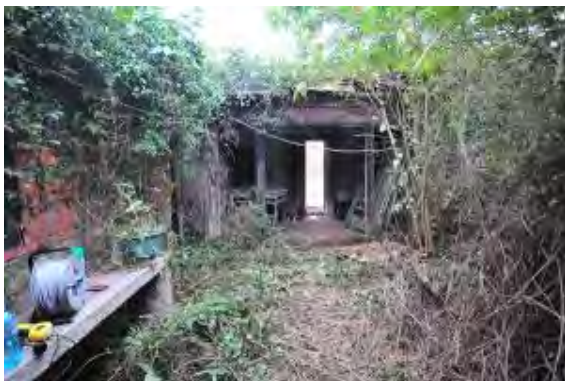
照片 5-7-11 內埕已被植物覆蓋攀爬
