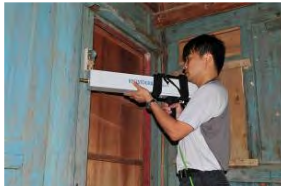
照片 4-2- 181 二樓正廳右前柱柱身檢測
