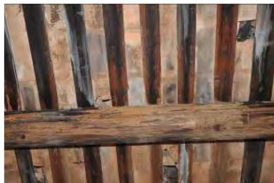
照片 5-7- 61 前一架全根嚴重腐朽蛀蝕
