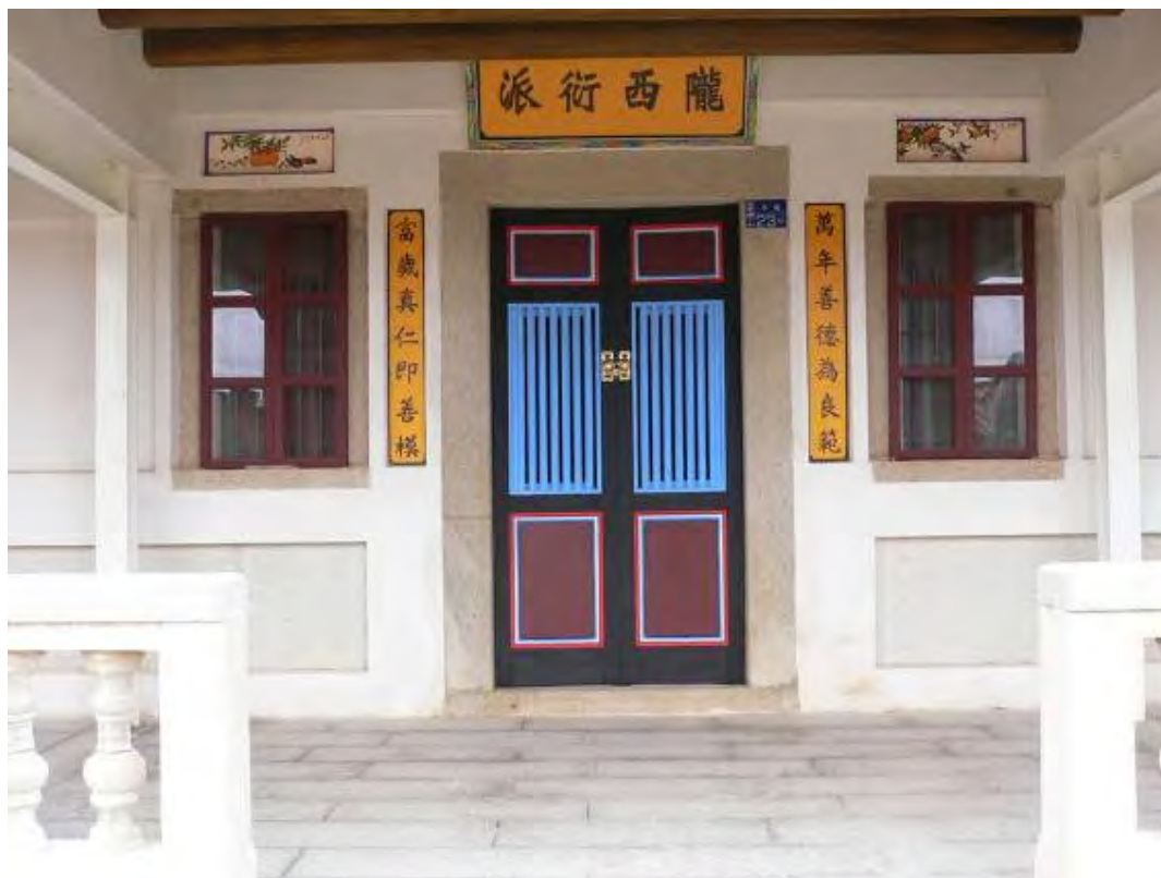
照片 4-2- 100 北山 23-3 號整修完成之門廊立面外觀
