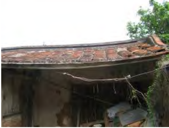
照片 5-2-44 前落內部堆置雜物
