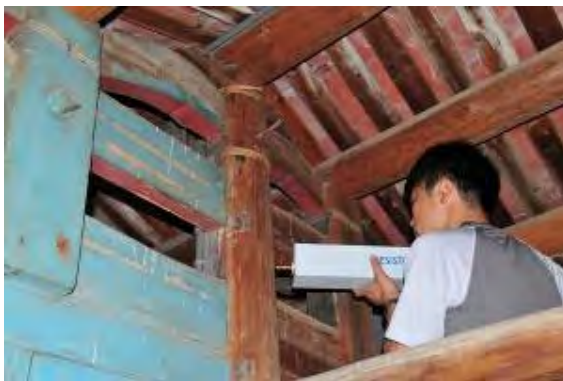
照片 4-2- 180 二樓正廳右前柱柱頭檢測
