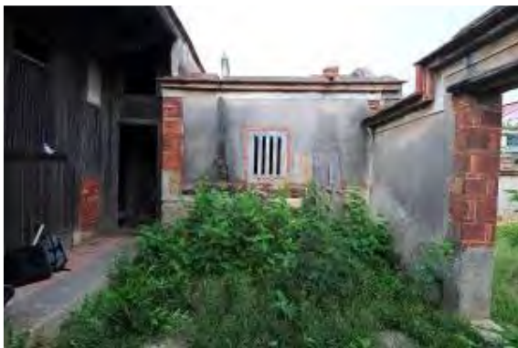
照片 5-3- 131 瓊林 110 號左擗頭內埕立面
