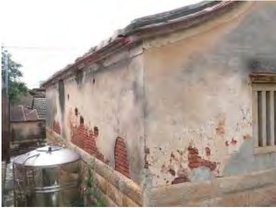
照片 5-1-4 水頭 7 號左側背牆外觀
