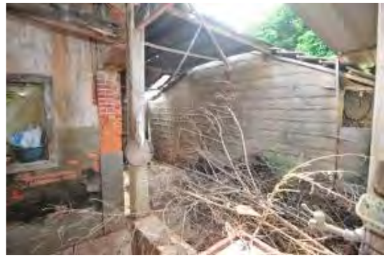
照片 5-1-57 左側附屬建築
