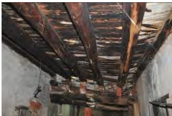
照片 5-7-30 左後擡頭現況全景
