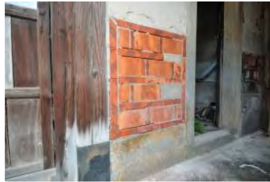
照片 5-1-53 前落鏡面牆牆基為斗砌牆
