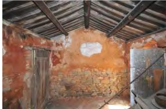
照片 5-5-18 左護龍屋架後側
