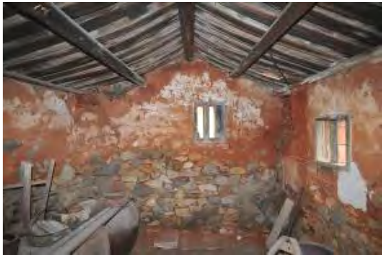
照片5-5-17 左護龍屋架前側
