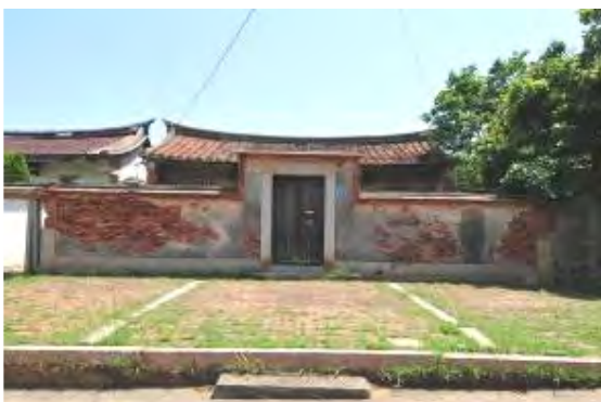
照片 5-1-46 水頭 9 號牆門與圍牆
