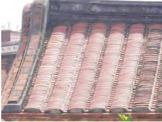
照片 5-4-13 左房屋瓦整修過
