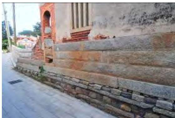
照片 5-1-7 建物牆基與牆堵保存良好
