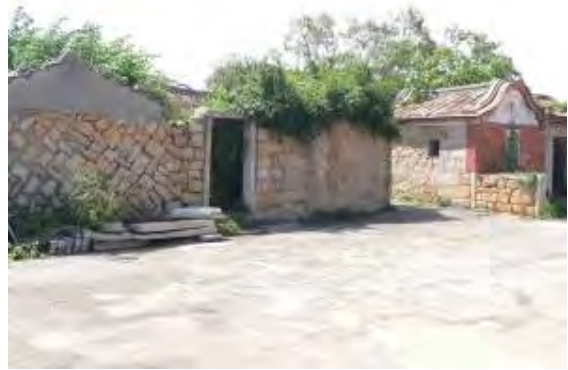
照片 5-2-3 歐厝 64 號前埕為水泥鋪面
