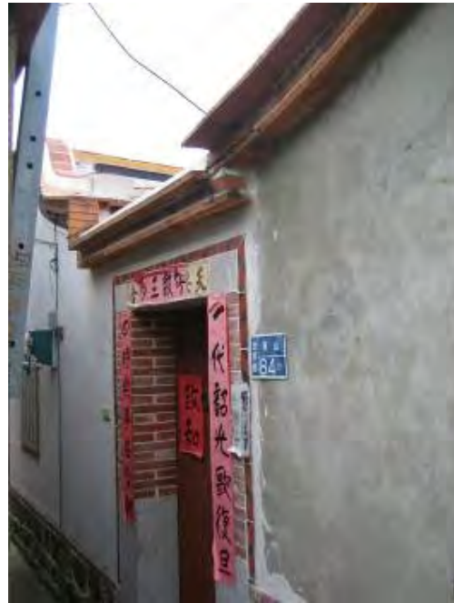
照片4-2-2 南山 84-1 號整修完成之入口外觀
