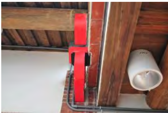
照片4-2-111 天井左側磚平與後落接合部位
