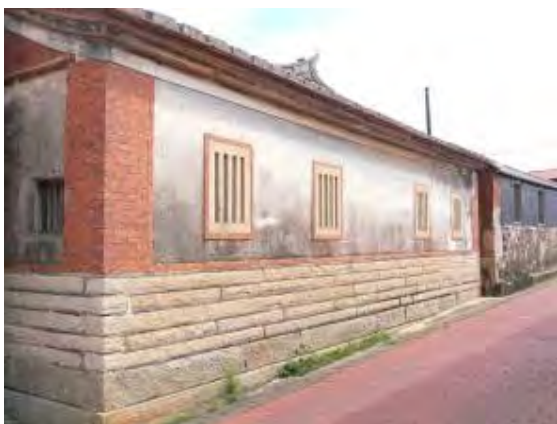
照片 5-3- 155 正廳背牆的牆基及牆面良好
