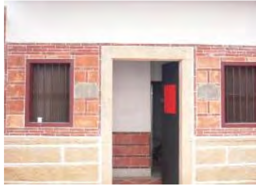
照片 4-2- 108 整修完成二落立面局部
