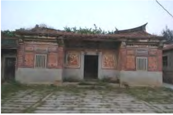
照片 5-1- 228 前落採大型花崗石牆基與磚造牆身
