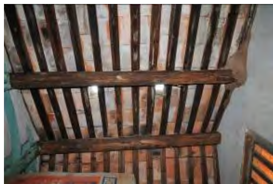
照片 5-7- 26 後落右房後一架、中脊嚴重蛀蝕
