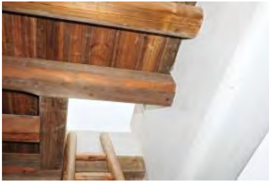
照片4-2-113 二樓外廊左側天窗開口
