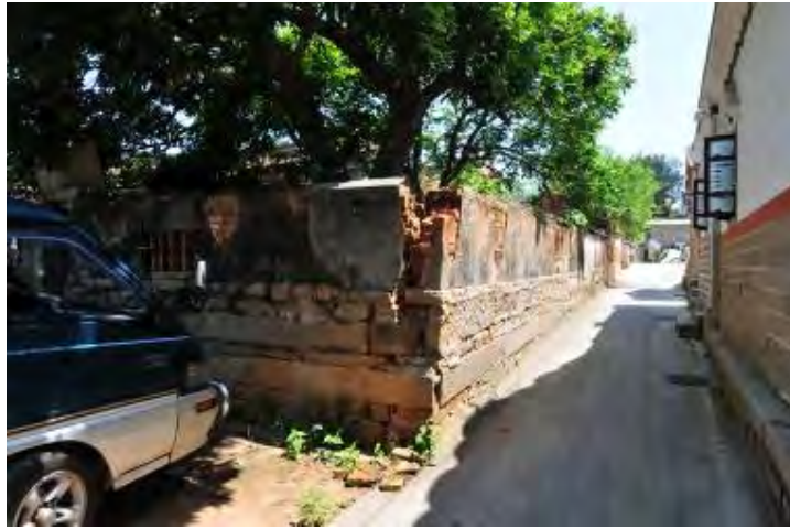
照片 5-1-49 水頭9號左前側之圍牆與左側巷道
