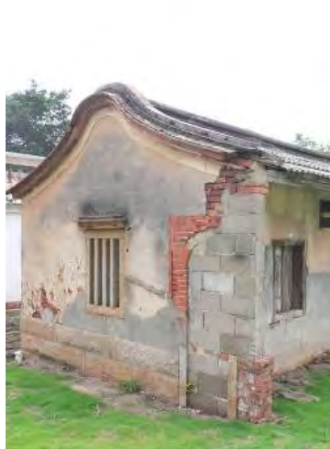
照片 5-1-3 水頭 7 號右側立面外觀
