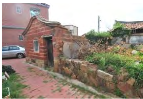
照片 5-3-124 前右側倉庫建築
