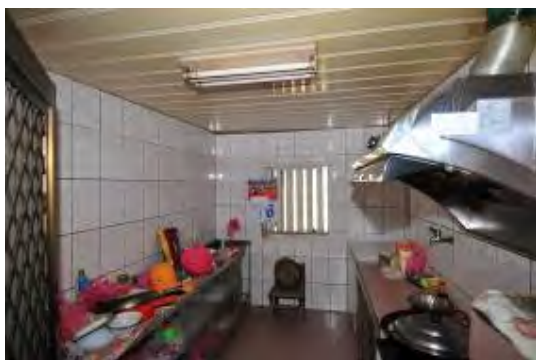
照片 5-3- 101 前落右次間改為廚房現況
