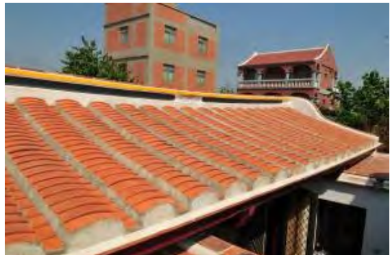
照片4-2-8 南山 84-1 整修後之屋面
