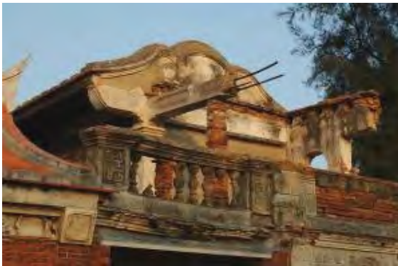
照片 4-2- 130 洋樓二樓陽台 RC 樑及磚拱
