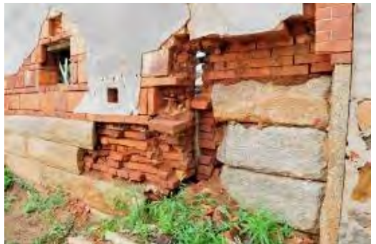
照片 5-1- 139 四維堂前落牆體構造
