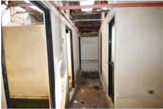
照片 5-4-45 原內埕改建之澡堂空間
