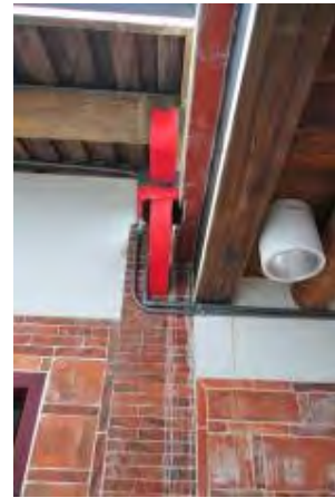
照片 4-2- 118 左磚平檐楹與後落關刀拱
