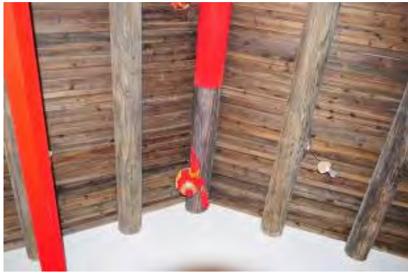
照片 4-2- 196 後落屋架樑仔狀況良好
