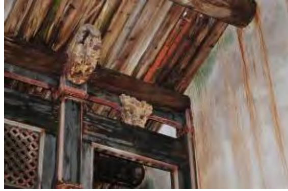
照片 5-1- 233 後落正廳壽堂神龕柱頭亦有木雕
