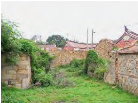
照片5-5-1 建物屋面坍塌，內部雜草生長
