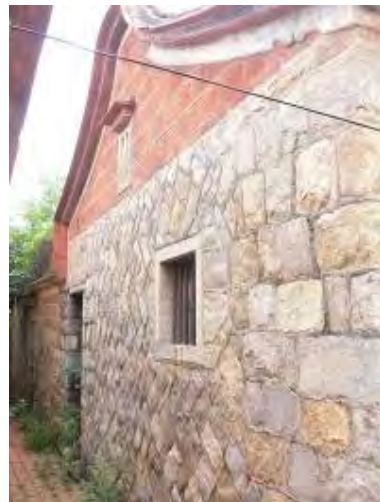
照片 5-7- 50 左側牆面外觀
