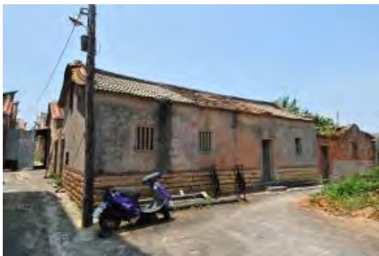
照片5-6-1 建築物左後側立面
