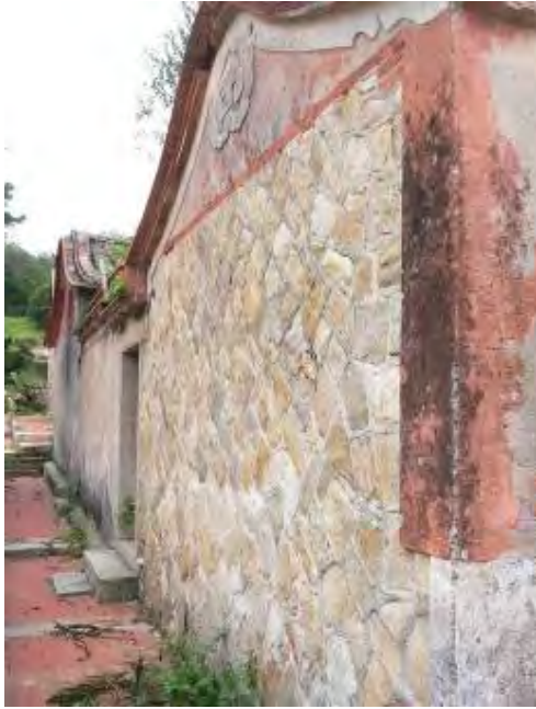
照片 5-7-3 右側外牆立面
