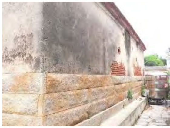
照片 5-1-5 水頭 7 號左側背牆外觀
