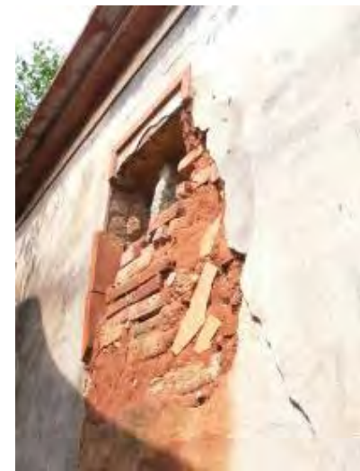
照片 5-1- 261 右護龍外牆開窗砌磚封閉
