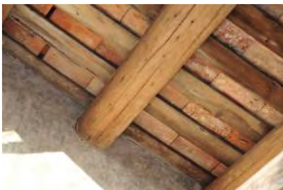
照片 5-2-28 前一架劈裂局部腐朽，但材質尚可
