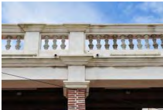
照片 4-2- 91 欄杆採金門傳統花瓶欄杆
