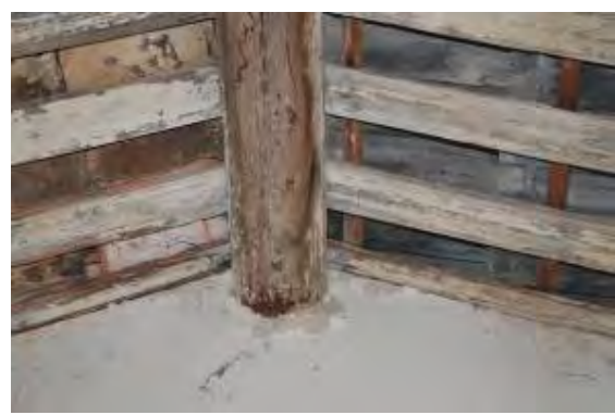
照片 5-1-31 右房中脊無明顯損壞現象
