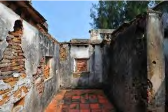
照片 4-2- 134 洋樓後側二樓空間
