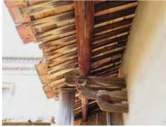
照片 5-1- 324 步口三挑之木構造
