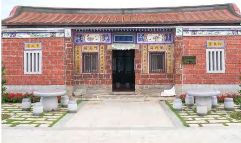
照片 4-2- 33 北山 13 號整修完成之立面外觀
