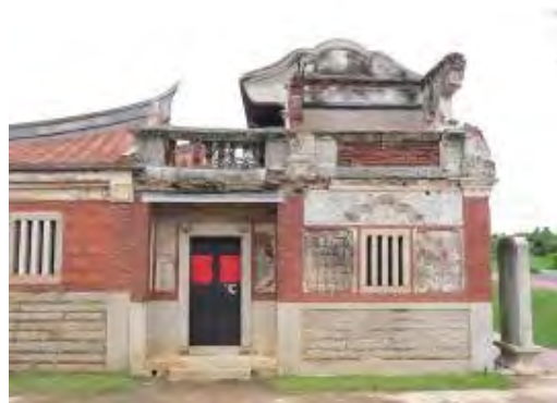
照片 4-2- 124 北山古洋樓左側洋樓立面外觀
