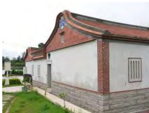
照片4-2-37 北山13號整修完成之左前側外觀
