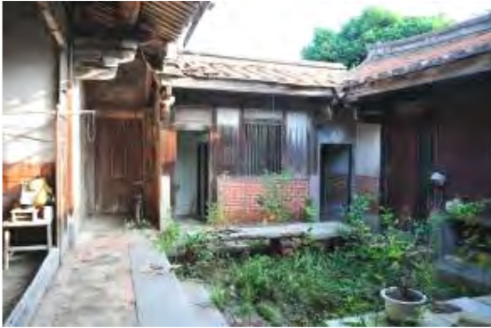
照片5-1-56 天井空間
