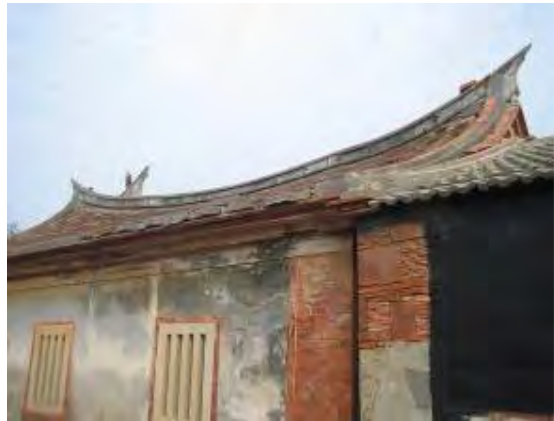
照片 5-3- 148 後落屋面及屋脊現況良好
