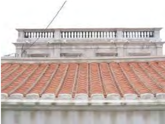
照片4-2-86 整修完成之二落屋面外觀
