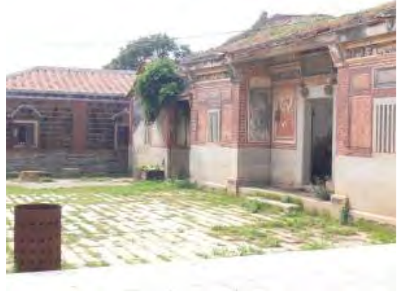
照片 5-1- 221 建物前地坪雜草生長
