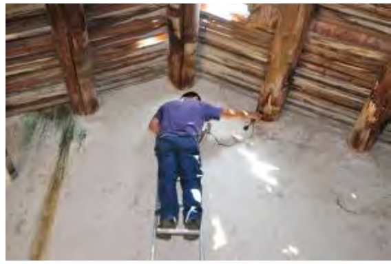
照片5-1-75 正廳屋架檢測情形
