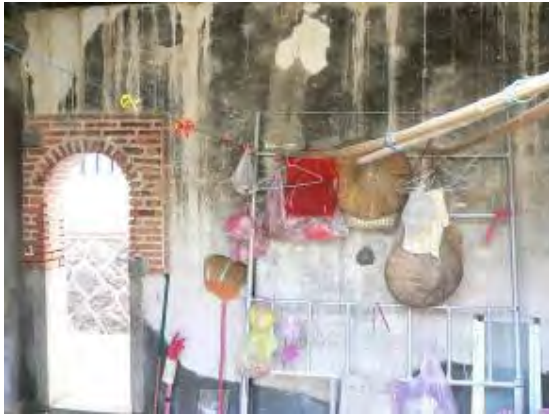
照片 5-3-79 內部使用現況
