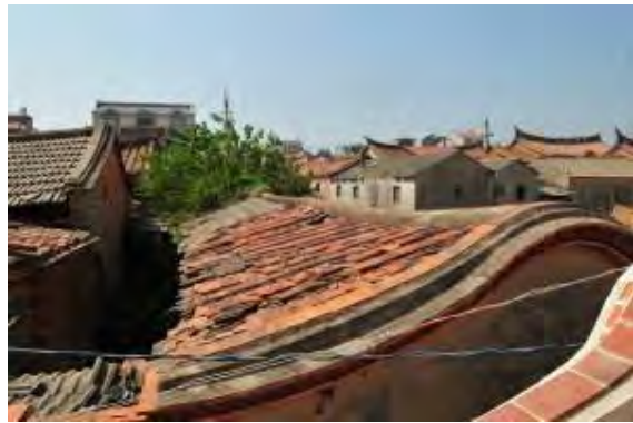
照片4-2-6 南山 84-1 後側與前側建築之間隔
