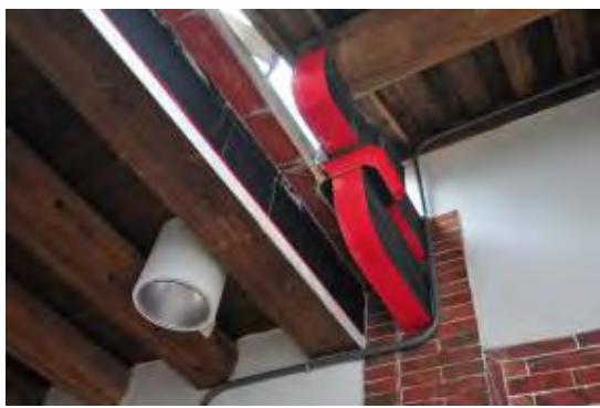
照片 4-2-112 天井右側磚平與後落接合部位
