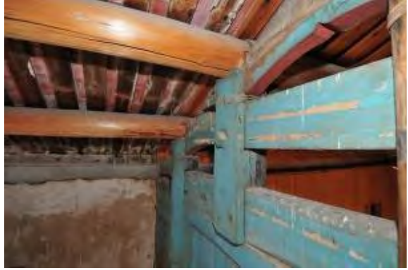
照片 4-2- 183 二樓右房左側樑仔與木構架
