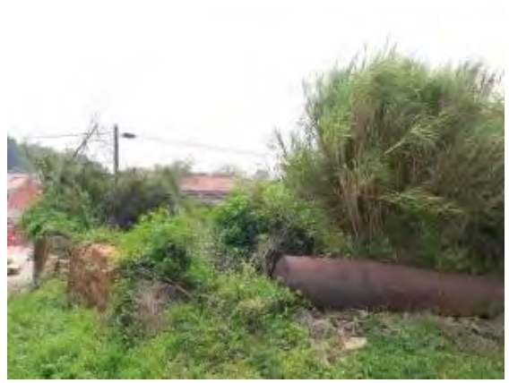
照片 5-2-5 歐厝 64 號倒塌僅見部分背牆
