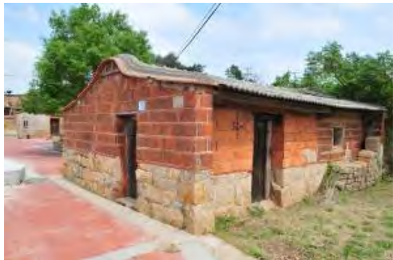
照片 5-5-12 右護龍屋面改採石棉瓦屋架亦更改
