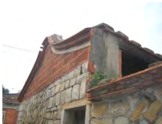
照片 5-2- 41 右側馬背瓦作掉落，牆體良好
