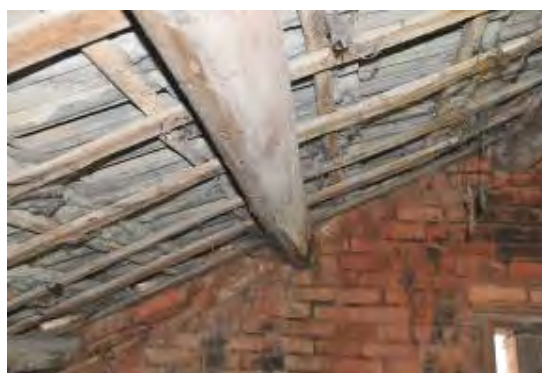
照片 5-6-22 前一架表面有蟻道，內部局部蛀空
