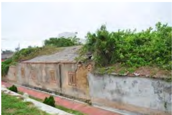
照片 5-6-29 建物屋面鋪設水泥瓦
