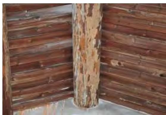
照片 5-3- 168 後落正廳中脊，表面面漆剝落構件
