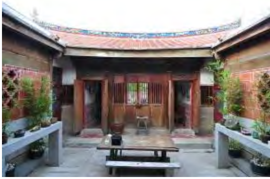
照片4-2-211 前落背立面與天井
