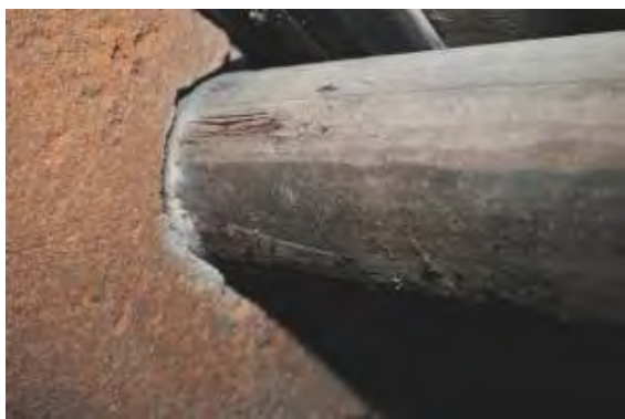
照片 5-2-76 左房前一架內部部分嚴重蛀蝕
