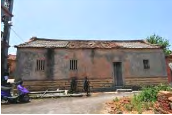
照片5-6-5 正身屋面左右房已用水泥瓦改建
