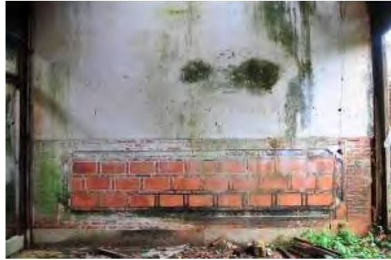
照片 5-1- 229 後落正廳內側採斗砌牆基
