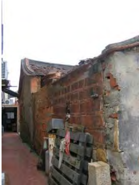
照片 5-1-285 左側外牆外觀
