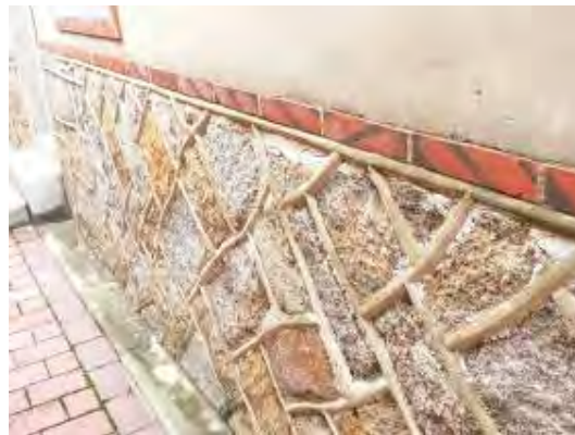
照片 4-2- 204 南山 5 號右側牆堵局部外觀
