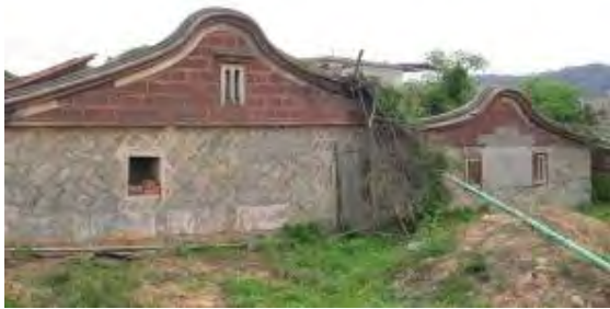
照片 5-5-3 右側牆面構造良好
