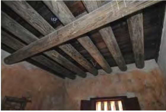
照片 4-2- 136 古洋樓二樓地板乃以木樑支承而成
