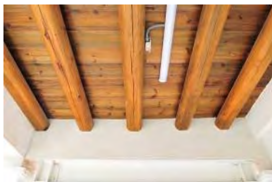
照片4-2- 115 一樓外廊樓板屋架木樑
