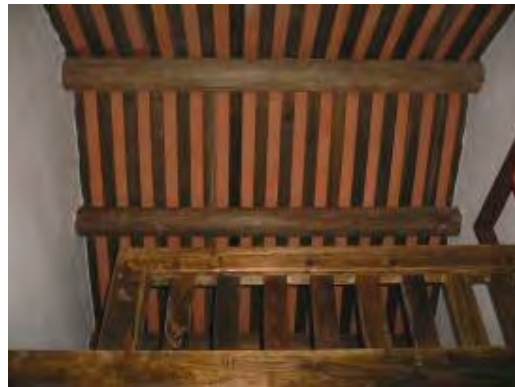
照片 4-2- 106 整修完成二樓左前屋架
