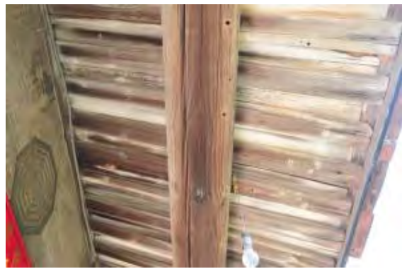
照片 5-1- 87 前落前挑檐下緣劈裂但材質良好
