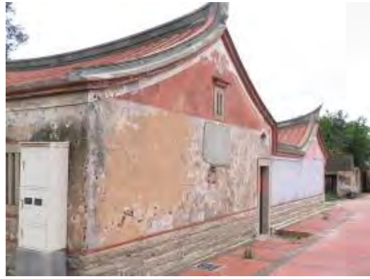
照片 4-2-145 北山古洋樓之傳統建築右後外觀
