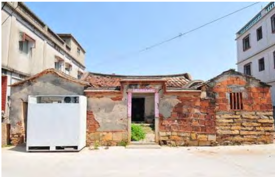
照片 5-1-284 水頭 118 號立面外觀
