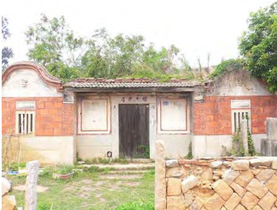
照片 5-2-9 歐厝 65 號建物立面外觀
