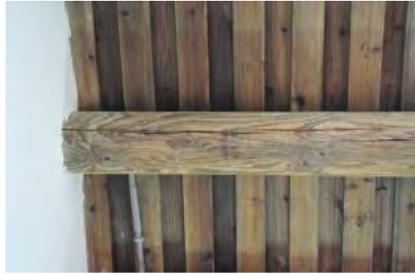
照片 4-2- 76 正廳前二架下緣全根劈裂
