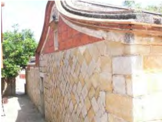
照片 5-2- 20 左側牆面良好
