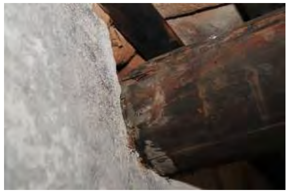
照片 5-2- 71 前一架左端接合處蛀蝕
