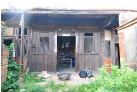
照片 5-3- 129 瓊林 110 號正廳立面全景
