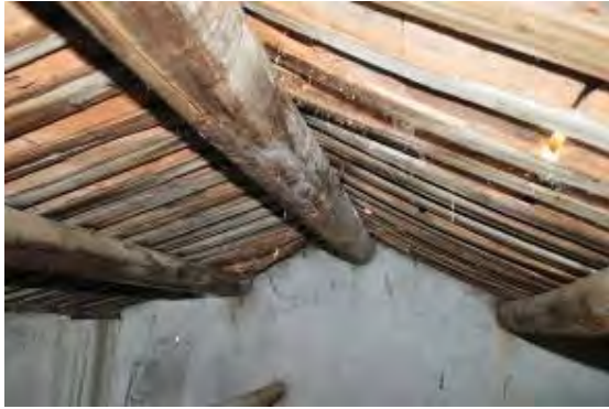
照片5-6-17 中脊下緣劈裂材質尚可
