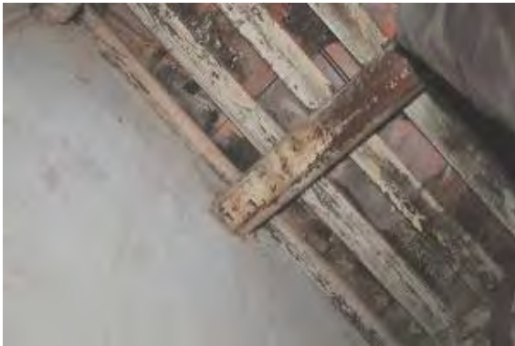
照片 5-1-28 左房後二架無明顯損壞
