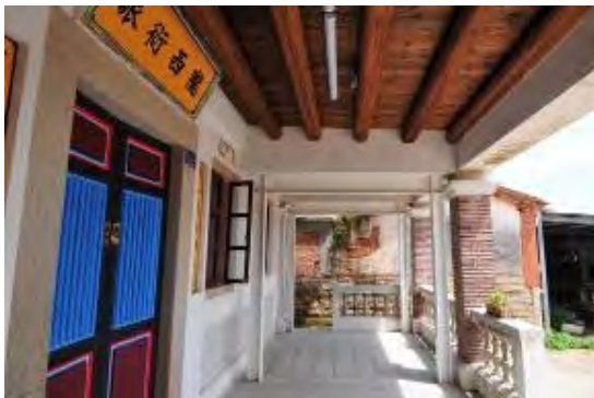
照片4-2- 96 洋樓一樓採H型鋼補強
