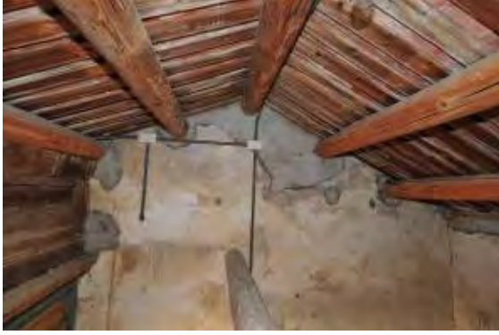
照片 4-2- 142 二樓右次間之屋架現況
