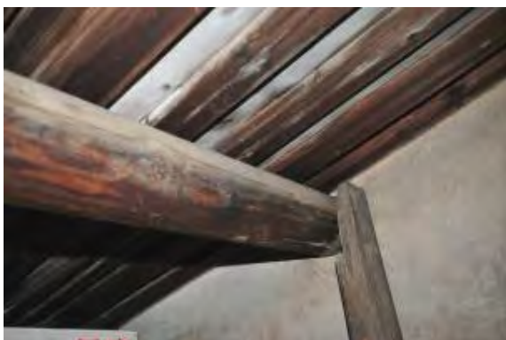
照片 5-1-92 前落左房後一架表面輕微蛀蝕
