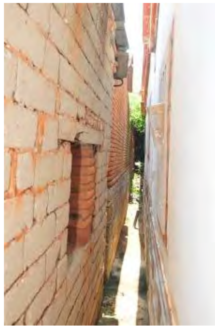
照片4-2-4 南山 84-1 後側與鄰棟之間隔
