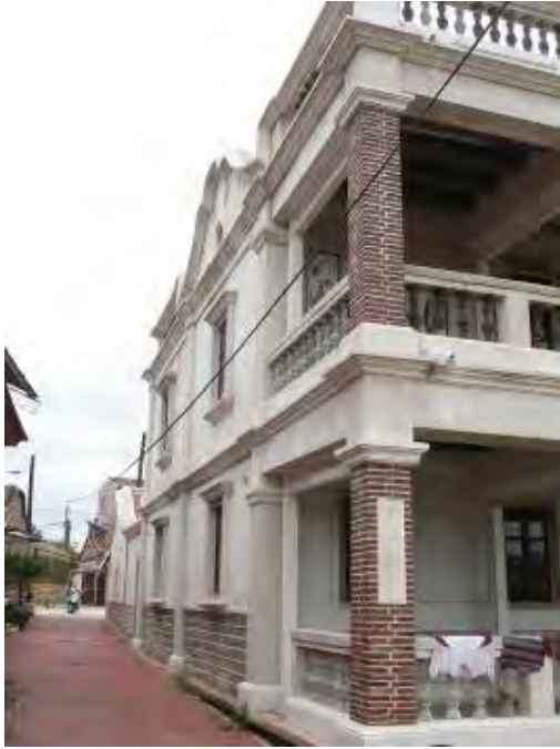
照片4-2-84 北山23-3號整修完成之右側外觀
