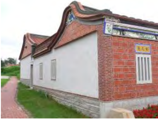
照片4-2-34 北山13號整修完成之右前側外觀
