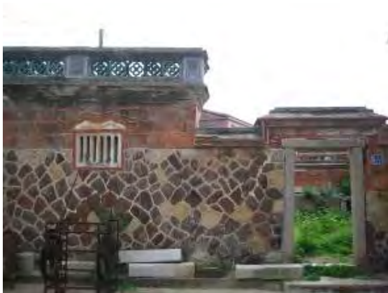
照片5-3- 143 外牆及裝飾現況良好
