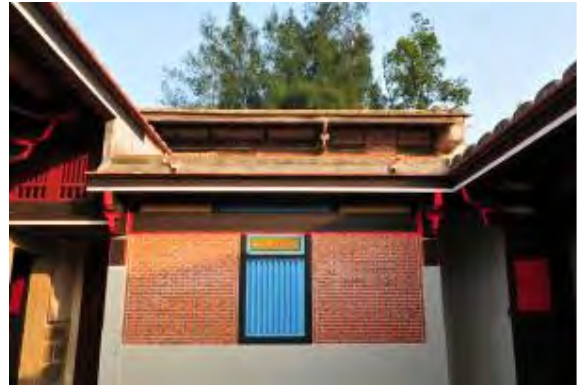
照片 4-2-193 左磚平構造與屋架狀況良好
