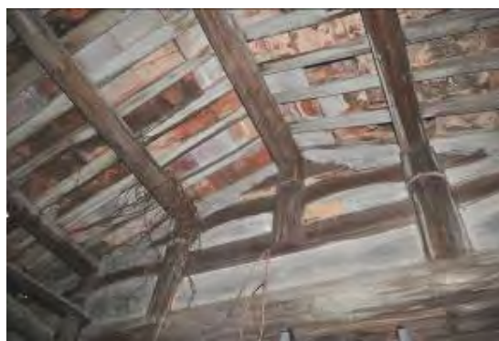
照片 5-7-42 前落右房左側木樑與木作棟架現況
