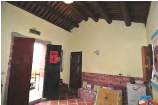
照片4-2-213 前落為九架擱檯造
