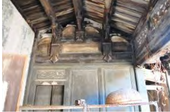
照片 5-3-26 前落之瓜柱式木構架
