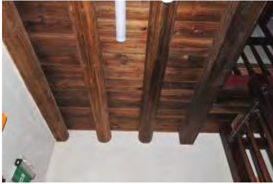
照片4-2-92 二樓樓板以木屋樑支承
