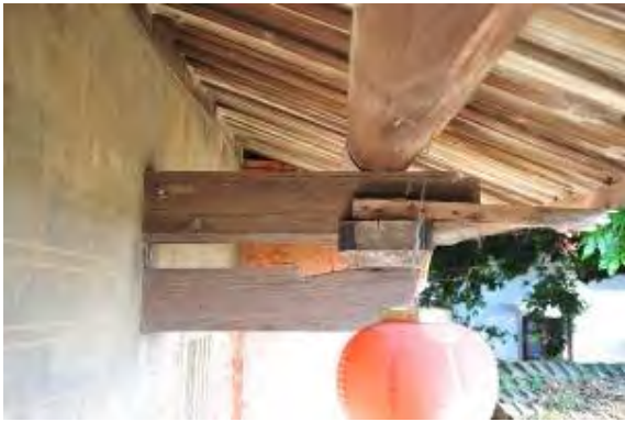
照片 5-1- 90 前落左前關刀拱狀況良好
