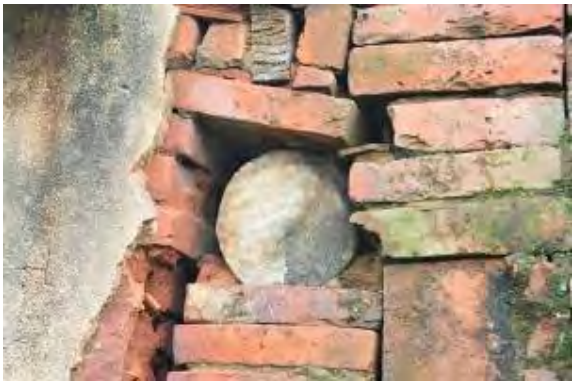
照片 5-1- 200 右大通端部外露於牆體
