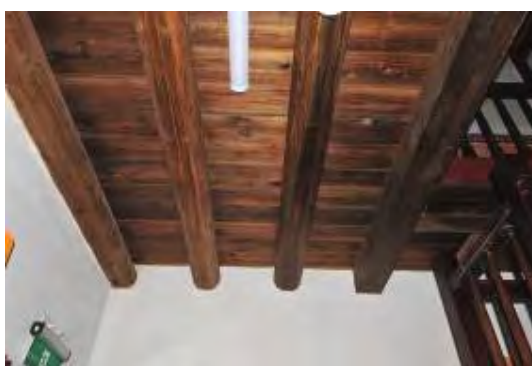
照片 4-2- 116 洋樓內後廳樓板屋架左側
