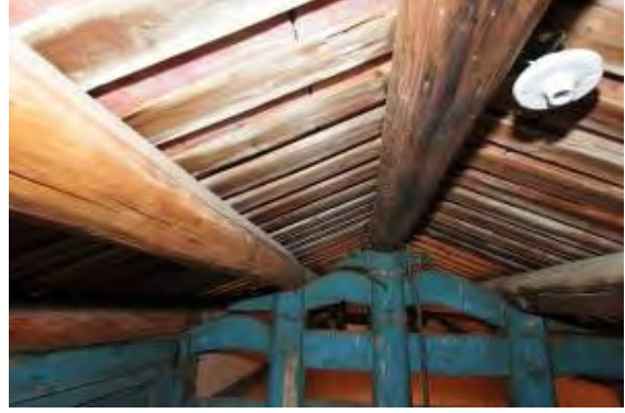
照片 4-2- 143 二樓明間屋架現況
