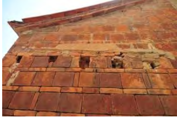
照片 5-1- 300 右側大規壁牆體外露之木樑端
