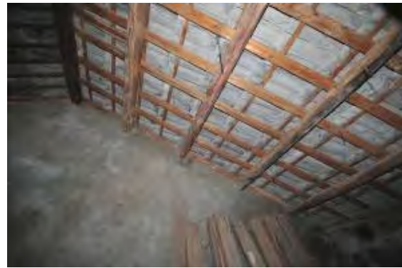
照片 5-3-94 後落屋架改建過
