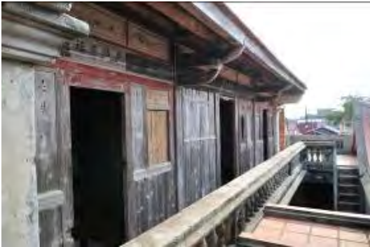
照片4-2-146 北山古洋樓二樓立面外觀
