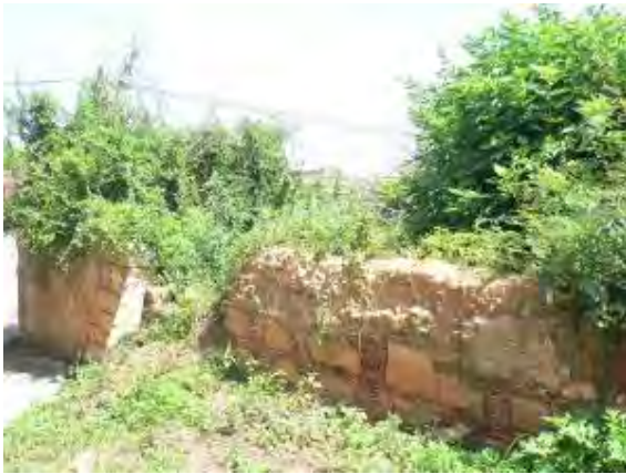
照片 5-2-4 歐厝 64 號左側牆體殘蹟
