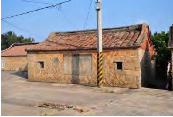
照片 5-2- 50 後落背側立面
