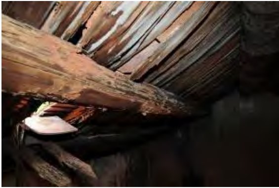
照片 5-3- 169 後落正廳前一架嚴重蛀蝕
