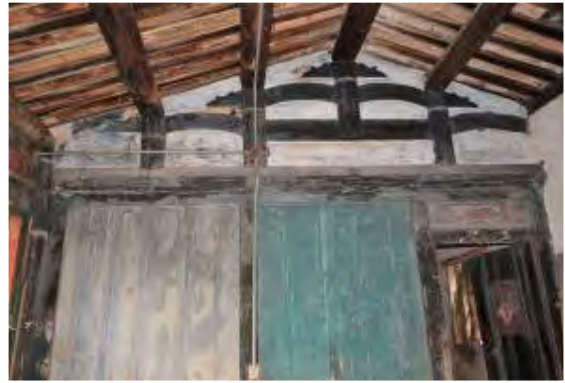
照片 5-7-8 前落左側穿斗式木構架
