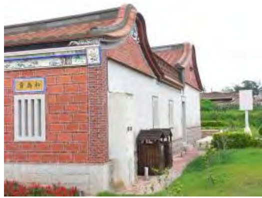
照片4-2-35 北山13號整修完成之左前側外觀
