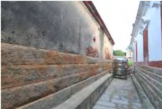
照片 5-1-14 牆基為花崗石牆身磚造灰壁
