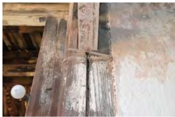
照片 5-1- 113 正廳左前柱中央劈裂材質良好
