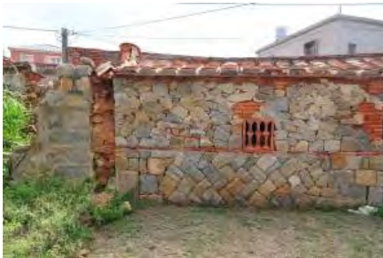
照片5-5-13 右護龍後寮牆花崗石牆體
