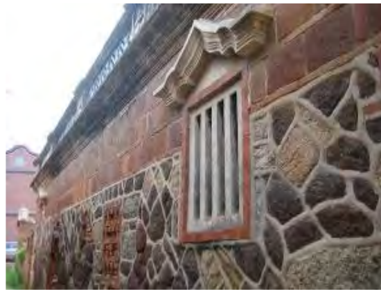
照片 5-3- 144 強面局部損壞，窗戶及裝飾線角、雨庇良好
