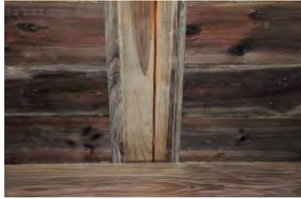
照片 4-2- 66 左擡頭左二駕下緣全根劈裂
