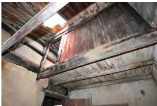
照片 5-3- 105 左次間現況全景
