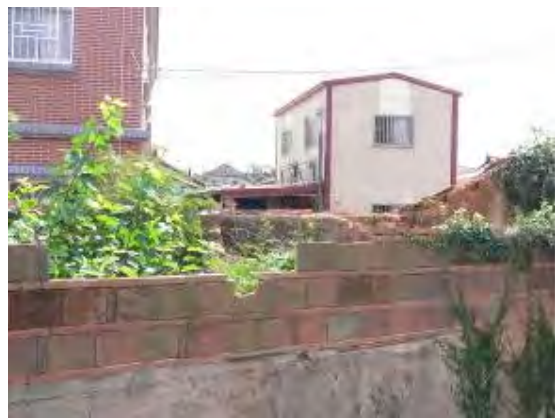
照片 5-3- 122 倉庫屋頂坍塌、外牆現況良好(二)
