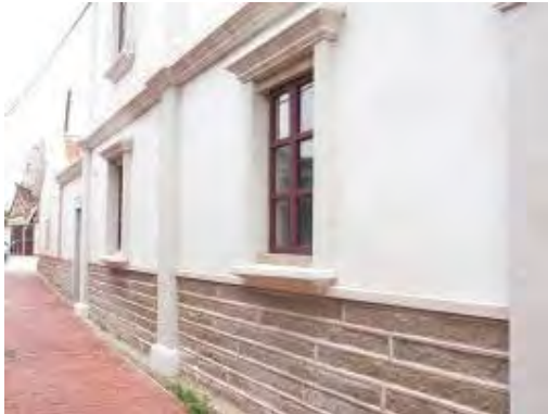
照片4-2- 103 整修完成之右側一樓外觀
