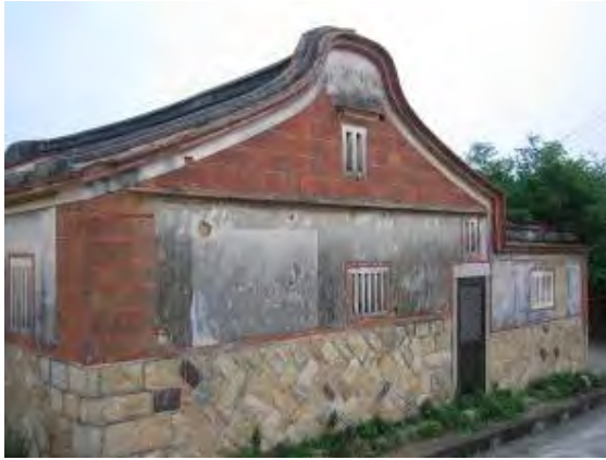
照片 5-4-3 右後側立面外觀
