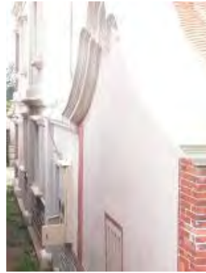
照片 4-2- 110 整修完成二落左側外牆
