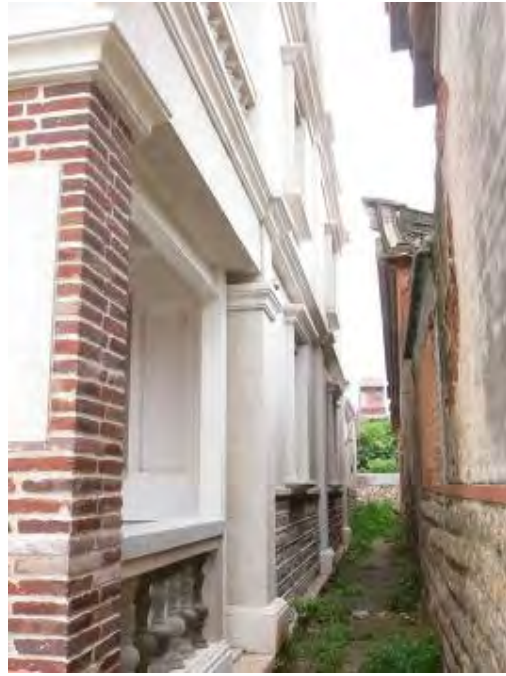
照片 4-2- 85 北山 23-3 號整修完成之左側外觀
