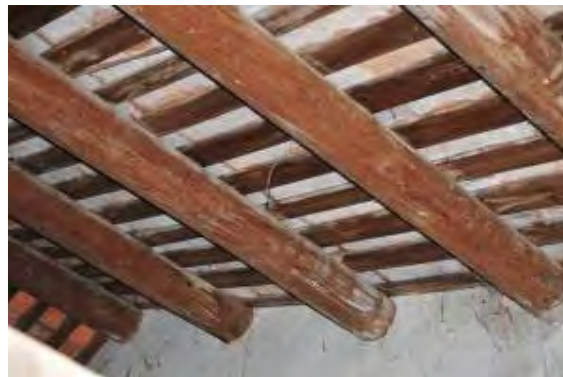
照片 5-1- 279 右次間椽仔端部輕微腐朽
