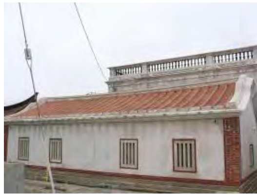
照片 4-2- 87 整修完成之背牆全景外觀
