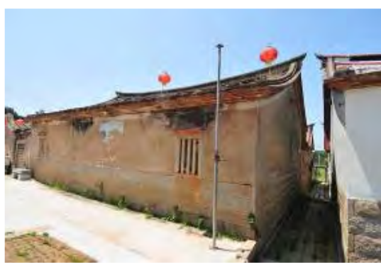
照片 5-1-47 水頭 9 號與鄰棟間之巷道
