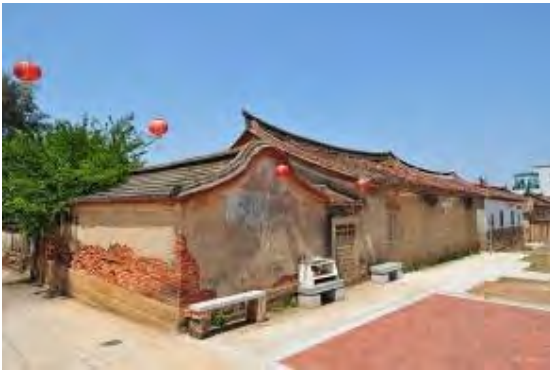
照片5-1-50 左側廂房及後落後寮牆
