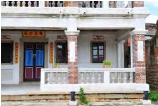
照片4-2- 90 五腳基之磚柱
