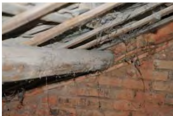
照片5-6-21 前二架直徑過小與壁體接合局部蛀空
