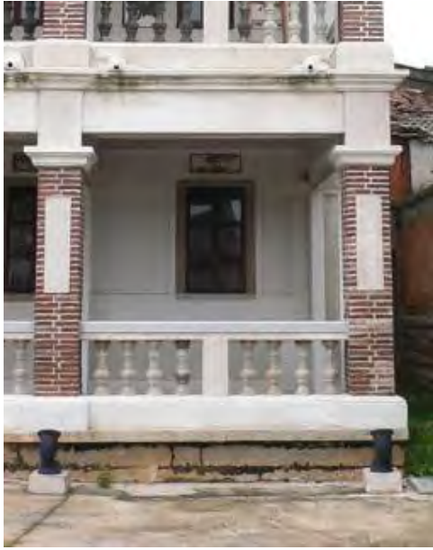
照片4-2- 101 整修完成之左前外觀
