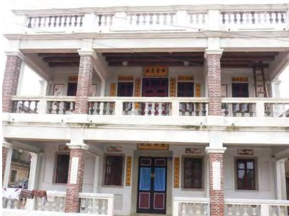
照片 4-2- 83 北山 23-3 號整修完成之立面外觀
