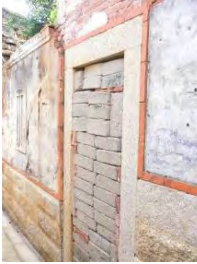
照片 5-1- 256 左後房側門砌磚封閉
