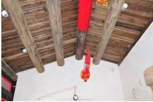
照片 4-2-190 前落屋架現況良好
