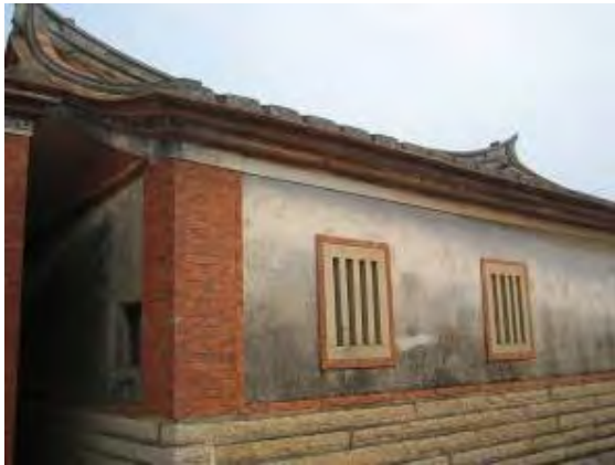
照片 5-3- 147 後牆面及牆堵現況良好
