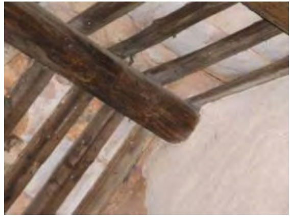
照片 5-1- 334 左中脊有腐朽現象
