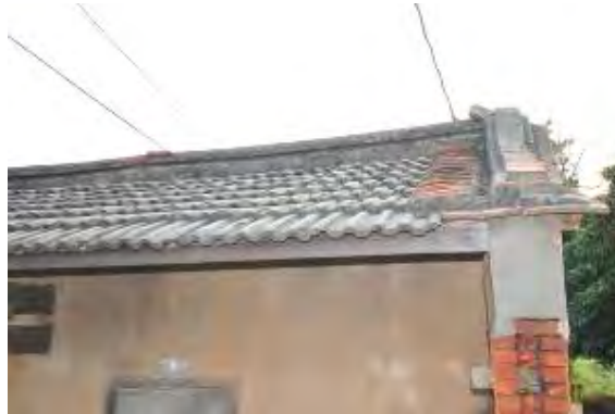
照片 5-1-15 屋頂已改為水泥瓦
