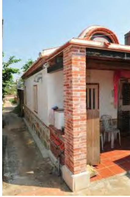
照片 4-2- 10 南山 84-1 後落右側入口
