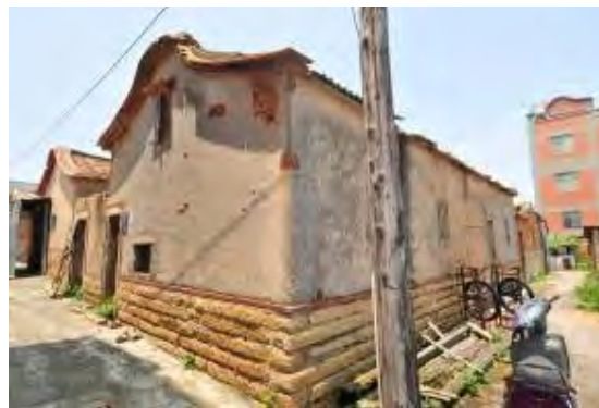
照片 5-6-2 左側大規壁與後側牆體
