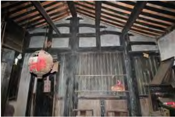
照片 5-7-7 後落右側穿斗式木構架
