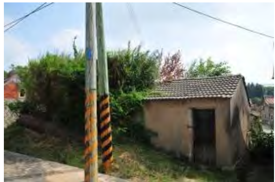
照片 5-2-7 歐厝 64 號右後增建物
