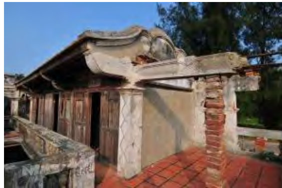
照片 4-2- 131 洋樓二樓外觀
