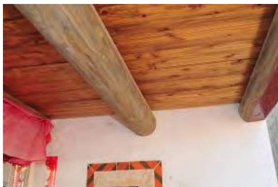
照片 4-2-26 後落右側入口磚平下木樑良好
