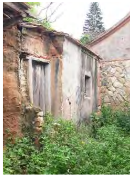
照片 5-7-16 左凸規前方壁體坡損
