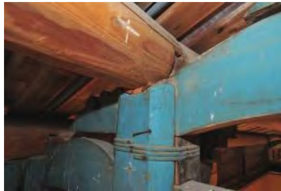
照片 4-2- 171 二樓左構架前瓜柱無明顯損壞
