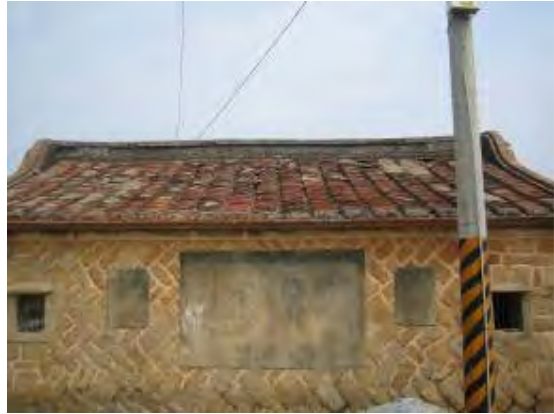
照片 5-2- 43 背牆立面，水泥修補標語塗面
