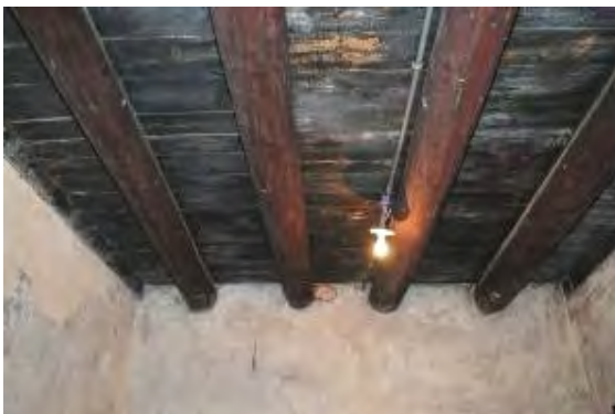
照片 4-2- 158 明間左側樓板木楹
