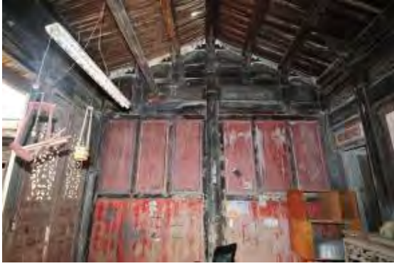
照片 5-3-25 後落之穿斗式木構架
