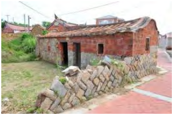
照片5-5-9 左護龍正面及花崗石圍牆牆基
