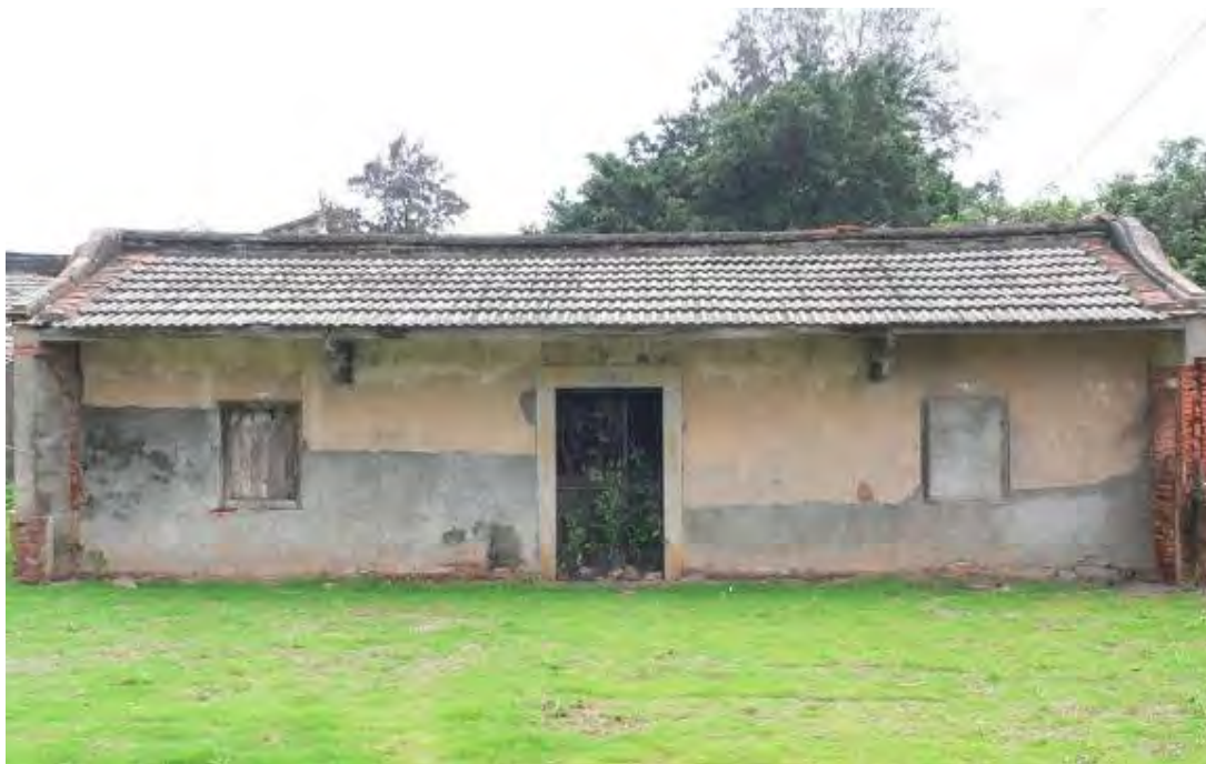
照片 5-1-1 水頭 7 號立面外觀
