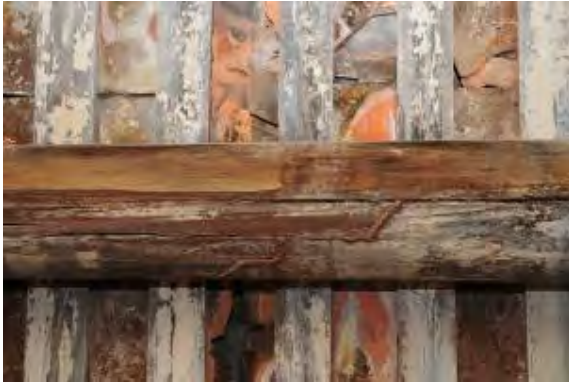
照片 5-1-26 水頭 7 號明間後一架蟻路外露
