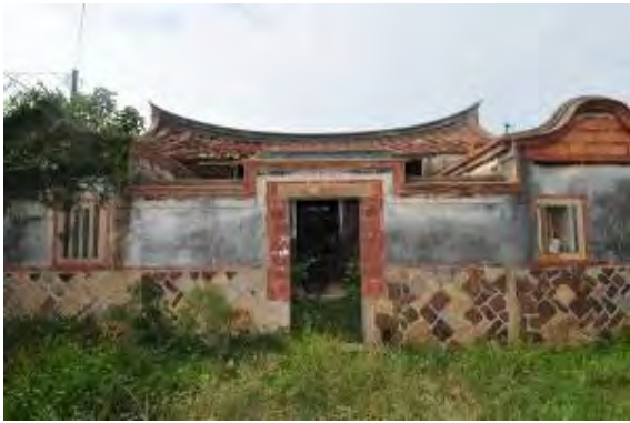
照片 5-3- 127 瓊林 110 號立面入口
