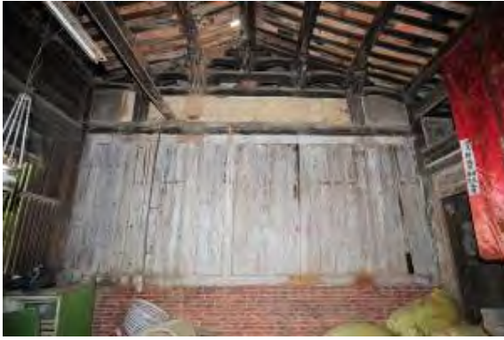
照片 5-3- 125 正廳右側原有牆面構造全景
