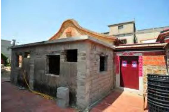
照片 5-1- 299 正身左側之 RC 增建物
