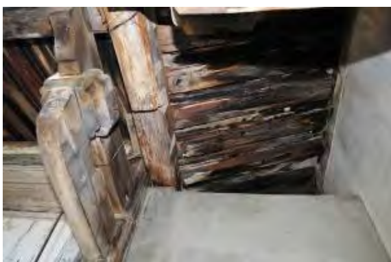
照片 5-1-96 左擡頭與前落挑檐間之暗厝嚴重損壞
