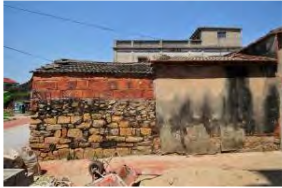
照片 5-1- 306 左擡頭之外牆面及尾擡之水泥屋面
