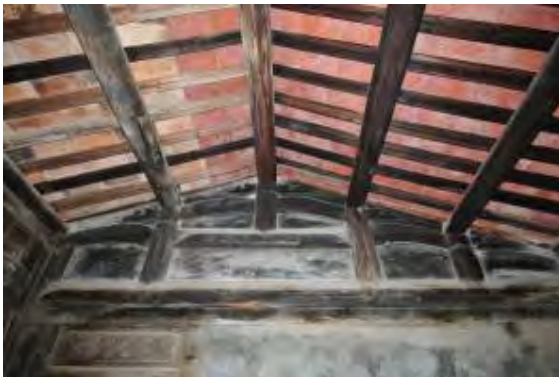
照片 5-3- 85 前落左側木構架與屋架
