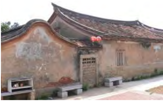
照片5-1-42 建物背面門洞封閉
