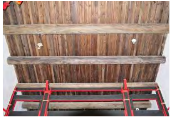
照片 4-2- 197 後落屋架與壽屏
