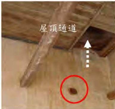
▲圖 4-67 牆壁中被截斷的楹樑痕跡
