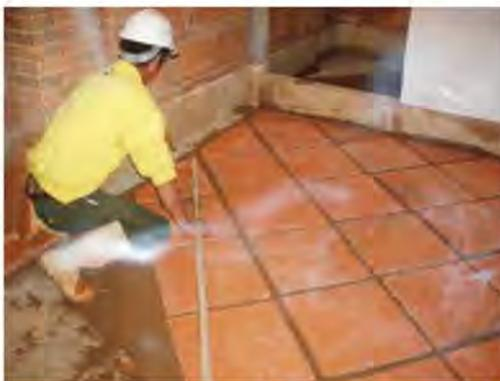
▲圖 6-60 依中心線鋪設水平與垂直線
