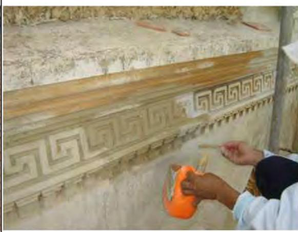
說明：簷板萬字泥塑不斷邊線條脫落修補。
