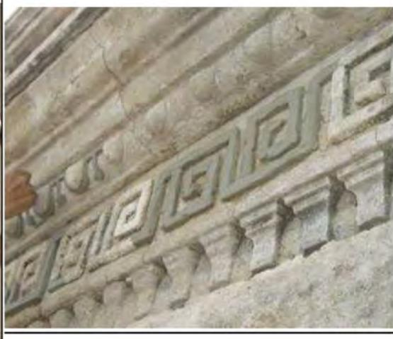
說明：簷板萬字泥塑不斷邊線條脫落修補。
