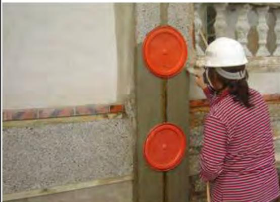
說明：圍牆柱面蠣殼加玻璃粉刷完成。
