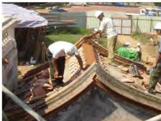
▲圖 6-47 瓦槽鋪設情形
