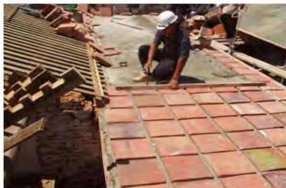
▲圖 6-62 長木條作板尺工具，控制向度
