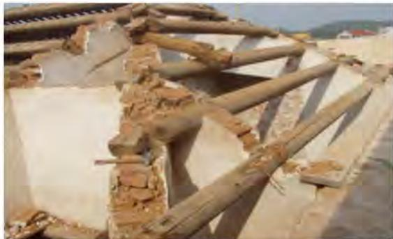
▲圖 6-25 屋面拆除時，須保留原有櫳孔部份
