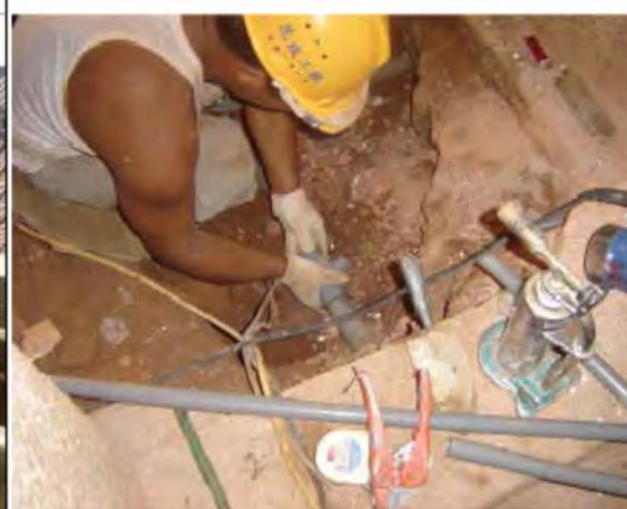
說明：水電埋設空調排水管。
