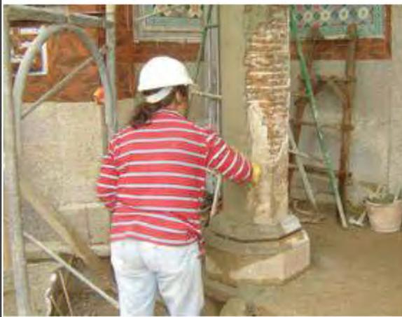
說明：一樓凹壽六角柱面水泥砂漿打底。
