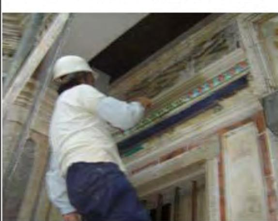
說明：正廳水車堵線板損壞修補。
