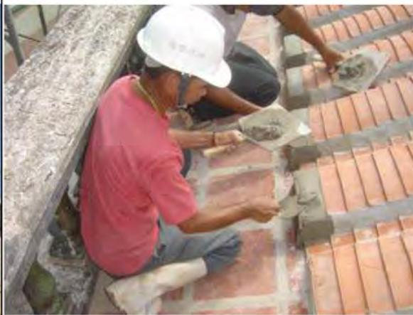
說明：瓦槽頭石灰砂漿粉刷。
