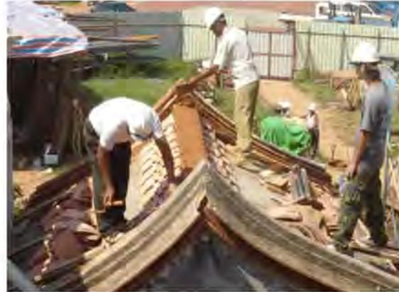
▲ 護龍明間屋頂板瓦拆除重作(鋪瓦養及三合土)。
