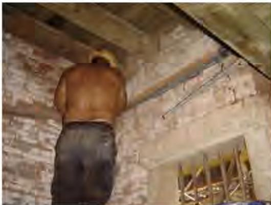
▲ 水電工程(埋設電線管)。
