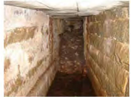
▲圖 4-18 坑道側壁的構造是延續地面得月塔樓，牆基花崗石鑿面之基體。雖為地道空間，但仍有砌礫石收腳之傳統作法。
