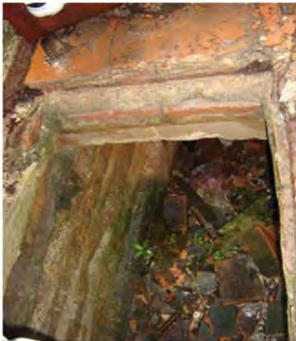
▲圖 4-7 從坑道入口看頂版構造
