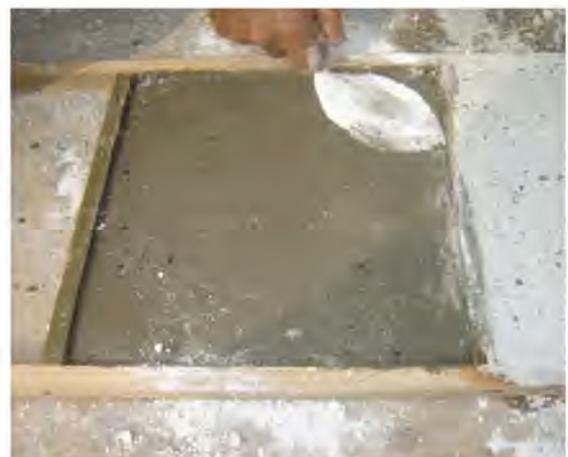
▲圖 6-66 養灰後，塗抹於地板
