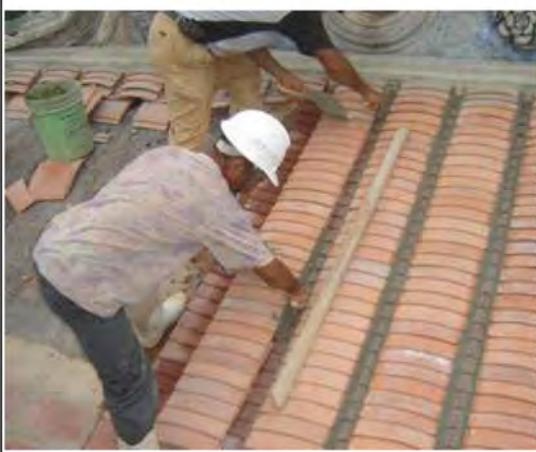
說明：瓦槽溝石灰砂漿粉刷。
