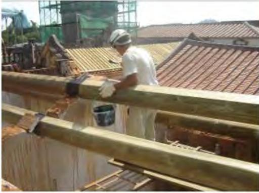
▲圖 6-18 拆卸時，須留意楹端之蟲蝕狀況
