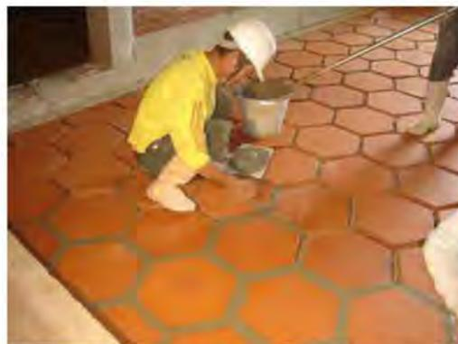
▲圖 6-61 砂漿填縫後，管制待乾
