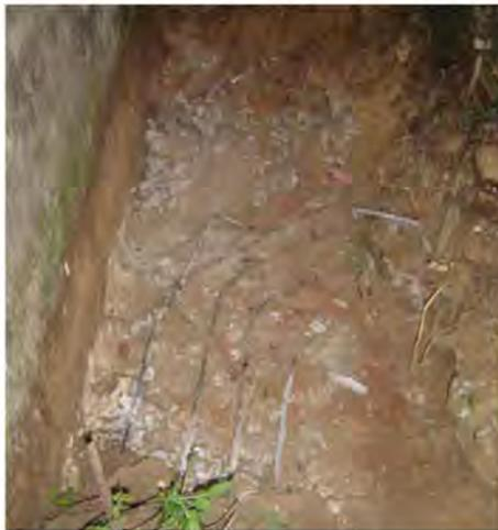
▲圖 4-43 坑道頂板的鐵筋構造
