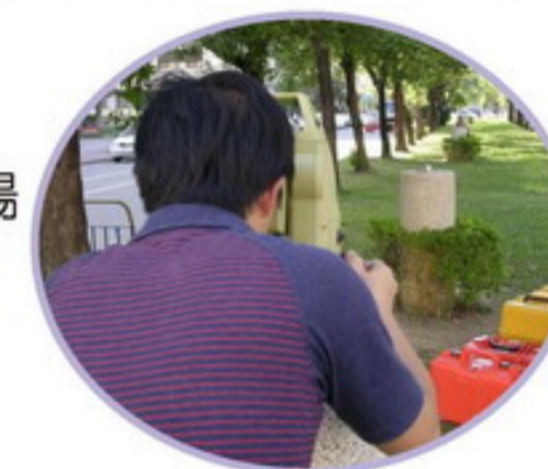
圖4-82 固定基座基線場
