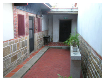
護龍休憩空間綠化狀況
