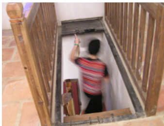
俯瞰槍樓木梯
