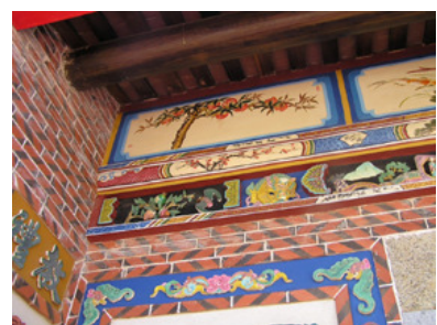
建築立面細部 2
