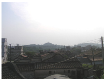
洋樓俯瞰聚落
