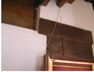
屋頂漏水臨時截水設施
