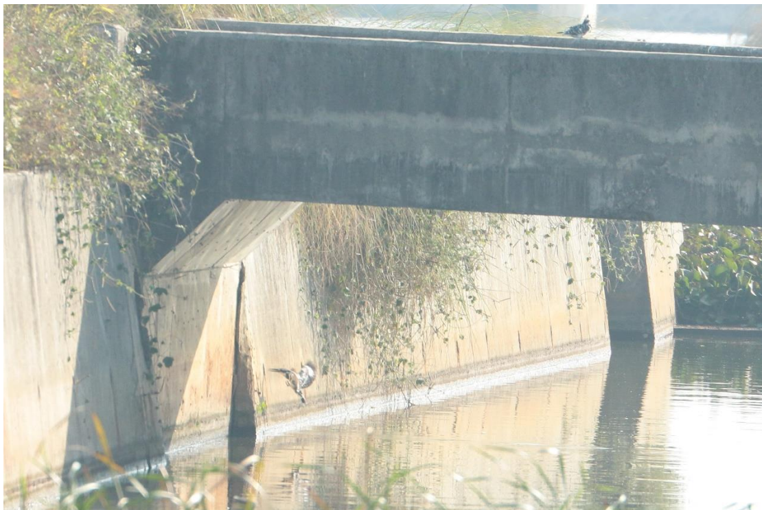
圖 4-6 進入水泥擋牆排水孔巢洞的斑翡翠 - 金湖水庫
