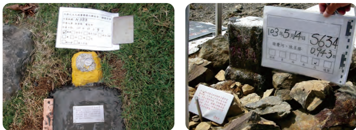
▲ 圖 4-2 永久測量標標示牌巡查及補建作業情形
