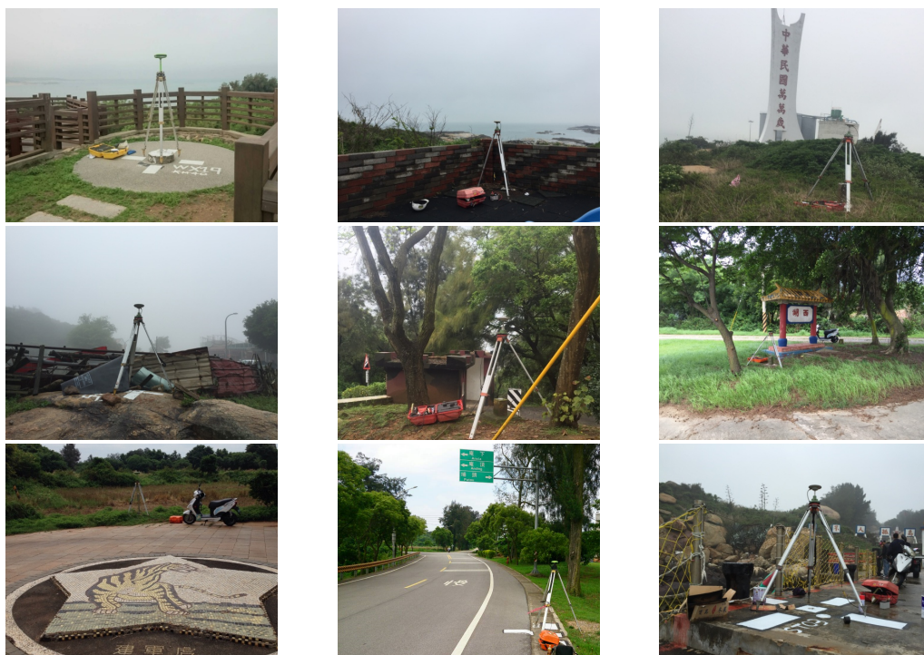
圖 4-4 GNSS 衛星定位測量作業情形
