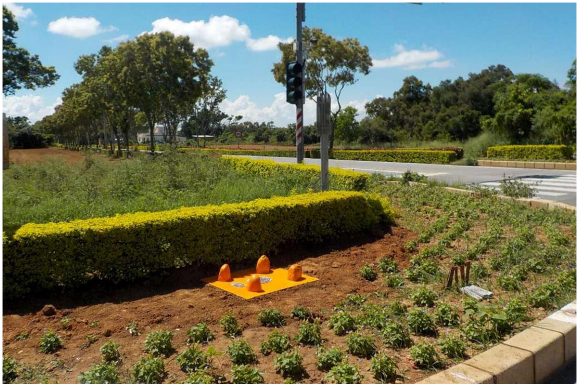
圖 2-4 一般地面一等水準點埋設結果
