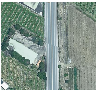
(a)道路錯移修正前
