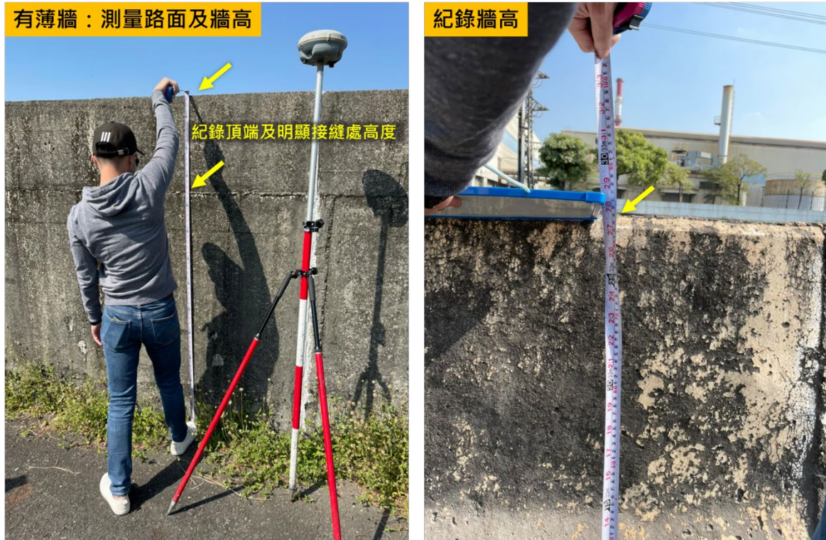
圖 8.13 外業檢核薄牆測量記錄說明
