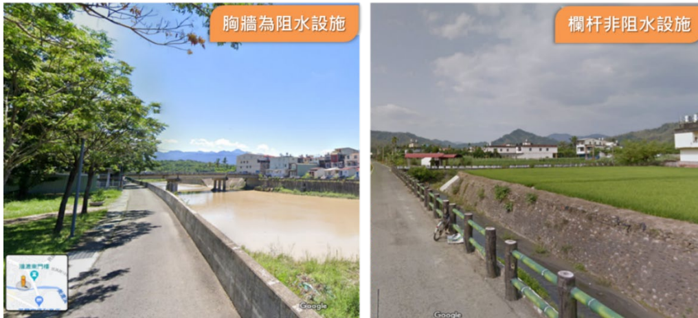
圖 3.7 阻水設施與護欄
