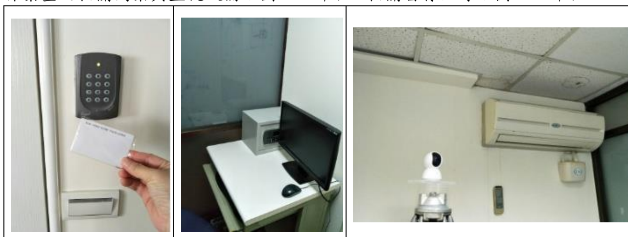
圖 3-3、機敏作業室之相關門禁與監視設備及監視器影像存檔紀錄
