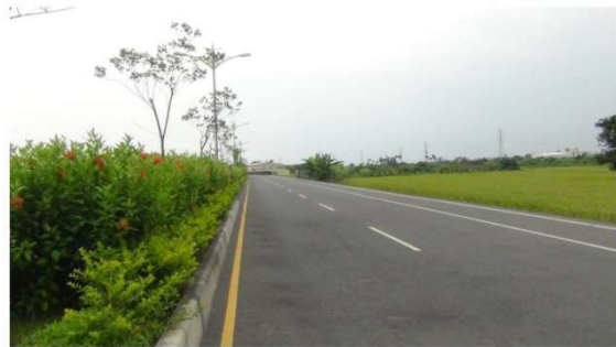
圖 2.起降場地跑道，台 14 丁。(朝北方，目標區位於後方位置)
