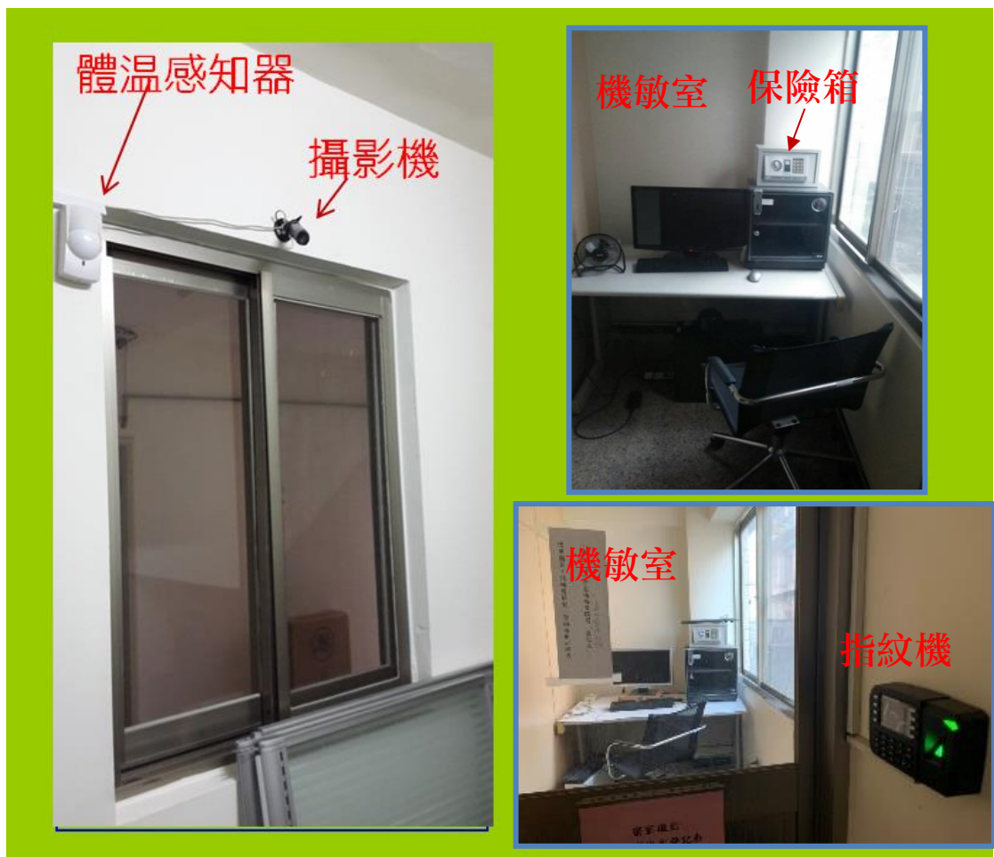
圖 2-9 亞新公司機敏室設置照片
