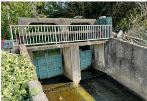
(a)中大型閘門(分類註記)
