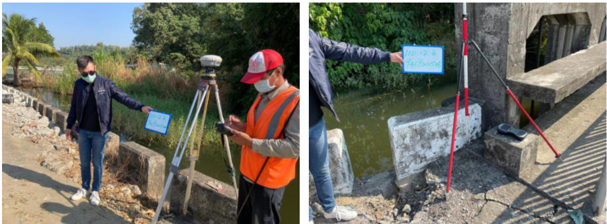
圖 6.13 驗收點現地道路塌陷
