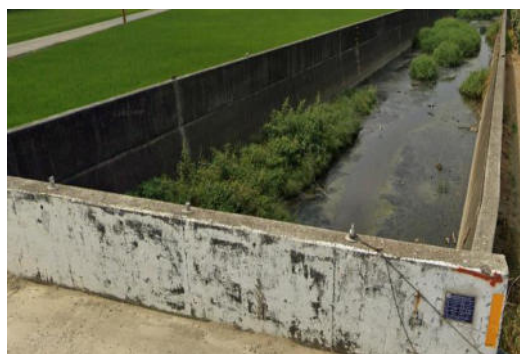
(a) 水利結構物_溝渠立面
