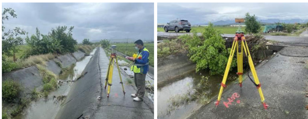
圖 4.2-11 e-GNSS 檢核溢堤線
