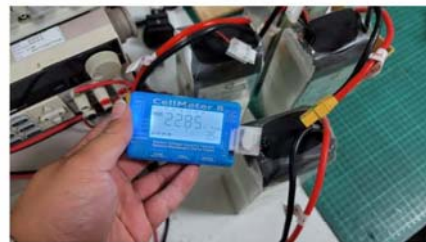
電池外觀 & 電池電壓
