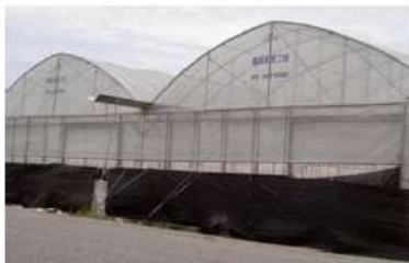
防颱溫室外觀結構
