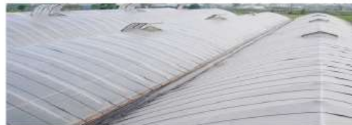
防颱溫室屋頂增設天窗系統
