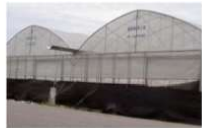
防颱溫室外觀結構
