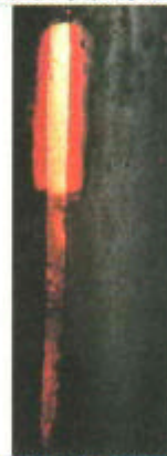
圖 14 以濕式清潔方法清潔興濟宮柱子，原被油煙及灰塵覆蓋的金箔及柱子原色立現
