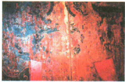
圖 2 彩繪顏料層剝落
