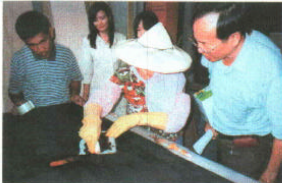
圖 25 文資中心同仁於興濟宮古蹟修復現場教導工地人員學習日本彩繪濕式清潔方法
