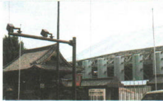
圖 11 日本西本願寺修復現場之保護工程
