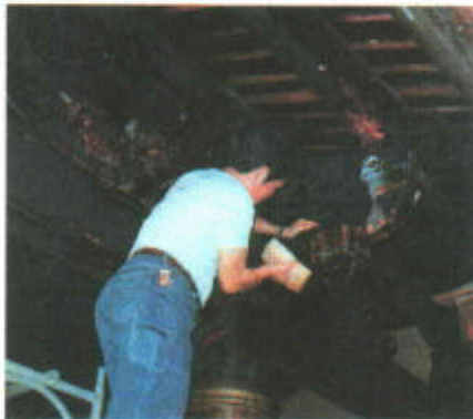
圖 27 傳統匠師直接以鹼粉調水後進行之彩繪清洗
