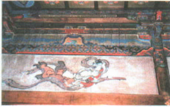
圖 9 日本兵庫縣勝福寺修理後之彩繪，為防止建築震動造成彩繪受損而研究採取可活動式之嵌板方式
