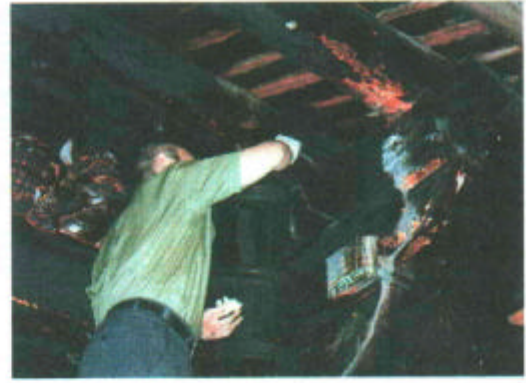
圖 18 與文資中心同仁們於興濟宮大觀音亭古蹟修復工程現場針對將拆除不保留之 R.C. 油漆彩繪示範清潔及暫時性加固方法
