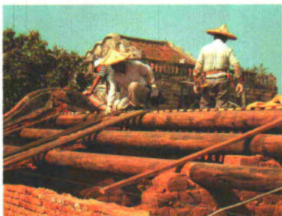
圖 1 屋頂木架構施作
