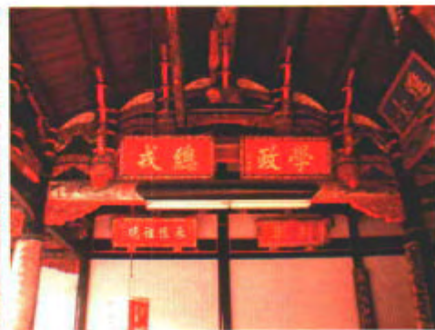
圖二十八：正殿棟架（四柱三通四瓜一獅座） （後浦陳氏大宗祠）
