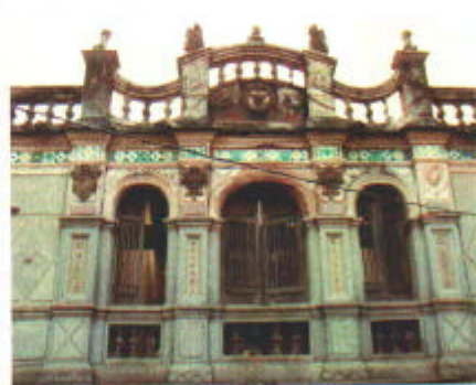
圖五十：女兒牆欄杆及圓拱外廊 (浦邊碧月軒)
