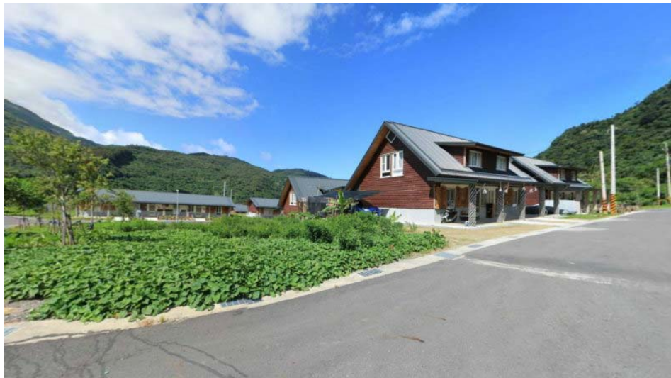
圖 4-62 臺東縣大武鄉重建區現地情形
