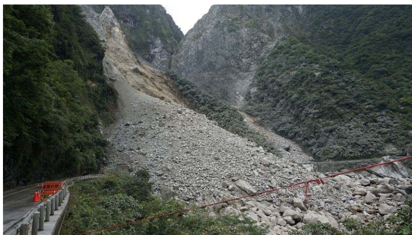
圖 4-3 現場崩塌狀況
