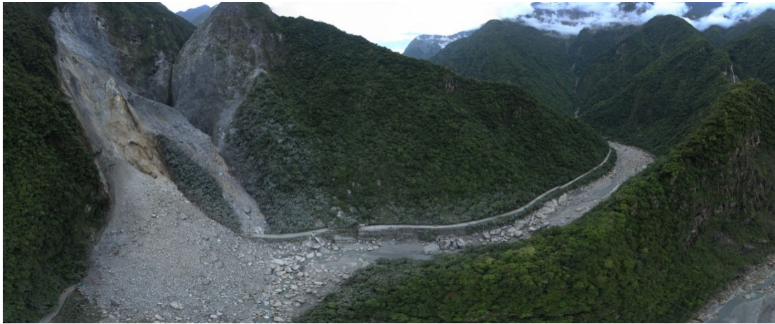
圖 4-6 邊坡崩塌區域側拍拼接影像
