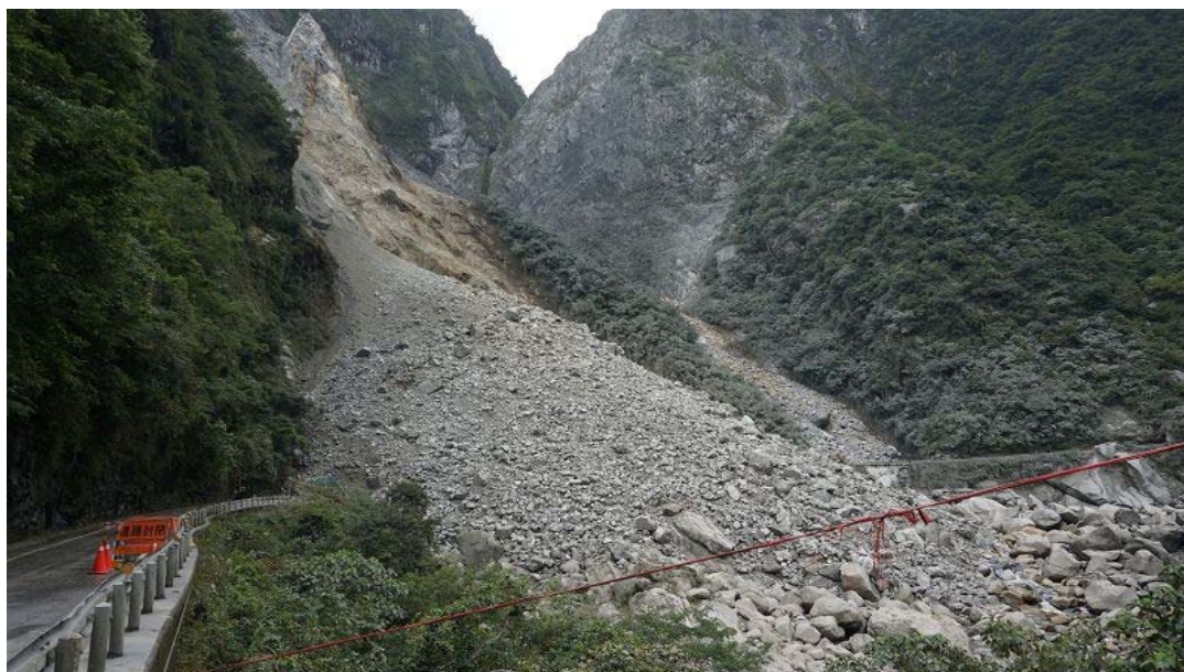
圖 1 現場崩塌狀況
