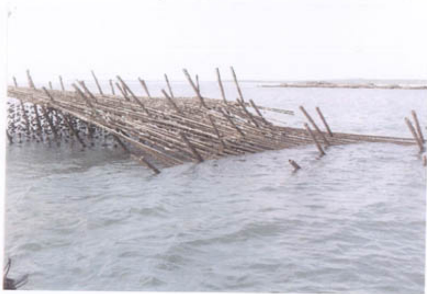
圖五、深水棚架式遭受颱風侵襲損壞之情形
