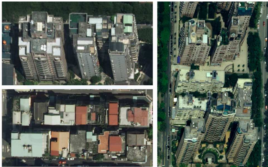
圖 2-30 正射影像建物傾斜狀況
