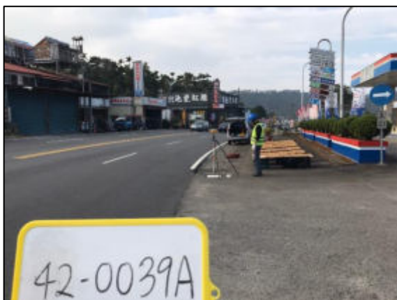
圖 2-19 平差控制點 VBS-RTK 工作照
