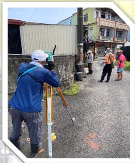
圖 3 -13 辦理現況測量作業情形
