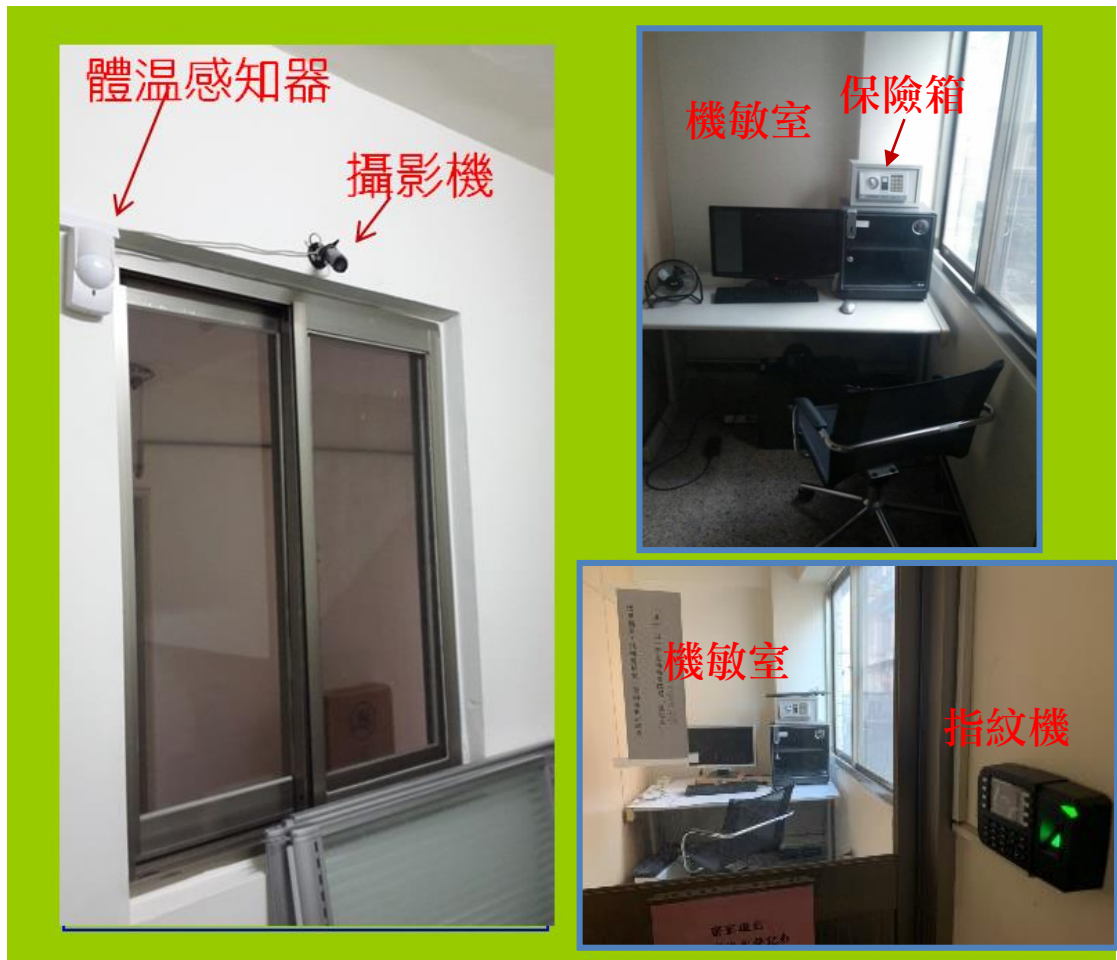
圖 2-9 亞新公司機敏室設置照片
