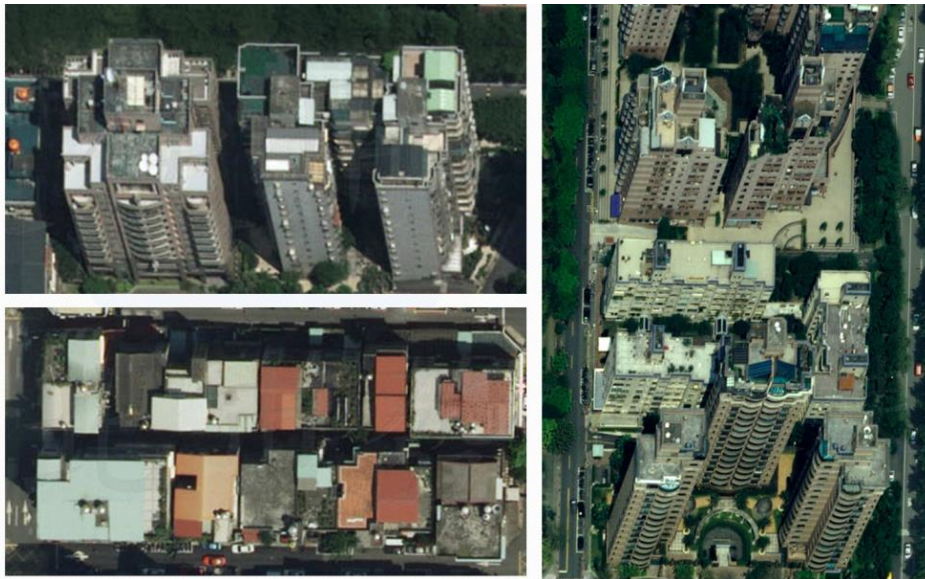
圖 3-37、正射影像建物傾斜狀況
